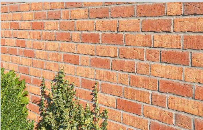
**Abb. 6:** Ziegel- und Klinkerriemchen sind grobkeramische Erzeugnisse und werden aus dem gleichen Material und in gleicher Technologie wie Verblendziegel (Oberbegriff für Vormauerziegel und Klinker) hergestellt.
