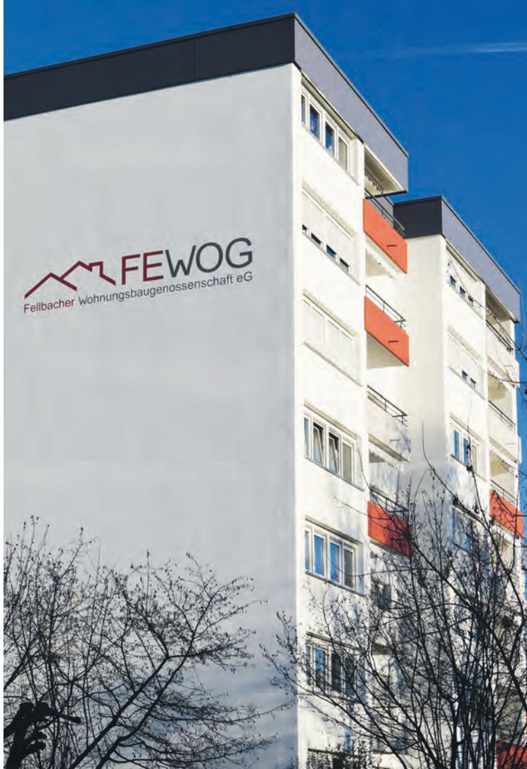
**Die Fassaden wurden vom Sockel bis zum Dach mit dem gleichen, nicht brennbaren Hochleistungsdämmstoff verkleidet**
