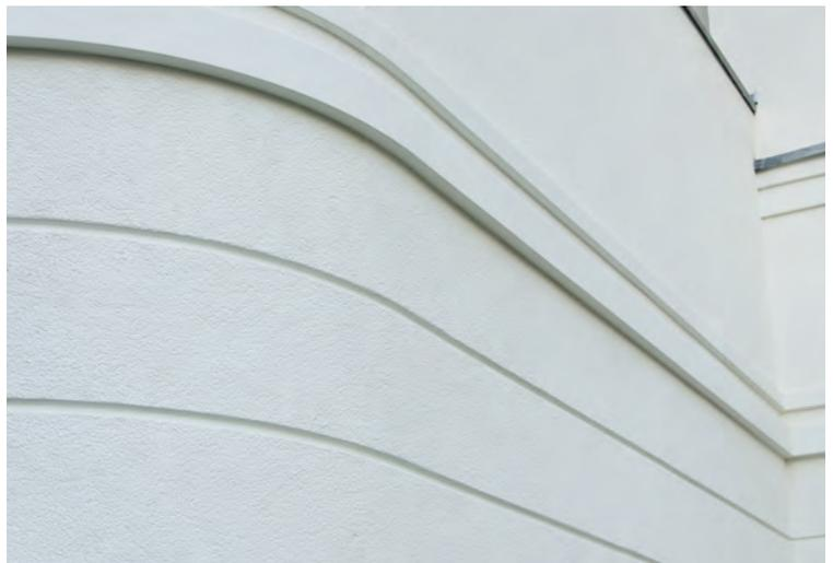
Die Bossennuten im Erdgeschoss wurden vor dem Aufbringen der Armierungsschicht in die vollflächig verklebten Dämmplatten eingearbeitet. Nur so konnte die gewünschte Linienführung mit den vordefinierten Abständen erreicht werden
