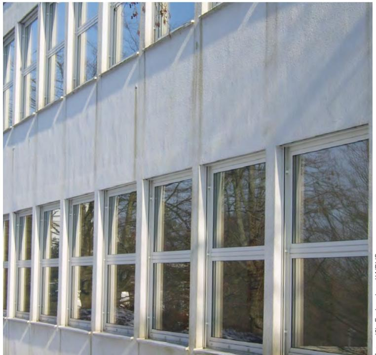
Abb. 1 und 2: Ungünstige Wasserführung kann zu Schmutzläufern führen
