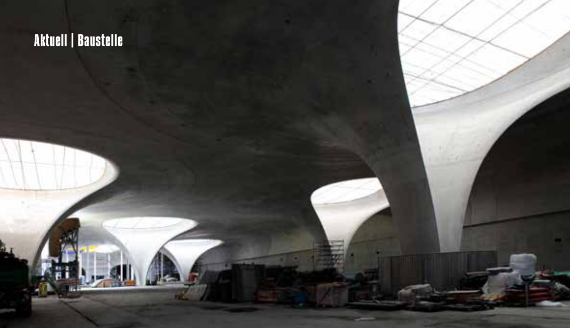
Im südöstlichen Abschnitt konnten die Kelchstützen schon zum Dach vereinigt werden
