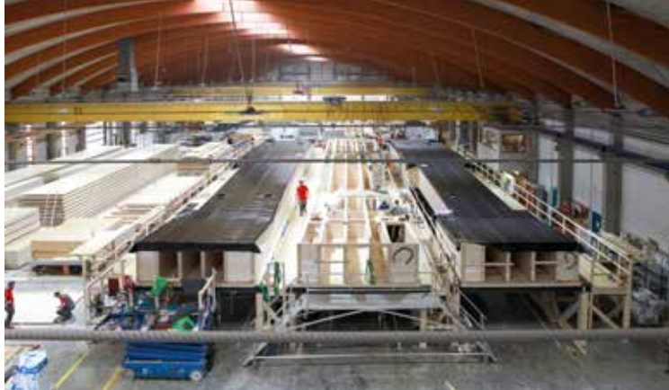
Foto: Rubner Holzbau
