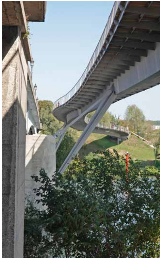
Die Pfeiler der Pont Neuf wurden für die Verankerung der Fußgängerbrücke genutzt, um eine eigene Gründung im Flussbett zu vermeiden. Eine Herausforderung war es, den Beweis zu führen, dass die Verankerung in den bestehenden Brückenpfeilern möglich ist
