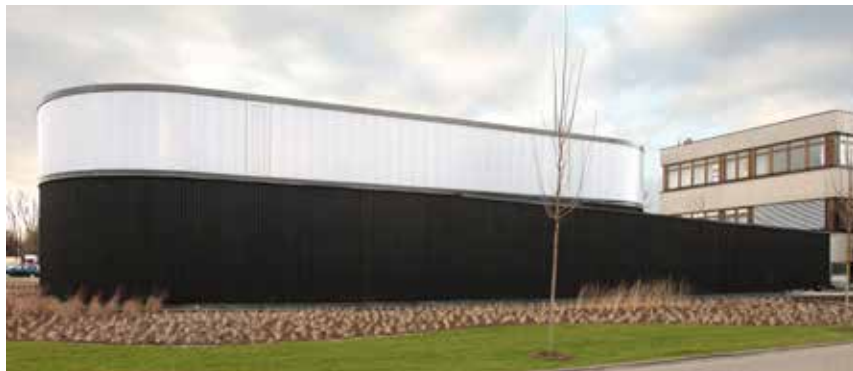
Mitten im Gewerbenie- mandsland: Architek- tur für eine Marke (mit Bestand rechts)
