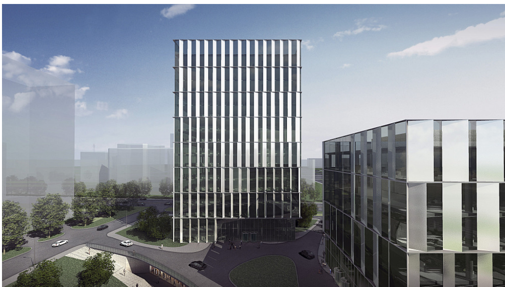
Renderings der Bürogebäude „Caohejing 3 Cubes“ in Shanghai, eine Komposition dreier Bürobauten. Die quadratischen, streng geordneten Gebäude stehen im Kontrast zur freifließenden Landschaft und Straße. Die Fassade wurde entwickelt durch parametrische Programmierung der Öffnungsgrößen, bezogen auf Himmelsrichtung, gegenseitige Verschattung und Qualität der Aussicht. Die Fassade ist weitgehend montiert. Abb.: gmp
