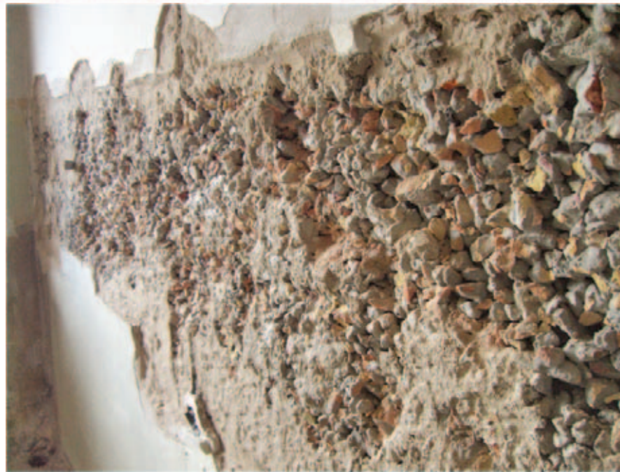
Abb. 9: Wand aus Schüttnbeton
