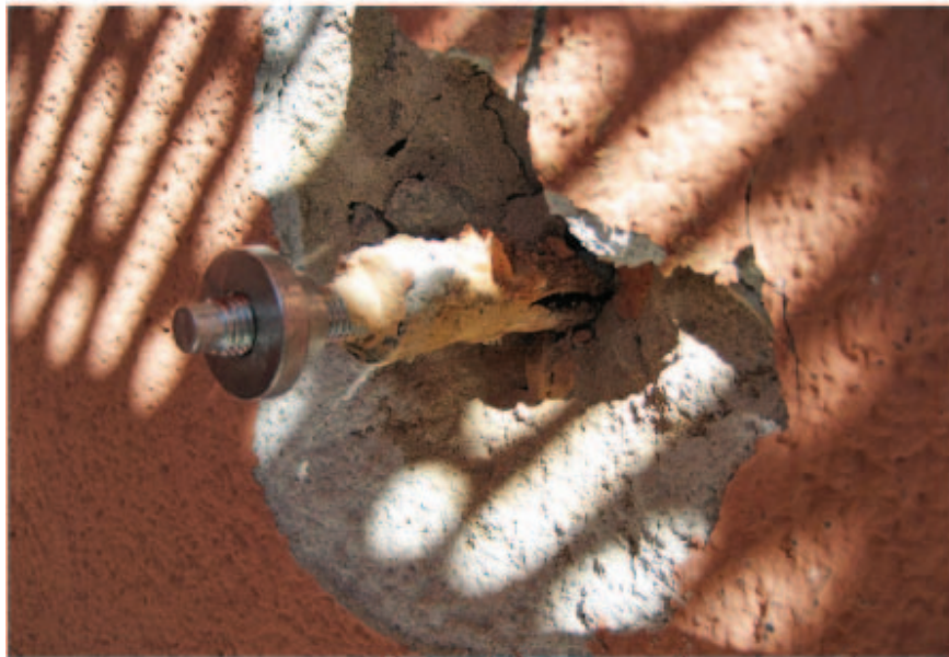
Abb. 41: Dübelauszugsversuche Aussenwand Bestand
