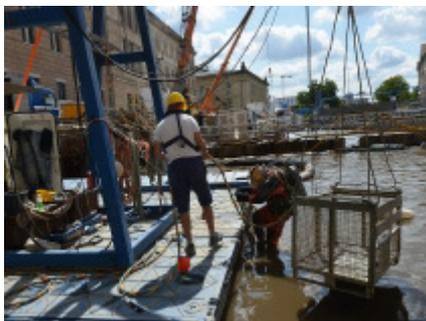
Tauchgang zur Entfernung der Zementsteinüberstände Quelle: © BBR / Foto: *Monika Fielitz*
