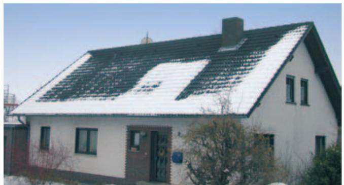
Die durch die Undichtheiten ausströmende Luft kühlt innerhalb der Baukonstruktion ab. Es kann sich Kondensat bilden, das sich in der Baukonstruktion ansammelt. Bauschäden sind die Folge. Die Feuchtigkeit erhöht außerdem die Wärmeleitfähigkeit des Dämmstoffes, was zu weiteren Wärmeverlusten führt.
