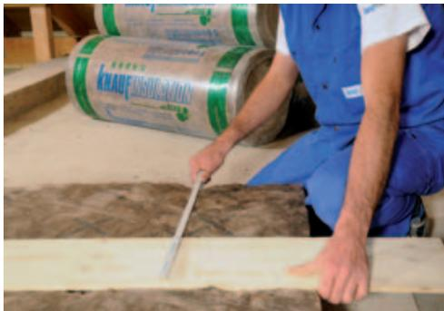
Messen Sie die lichte Breite zwischen den Sparren. Dämmstoff (hier: Knauf Insulation Zwischensparren-Dämmrolle UNIFIT TI 135 U mit ECOSE Technology) abmessen und mit einer Zugabe von ca. 10 - 15 mm von der Rolle abschneiden.
