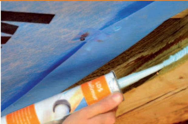
Fachgerechte Anschlüsse und die Verwendung aufeinander abgestimmter Systemkomponenten sind die Grundvoraussetzung für eine funktionierende Luftdichtheitsebene.
