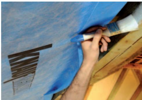
Voranstrich mit dem Knauf Insulation LDS Primer. Haftgrundiermittel auf Dispersionsbasis für poröse Untergründe.
