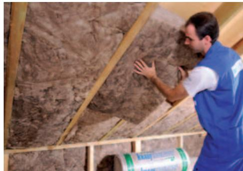
Die Mineralwolle-Dämmung muss fehlstellenfrei verlegt werden.
