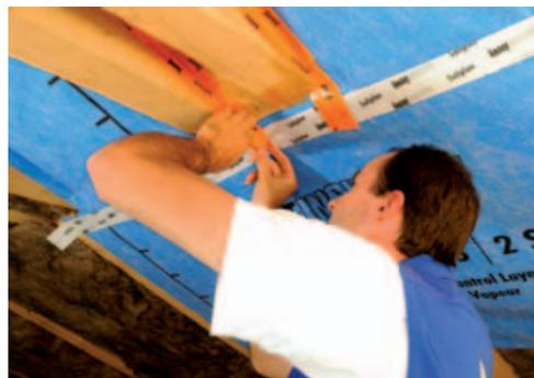
Knauf Insulation LDS Solitwin Haftklebeband mit geteiltem Abdeckpapier: Speziell für Eckverklebungen um Holzbalken herum und für Fensteranschlüsse geeignet.
