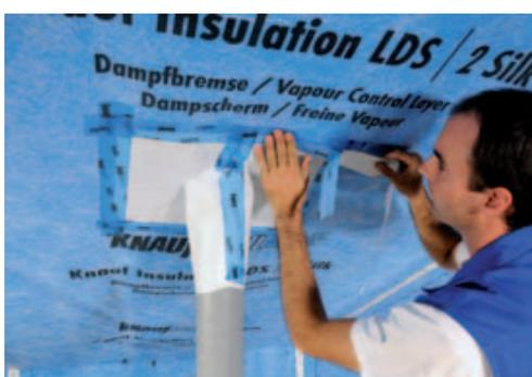
Die Verwendung der patentierten Knauf Insulation LDS Universalmanschette erlaubt die schnelle und komfortable Abdichtung, z.B. von Rohrleitungen.
