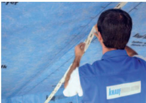
Die Überlappungen werden mit Knauf Insulation LDS Soliplan verklebt.
