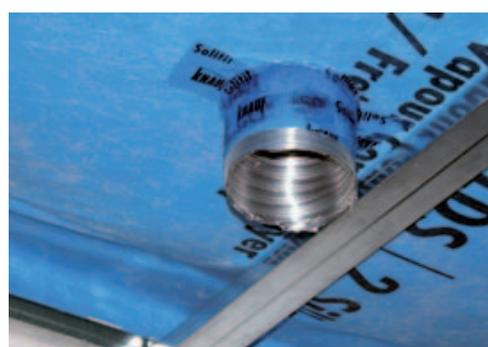
Rohrleitungen (hier: Lüftungsanlage) können ebenfalls mit dem Knauf Insulation LDS Solifit luftdicht abgedichtet werden.
