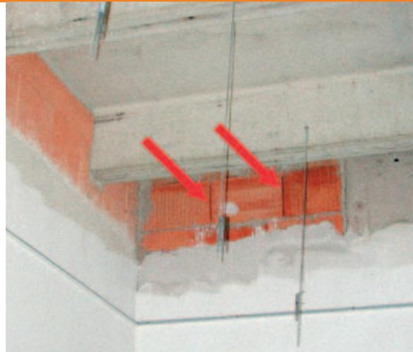
Mauerwerk muss verputzt werden, um ausreichend luftdicht zu sein. (Bild: Ing.-Büro n50, Torsten Bolender)
