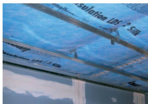
Dachausbau im System: Das zertifizierte Knauf Insulation LDS System gewährleistet in Kombination mit Knauf Trockenbau-Systemen (hier: Knauf Diamant) optimalen Wärme-, Brand- und Schallschutz.
