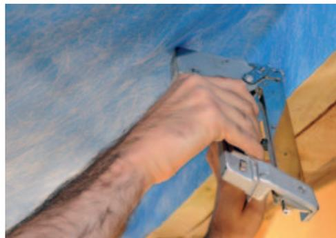
Die Dampfbremsbahn Knauf Insulation LDS 2 Silk wird an den Sparren festgeklammert.
