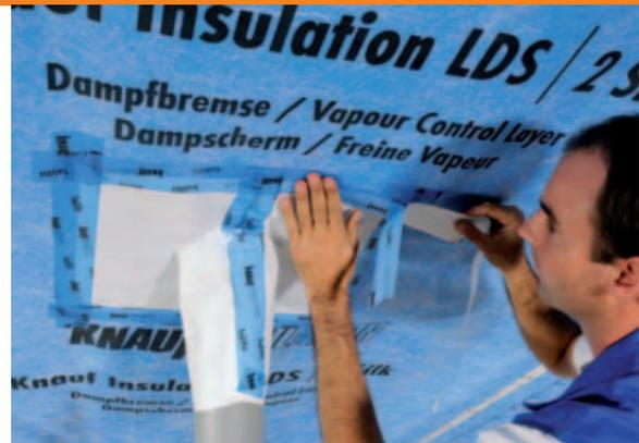
Durchdringungen der Dampfbremsbahn müssen fachgerecht abgedichtet werden. Der Einsatz einer Universalmanschette erleichtert die Arbeit beim Abdichten von Rohrdurchdringungen.
