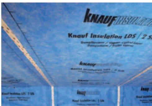
Dampfbremsbahnen in ihrer Funktion als Luftdichtheitsschicht sollen vor Montage der Innenwände verlegt werden.
