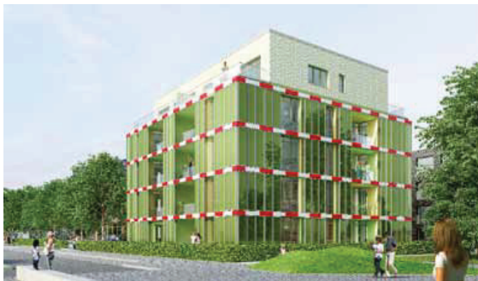
Das erste Algenhaus der Welt im Hamburger Stadtteil Wilhelmsburg, das BIQ, verfügt über etwa 200 m 2 aktiven Fassadenteil mit Bioreaktoren
