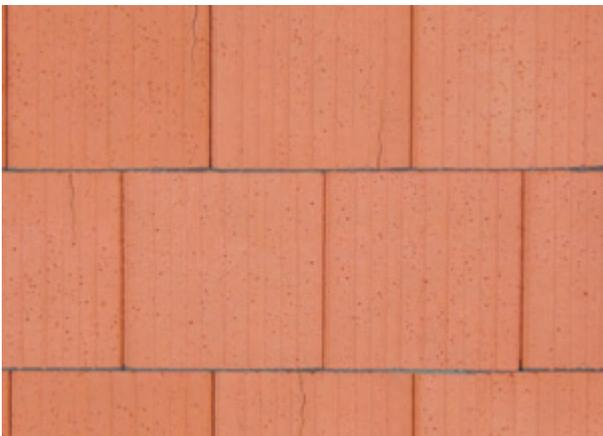
Bild 12: Ziegelmauerwerk mit Trocknungs- oder Brennrissen
