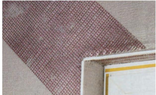
Bild 7: Armierungspfeil an Öffnungsecken
