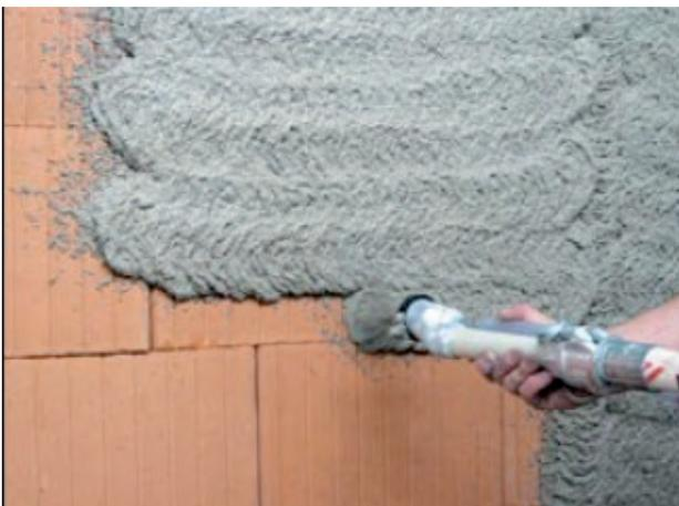
Bild 14: Auftrag des Unterputzes auf Planziegelmauerwerk
