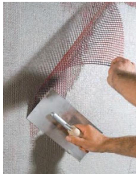
Bild 8: Armierungsputz mit Gewebeeinlage
