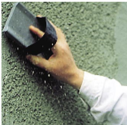
Bild 17: Kratzen des Oberputzes
