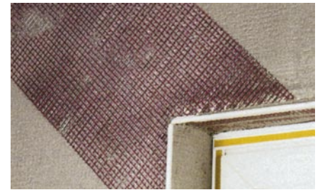
Bild 8: Beispiel einer Diagonalbewehrung
