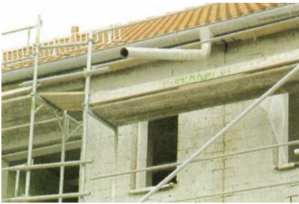
Bild 10: Ableitung von Dachflächenwasser
