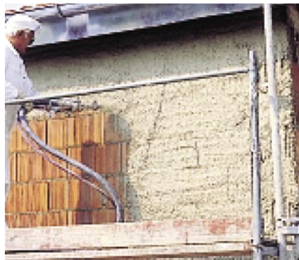
Bild 16: Aufbringen des Unterputzes
