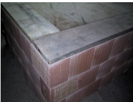
Bild 11: Abdeckung von Mauerkronen mit Gerüstbett (Bohlen o.ä.)
