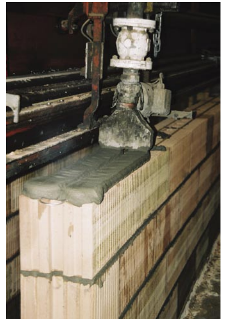
Bild 12: Vollflächiger Mörtelauftrag
