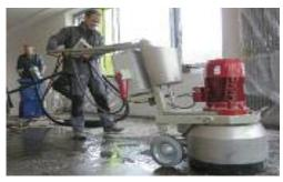
Schleifen und Polieren von Gussasphalt.
