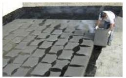
FOAMGLAS® Dämmplatten in Heißbitumen auf Betonplatte. Alternativ können FOAMGLAS® Platten auch auf einer zuvor ausgeführten Mastixschicht mit Heißbitumen verlegt werden.
