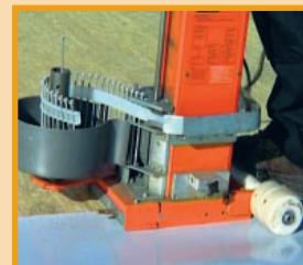
Die Verschweißung der Bahn erfolgt durch Heißluft oder Quellschweißmittel.
