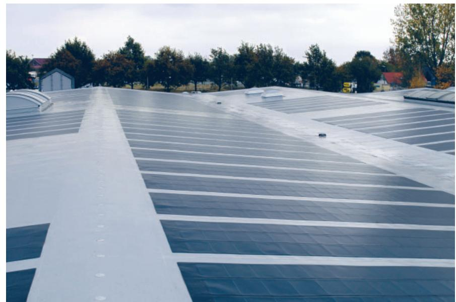
wassererdicht laminiert. Sie bestehen aus flexiblen Solarzellen in einer Größe von 240 x 340 mm. In Serie geschaltet und mit Bypass-Dioden zwischen allen Zellen sind sie allseitig witterfest und transparent polymerverkapselt. Von den drei übereinander liegenden Silizium-Zellen werden jeweils unterschiedliche Wellenlängen des Sonnenlichts genutzt, womit der Wirkungsgrad erhöht und konstante Erträge garantiert werden.
