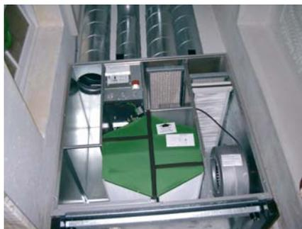
Zentralgerät einer Zu-/Abluftanlage mit Wärmerückgewinnung für ein Einfamilienhaus
