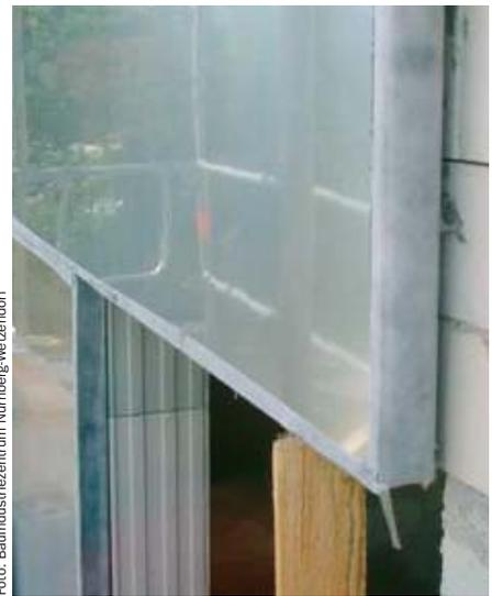
VIP-Dämmung im Bereich der Fenster
