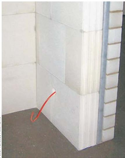
Modell einer zweischaligen Außenwand mit VIP-Dämmung
