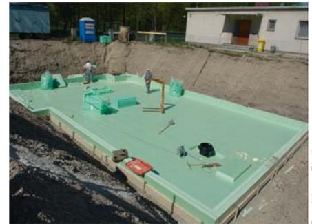
Dämmung unter Bodenplatte
