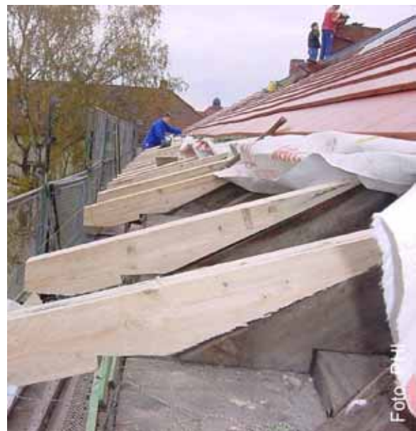
Abbildung 41: Links: Anpassung des Dachüberstands am Ortgang für die Wärmedämmung der Giebelwand mit Hilfe von U-Profilen zur Dachlattenverlängerung ( Quelle: Fleck GmbH ) Rechts: Verlängerung des Dachüberstands an der Traufe mit einem „Aufschiebling“ auf dem vorhandenen Sparren. Der Anschluss der Fassadendämmung an die Dämmung der obersten Geschosdecke kann ohne Lücke durchgeführt werden (Nürnberg, Jean-Paul-Platz, Architekt: Dr. Burkhard Schulze Darup, Nürnberg).
