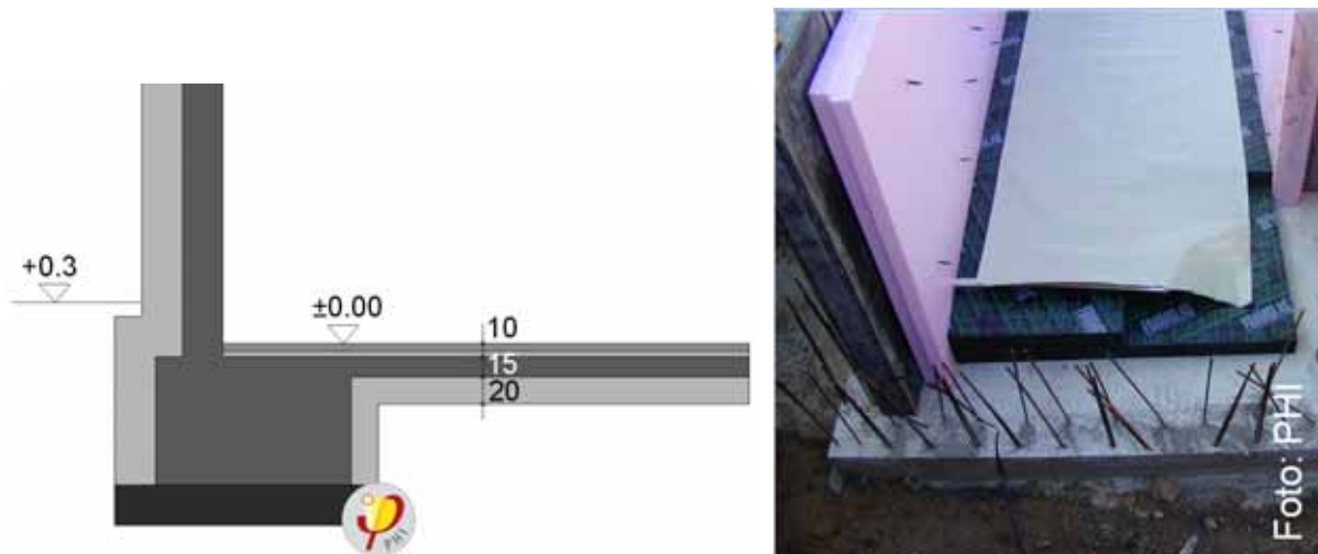
Abbildung 47: Umdämmung eines Streifenfundaments mit XPS (seitlich) und Schaumglasplatten (unterhalb) / Heinrich-von-Kleist-Schule, Eschborn Architektur: Heimel + Wirth, Frankfurt
