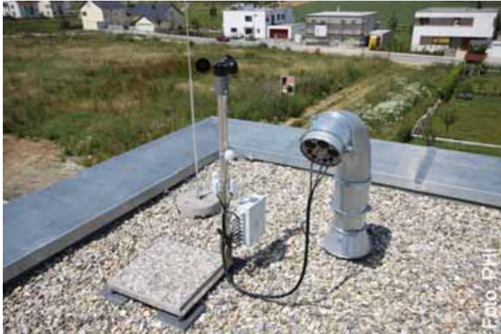
Abbildung 105: Wetterstation für Sonnenschutz-Steuerung. Sonnenschutzanlagen müssen über eine Wetterstation gesteuert werden. Der variable Sonnenschutz sollte für Windgeschwindigkeiten von mindestens 13 m/s ausgelegt sein [Linder 2009].
