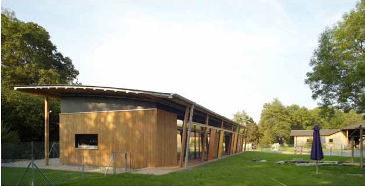
Abbildung 7: Auch kleinere, eingeschossige Gebäude erreichen den Passivhaus-Standard - allerdings mit etwas erhöhtem Aufwand Kinderkrippe in Lengdorf, Architekt: Gernot Vallentin (Foto: Gernot Vallentin)
