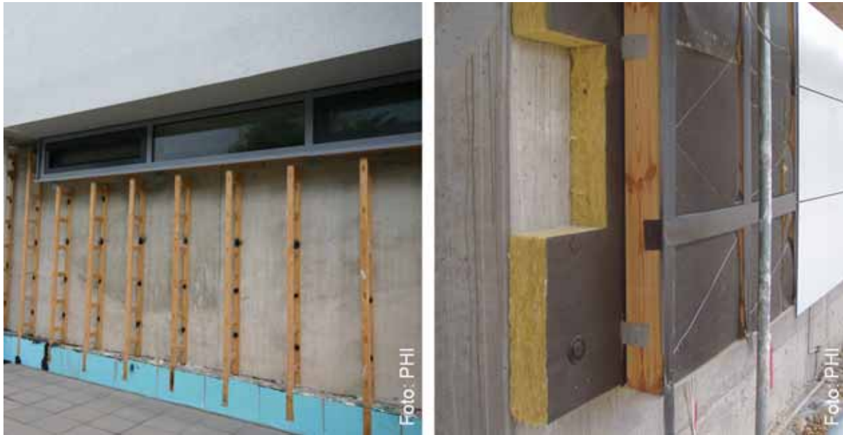
Abbildung 15: Links: Unterkonstruktion aus leiterförmig aufgelösten Holzstegträgern, Albert-Schweitzer-Gymnasium in Alsfeld. Architektur: BLFP, Friedberg.. Rechts: Holz-Metall-Unterkonstruktion
