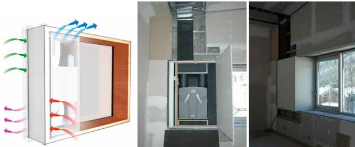
Abbildung 59: Fenster integriertes Lüftungssystem „LiLu“ (M. Tribus Architecture,(I) Lana). Das Lüftungsgerät mit Wärmerückgewinnung inkl. Filter und Schalldämpfer ist im Fensterrahmen integriert. Die Außenluft- und Fortluftöffnung sind im Fensterrahmen angeordnet. Schulerweiterung in San Vito di Cadore (I), Architekten R. Damian, C. Da Rin / Passivhaus-Architekt M. Tribus. (Fotos: M. Tribus)
