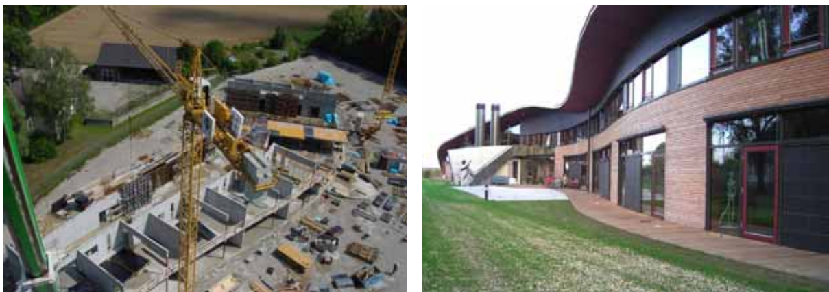
Abbildung 19: Montessori-Schule in Aufkirchen, Walbrunn Grotz Vallentin Architekten, Bockhorn. Links: Stahlbetonskelett. Rechts: Außenwand in Holzleichtbau. [AkkP 33] (Fotos: G. Vallentin)
