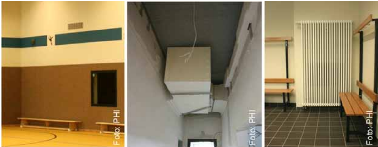
Abbildung 68: Umsetzung der Überströmung bei einer Passivhaus-Sporthalle in Reichelsheim. Die Hallenluft strömt im Bereich des Flurs durch einen brandschutztechnisch ertüchtigten Kanal in die Umkleiden. Ein Heizkörper erwärmt die überströmende Luft in den Umkleiden (Überströmöffnung befindet sich hinter dem Heizkörper). Architektur: Eigenbetrieb Gebäudewirtschaft Wetteraukreis & a5 Planung, Bad Nauheim / Haustechnik: DBH Bachmann, Bad Hersfeld.
