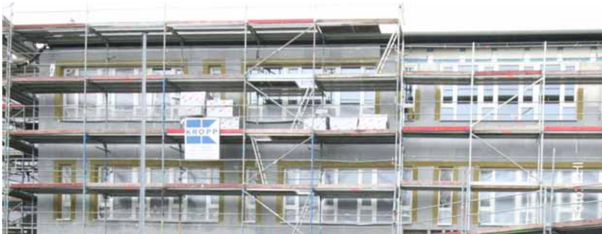
Abbildung 11: Albert-Schweizer-Gymnasium Alsfeld, Brandbarriere. Architektur: BLFP, Friedberg
