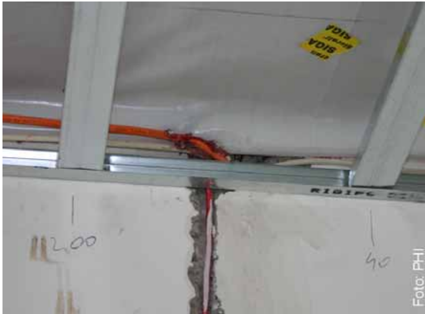
Abbildung 39: Die Kabelführung in der Wand ist unverputzt, obwohl der Dachanschluss mittels Folienverklebung bereits hergestellt wurde. [Peper 2004]
