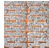
Das Calimax-Nut- und Feder-system ermöglicht knirsches Vermauern ohne Stoßfugenmörtel mit optimaler Wärmedämmung.
