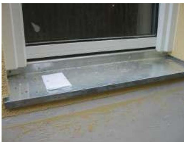
Abbildung 158: Austritt nach der Fertigstellung: Abdeckblech direkt an Schwellprofil angeschlossen
