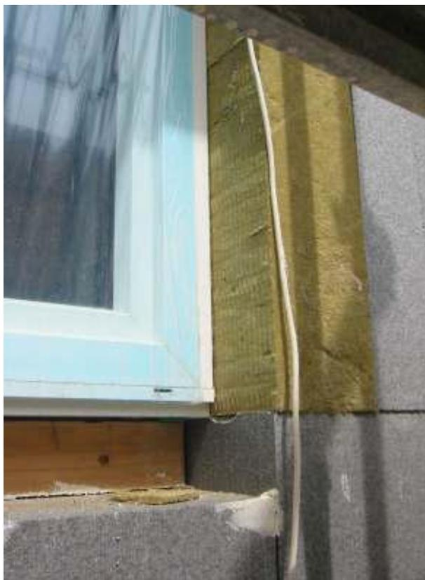
Abbildung 147: rEinbau04. Rollläden, Fenster in der Dämmebene platziert, unter dem Brüstungsprofil ein Kantholz 6 cm x 6 cm als Auflager.
