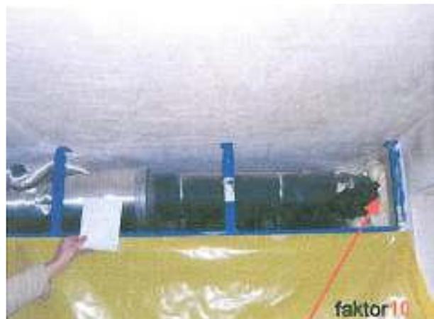
**Abbildung 218:** Die Deckenabkofferungen für die kalten Außenluft- und Fortluftleitungen wurden mit Zellulosedämmung ausgeflockt. Da sich so der Taupunkt aus der relativ dampfdichten Kanaldämmung heraus in die Zellulosedämmung verschob, musste die Abkofferung möglichst luftdicht ausgeführt werden. Fotos: [faktor10]
