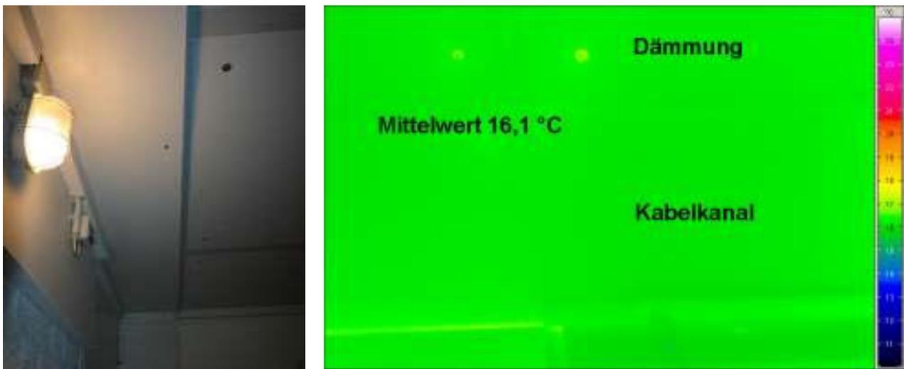
**Abbildung 196: Kabelkanal an der Kellerdecke zusätzlich von Dämmlage abgedeckt. Blickrichtung in beiden Bildern um 90° verdreht.**
