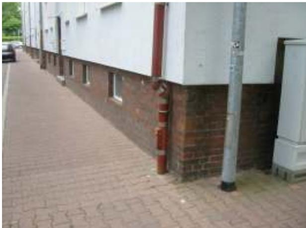
**Abbildung 78: So nicht: Kellersockel ohne Dämmung bei einer konventionellen Sanierung mit WDVS. Auf eine Dämmung im Sockelbereich wird leider meist verzichtet, vgl. Abbildung 79. Dadurch entstehen erhebliche Wärmebrückenwirkungen und nicht akzeptable niedrige Temperaturen im Bereich der Fußleiste der EG-Wohnungen**
