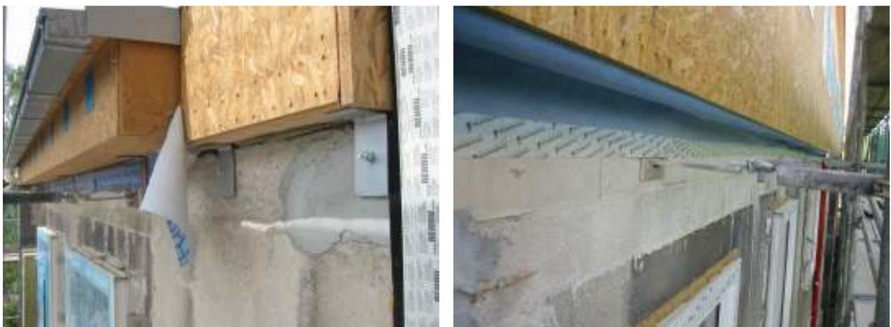
**Abbildung 43: luftdichter Anschluss der Holz-Leichtbau Konstruktion im DG an das Mauerwerk des Bestandsgebäudes.**
