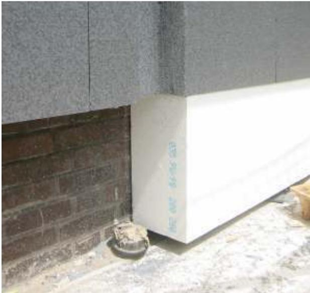
**Abbildung 91: Sockelabschluss zum Gehweg.** Im Sockelbereich wurde steiferes Material verwendet. Der alte Anschluss für das Regenfallrohr ist erkennbar. Das neue Regenfallrohr wird an dieser Stelle in einer Aussparung der Dämmung geführt, vgl. auch Abbildung 115
