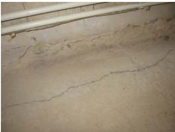
**Abbildung 20: Risse in der bestehenden Rohbetondecke...**
