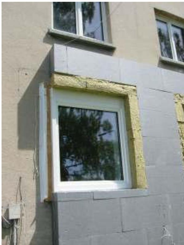
Abbildung 139 oben: rEinbau01, WDVS 300 mm. Fenster ganz außen in der Dämmebene, Kantholz 10 cm x 10 cm als Blindstock rund um das Fenster,
