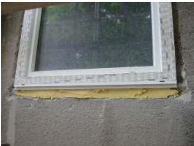
Um die PU-Dämmung einzufügen, musste das Mauerwerk nachträglich teilweise ausgestemmt werden.
