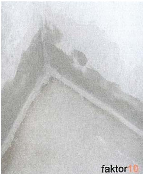
Abbildung 24: Aufbringen des dünnflüssigen Haftgrundes (links oben). Darüber (rechts) Anhydritpachtel, der sorgfältig geglättet wurde.
