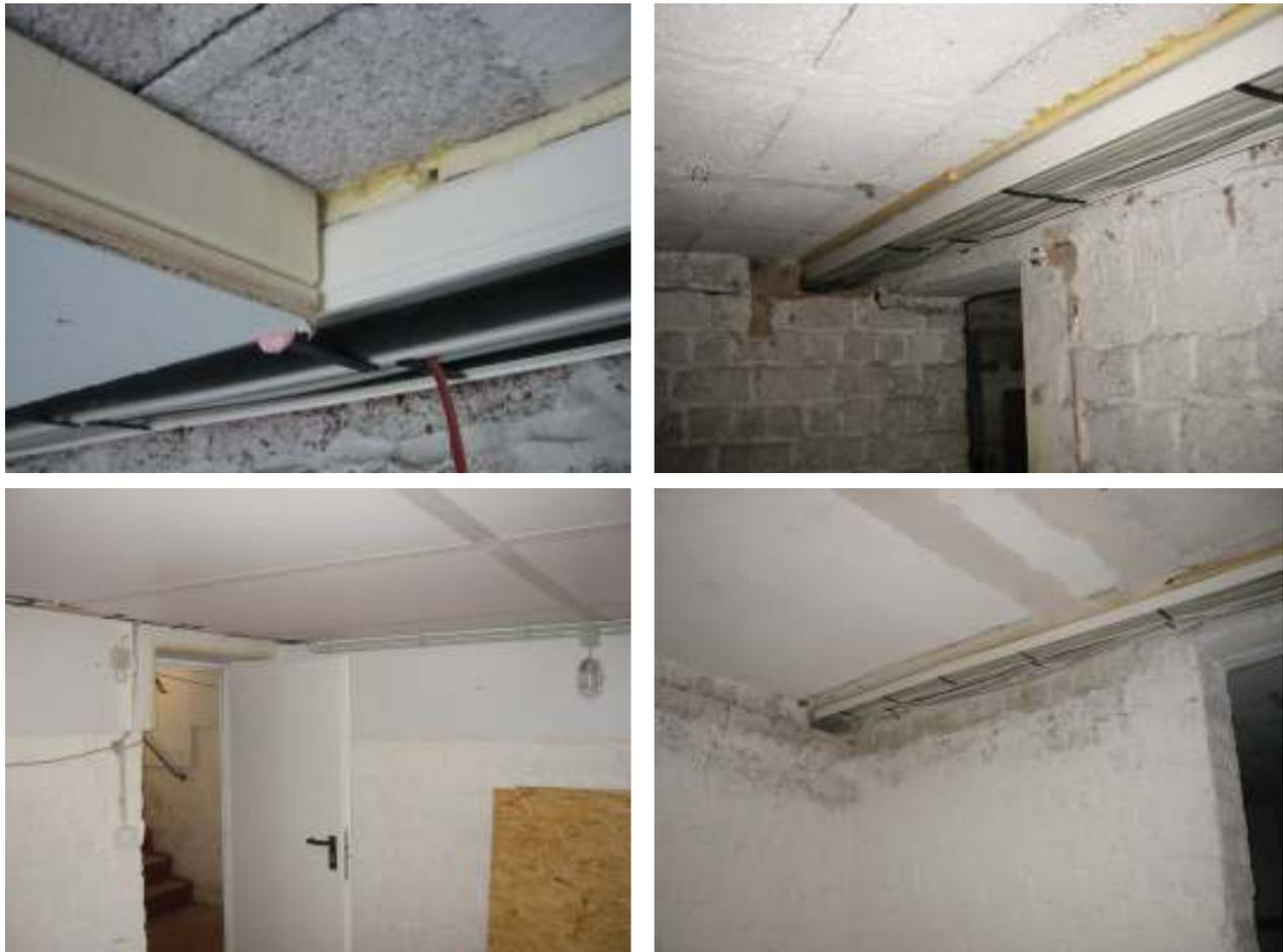
Abbildung 113: Kabelkanal in Kellerdecke vor und nach der Anbringung der Deckendämmung. Links unten: Situation am Sturz einer Kellerinnentür. Entlang des ungedämmten Türsturzes verläuft der Kabelkanal.
