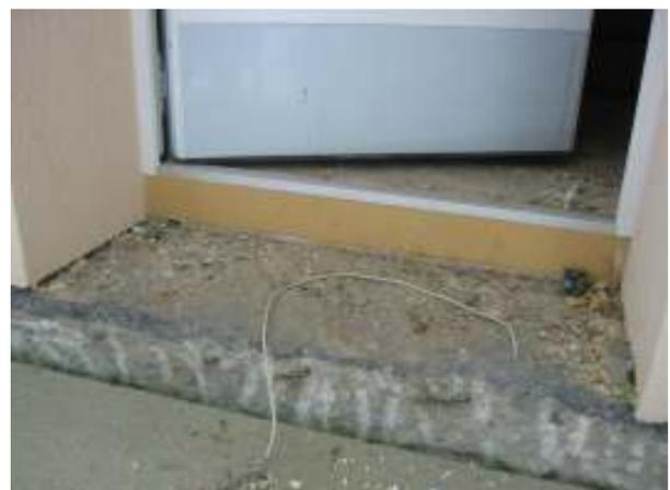
Der Anschlag der alten Haustür wurde fast vollständig entfernt. Der luftdichte Einbau der neuen Tür wurde mit eingeputzten Dichtbändern in Kombination mit Kompribändern und einer Dichtlippe mit einputzbarem Gewebe realisiert.
