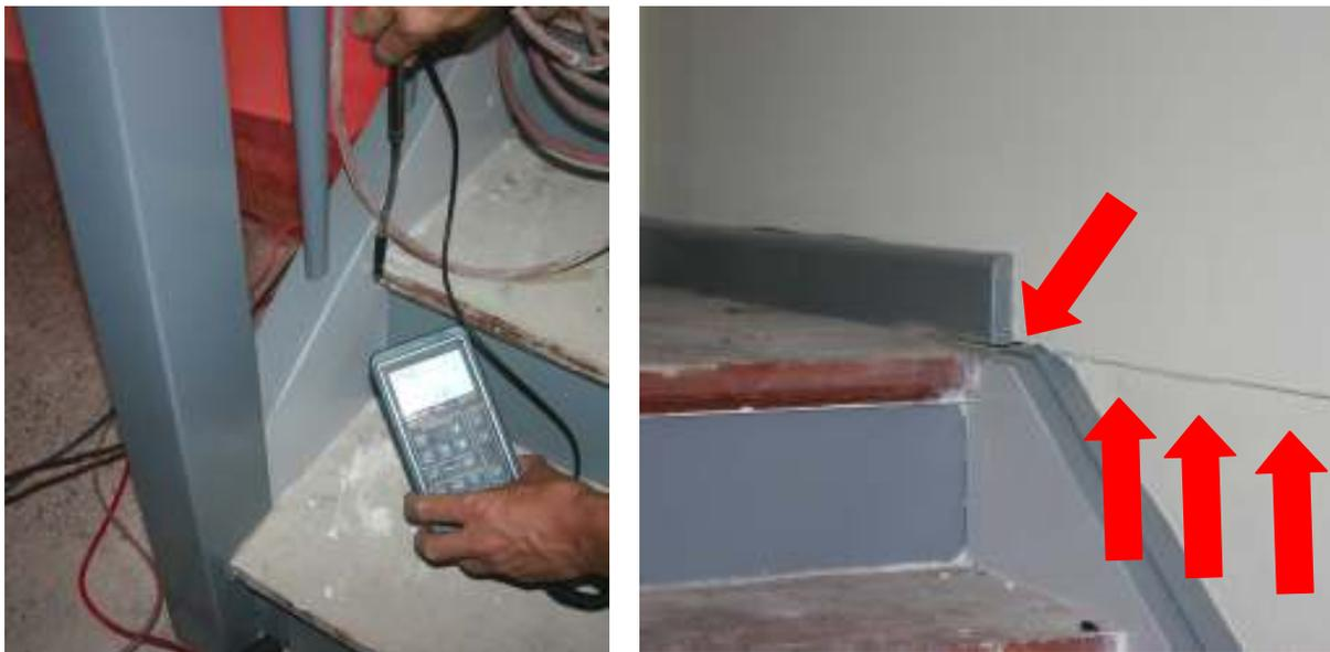
Abbildung 47: Links: Leckagen Treppenstufe zur Freiwange sowie zwischen Tritt- und Setzstufen. Rechts: Im Treppenhaus DG Verbindungsfuge Altbau zum aufgesetzten Neubau.
