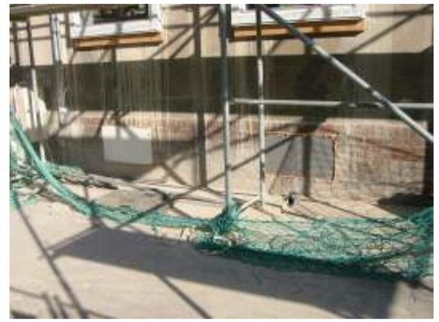
**Abbildung 90:** Die bisherigen Kellerfenster wurden mit Dämmblöcken verschlossen. Die Belüftung der Keller erfolgt durch einfache über Zeitschaltuhr gesteuerte Abluftventilatoren, um nachts eine Lärmbelästigung durch die relativ lauten Lüfter auszuschließen.
