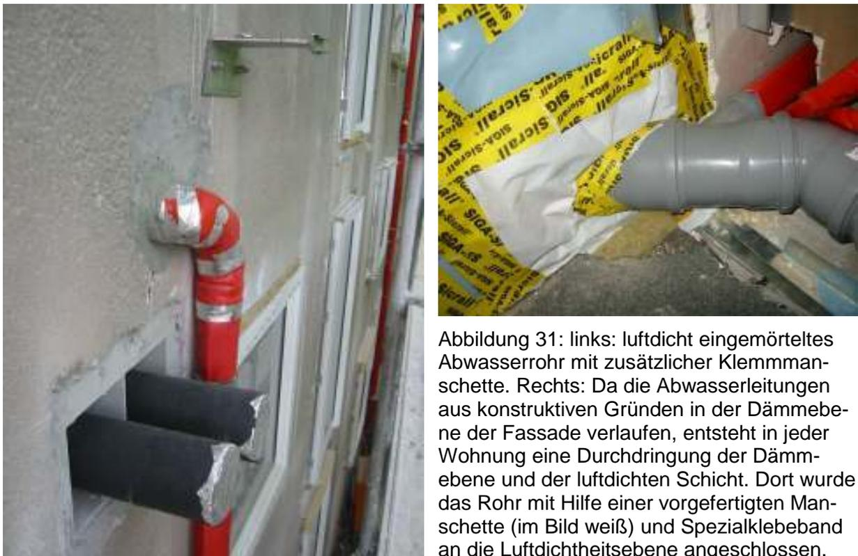
Abbildung 31: links: luftdicht eingemörteltes Abwasserrohr mit zusätzlicher Klemmmanschette. Rechts: Da die Abwasserleitungen aus konstruktiven Gründen in der Dämmebene der Fassade verlaufen, entsteht in jeder Wohnung eine Durchdringung der Dämmebene und der luftdichten Schicht. Dort wurde das Rohr mit Hilfe einer vorgefertigten Manschette (im Bild weiß) und Spezialklebeband an die Luftdichtheitsebene angeschlossen.
