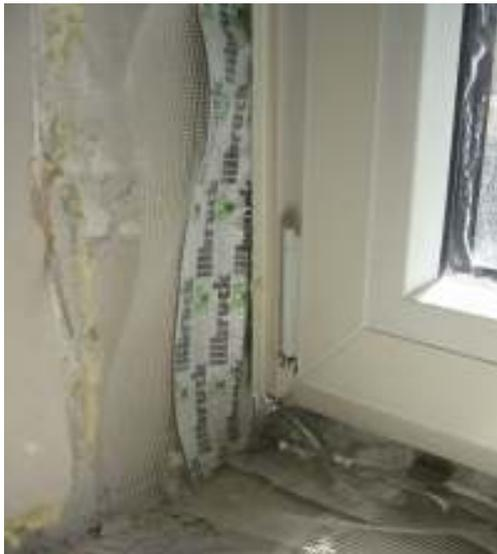
**Abbildung 25: Links: Fensterlaibung zum Teil vorgeputzt. Die Klebebänder wurden später luftdicht eingeputzt.**
