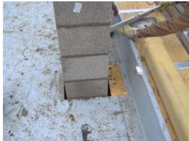
**Abbildung 34: die Schornsteine wurden außen an die Dachdichtungsbahn und raumseitig an die luftdichte Folie im Dachaufbau angeschlossen. Fotos: [faktor10]**
