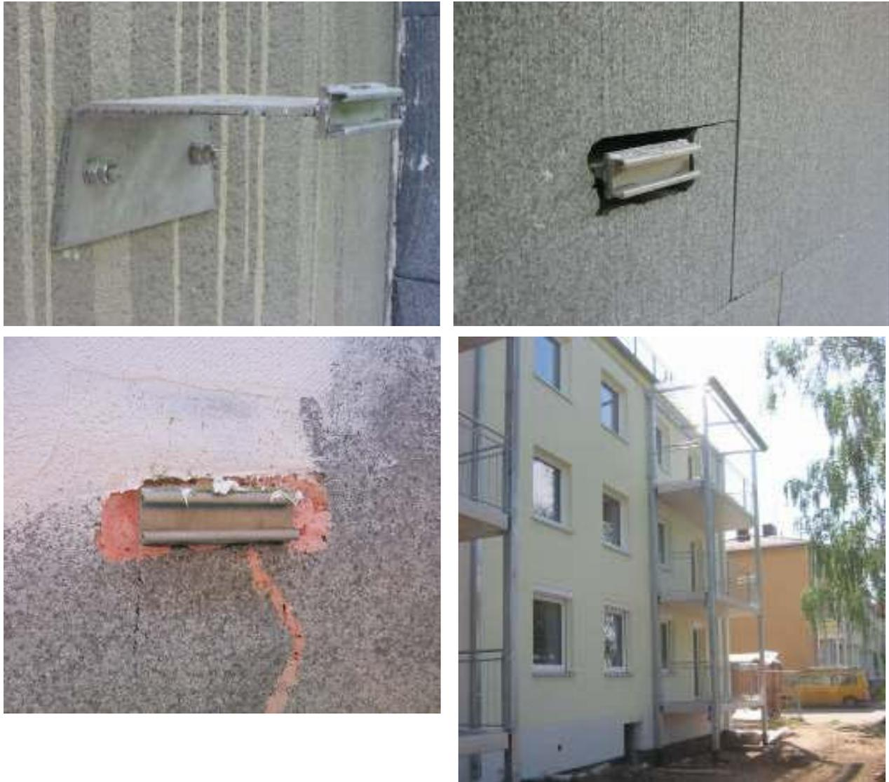
**Abbildung 161:** Edelstahlwinkel mit Halben-Schiene zur späteren Befestigung der vorgestellten Balkone an der Hauswand. Auch diese Befestigungselemente durchdringen die Dämmschicht und verursachen eine nicht zu vernachlässigende Wärmebrücke. Außerdem kann die auf der Außenwand anliegende Platte (Bild oben links) wegen der hohen statischen Lasten nicht einfach im Mauerwerk verschraubt werden, sondern muss zusätzlich mit einer Konterplatte auf der Innenoberfläche der Außenwand gekontert werden.
