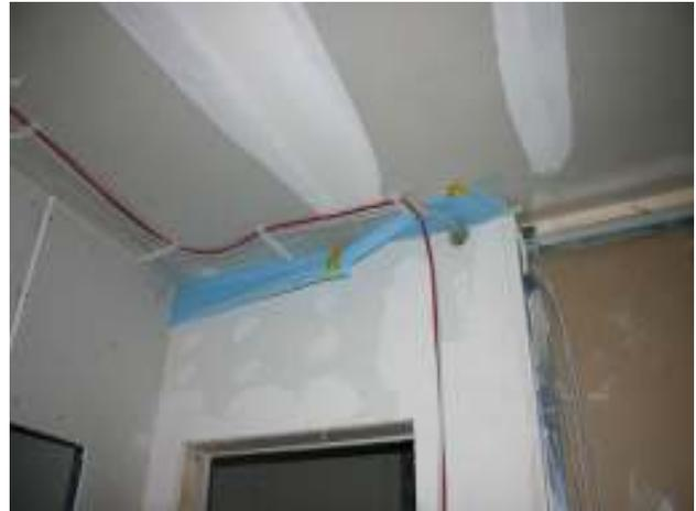
**Abbildung 36: Holz-Leichtbau im DG: Die Dampfbremse und luftdichte Ebene im neuen Dachgeschoss. Im Dachgeschoss wurde von innen auf die OSB-Platten eine PE-Folie verlegt. Diese Folie stellt neben der luftdichten Ebene vor allem eine Dampfsperre dar, die ausgeführt werden musste, weil direkt über dem gedämmten Dachaufbau die wasserführende und dampfdichte Schicht des begrüntes Daches liegt.**
