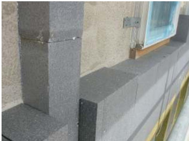
**Abbildung 118:** rechts oben: Verjüngung der Dämmschicht zur Verlegung des Regenfallrohrs zur Straßenseite Tevesstr 36-46, vgl. Abbildung 115.
