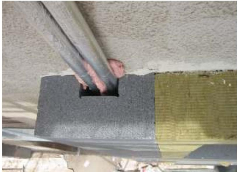
**Abbildung 120: Sie Vor- und Rücklaufleitungen zu den Solar-kollektoren wurden außen in der Dämmebene verlegt, die Hohlräume wurden später noch ausgeschäumt, vgl. Abbildung 116 .**
