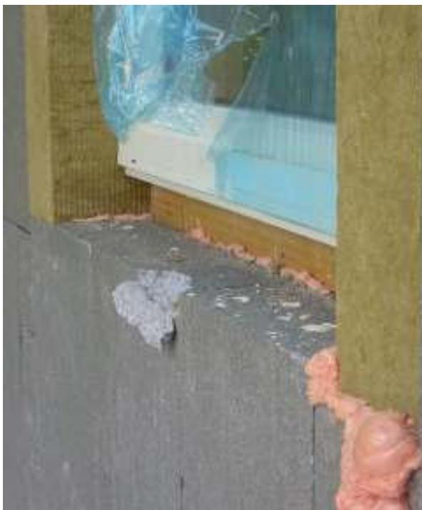
Abbildung 148: rEinbau05. Rollladen Sturzprofil mit Aufdopplung zusätzlich mit PU-Platte gedämmt. Fenster in der Dämmebene, unter dem Rahmen ein Kantholz 60 cm x 6 cm als Auflager.
