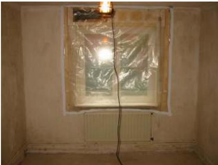
**Abbildung 17:** Die alten undichten Fenster, Rollladenkasten etc. wurden abgeklebt, weil deren Einfluss auf die Luftdichtheit der Gebäudehülle schon bekannt war.
