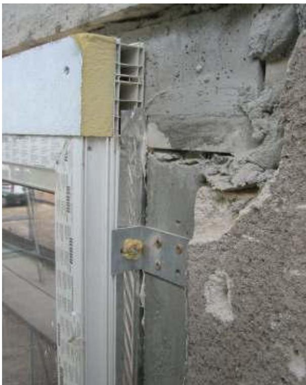
Abbildung 149: rEinbau06. Rollladen, Sturzprofil mit Aufdopplung zusätzlich mit PU-Platte gedämmt. Fenster in der Dämmebene, unter dem Rahmen ein Kantholz als Auflager.
