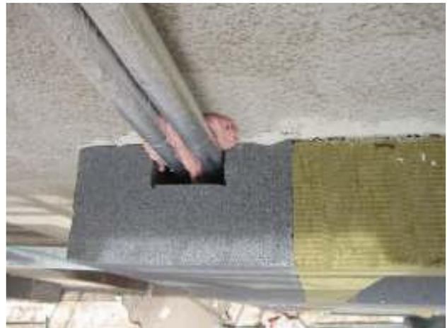
**Abbildung 166: Dämmücke über Solarleitung, die in der Dämmebene verlegt wurde.**
