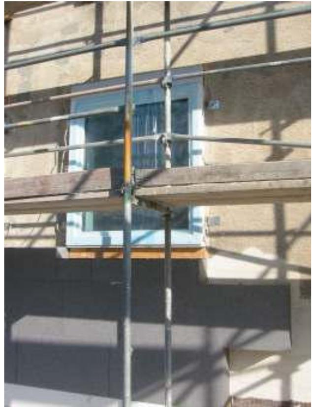
**Abbildung 133: Fenstereinbau in der Dämmebene mit teilweise schon angesetztem Wärmedämmverbundsystem**
