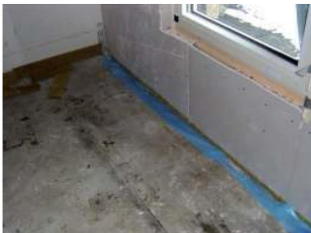
**Abbildung 40:** Holzleichtbau im DG: Überstehende Folie wurde am Fußboden in Mörtelbett gedrückt um eine luftdichte Verbindung zur darunter liegenden Betondecke herzustellen.
