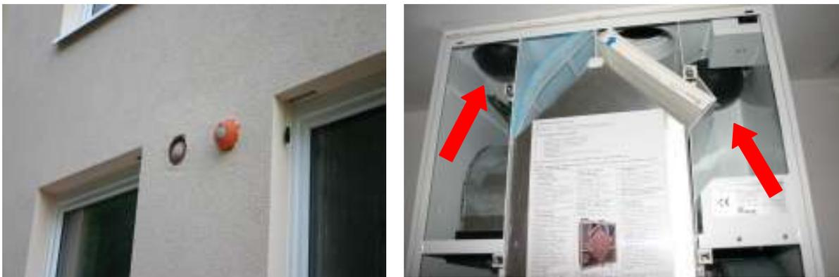
**Abbildung 44: Abdichtung der Fort- und Außenluftöffnungen an der Fassade bei einer der EG Wohnungen und geöffnetes Lüftungsgerät mit eingesetzten Luftblasen.**
