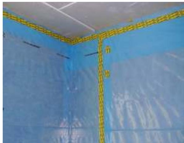
**Abbildung 37: Holz-Leichtbau im DG. Luftdichte Folie (und Dampfsperre) auf der OSB-Platte, an den Stößen verklebt, bevor die Gipskartonplatte aufgebracht wurde. Fotos: [faktor10]**
