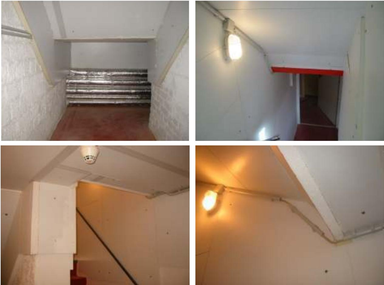
**Abbildung 106: PU-Platten 40 mm als Begleitdämmung der aufgehenden Kellerwand. Situation unter dem Hauseingangspodest des Treppenhauses und am Abgang von der Haustür zum Keller.**
