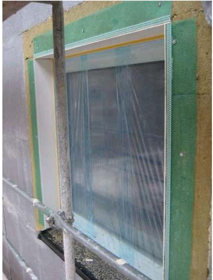
**Abbildung 143:** Rechts: gedämmte Laibungsplatten zur rationellen Herstellung der Oberflächen in der Fensterlaibung. Gleichzeitig dient die 3 cm starke Dämmung der Überdämmung des Fensterrahmens, vgl. Abbildung 142. Oben: Detailaufnahme.
