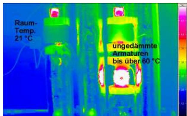
Abbildung 201: ungedämmte Installationen im Heizungskeller {61227109}
