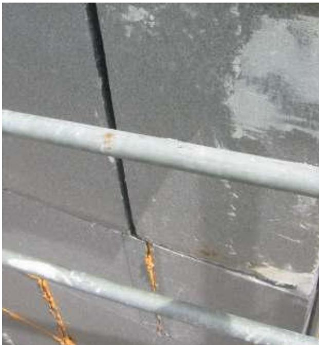
**Abbildung 165: Spalt zwischen zwei Dämmplatten, der später mit Ortschaum ausgefüllt wurde, wie im unteren Bildteil zu erkennen.**
