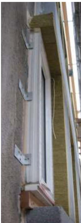
Abbildung 146: rEinbau031(oben) Einbau02(unten) WDVS 260 mm. Fenster in der Dämmebene, unter dem Brüstungsprofil ein Kantholz 6 cm x 6 cm als Auflager, Rahmen in Laibung und Sturz etwa 3 cm überdämmt.
