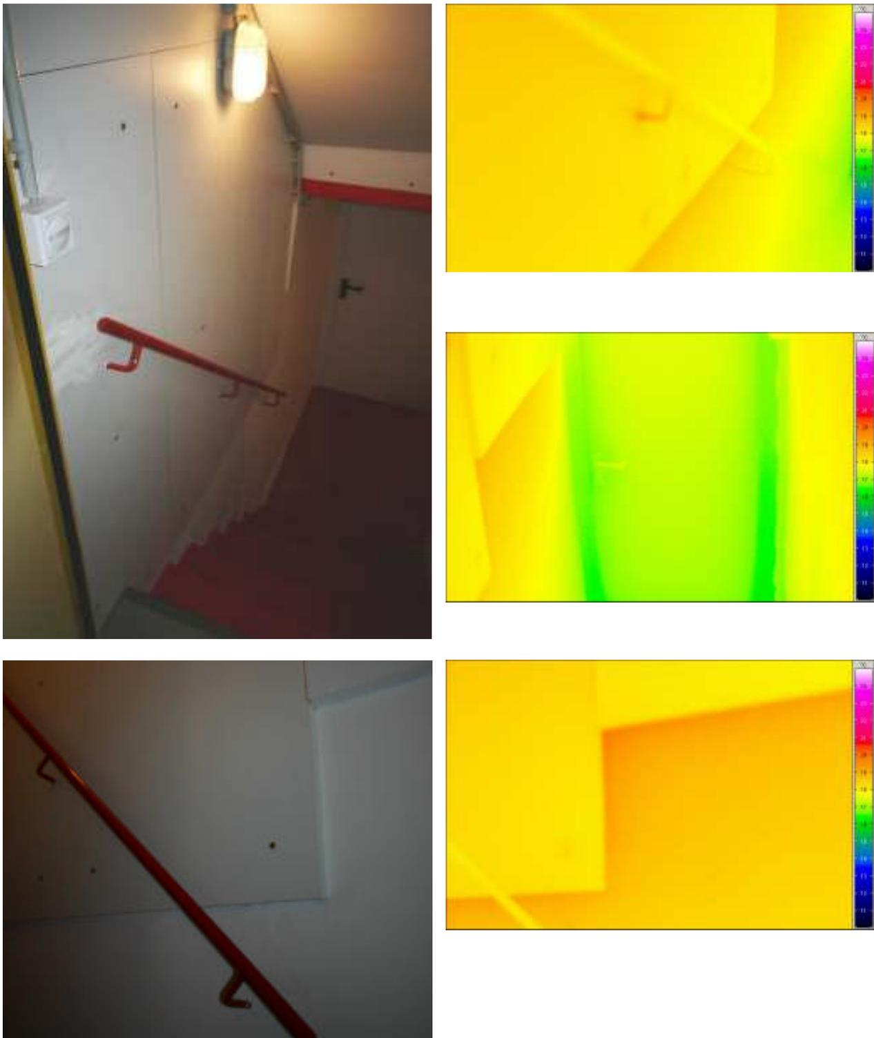
**Abbildung 195: Kellertreppe. Die Begleitdämmung wurde aufgrund der beengten Platzverhältnisse nur mit einer Mindestdämmstärke von 50 mm ausgeführt.**
