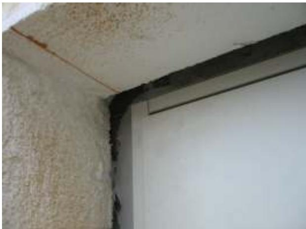
**Neue Tür mit Zarge aus Stahlwinkel sitzt außen vor dem alten Sturz. Der Sturz ist innenseitig überall mit mindestens 20 mm Wärmedämmung überdeckt. Siehe auch Abbildung 98.**
