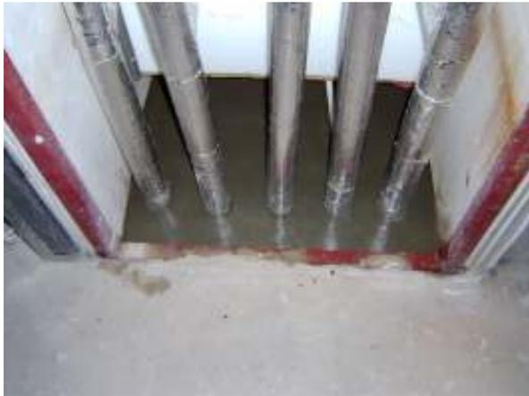
**Abbildung 32: Alle Durchdringungen der Kellerdecke durch Heizungsleitungen o.ä. wurden mit Hilfe von Quellmörtel luftdicht abgedichtet.**
