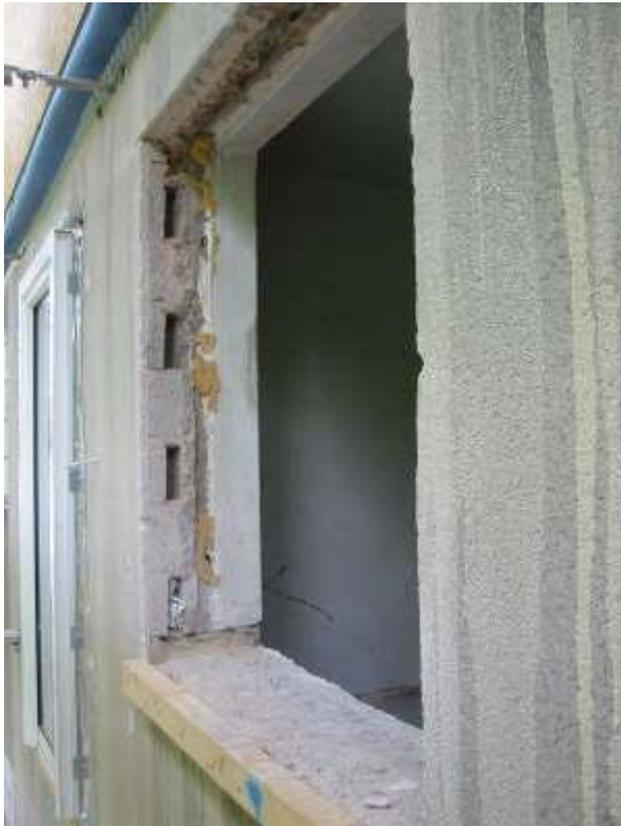
**Abbildung 132: Mauerwerksöffnung nach dem Abbau des alten Anschlags, vorbereitet zum Einbau des neuen Fensters.**
