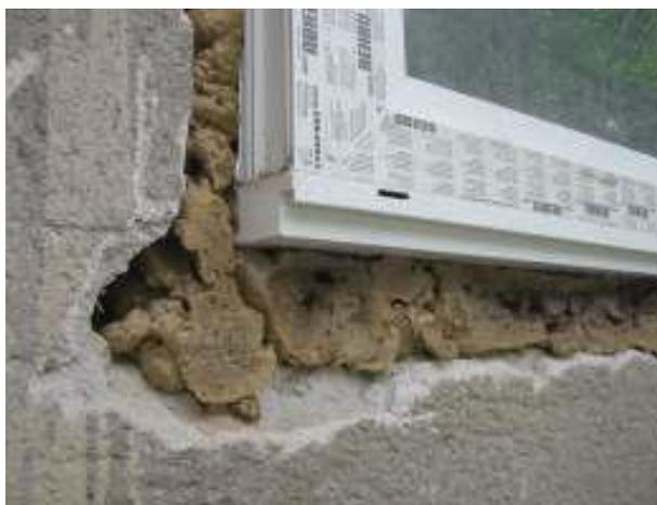
Abbildung 155: rEinbau221. Fenster eingerückt auf Mauerwerk. In Laibung etwa 3 cm überdämmt. PU-Block unter Brüstungsprofil zur Entschärfung der Wärmebrücke am Fensterbankanschluss. Beide Maßnahmen zusammen verbessern den U-Wert des Fensters auf ein in Ausnahmefällen gerade noch hinnehmbares Maß.
