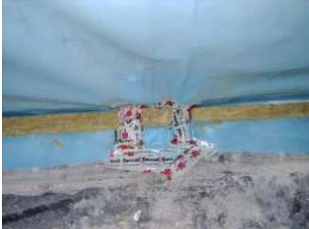
**Abbildung 41: Anschluss der luftdichten Folie der Holz-Leichtbau-Wände im DG an die Rohbetondecke des 2. OG. Die mechanische Fixierung der Folie durch Mineralwollestreifen – hier vor Montage der Gipskartonverkleidung auf der Wand – konnte im Bereich der Windanker nicht vollständig verwirklicht werden. Foto: [faktor10]**
