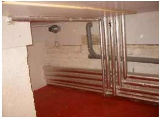
**Abbildung 211: Gedämmte Rohrleitungen die in der Dämmebene verlegt sind.**
