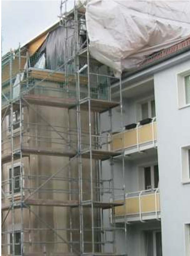
**Abbildung 124:** Anschluss Tevesstraße 36 zum Nachbargebäude Herxheimerstraße während der Bauzeit. Die Trennwand ist auch im Nischenbereich der Balkone zweischalig aufgebaut mit einer hohlen Trennfuge von 20...50 mm.
