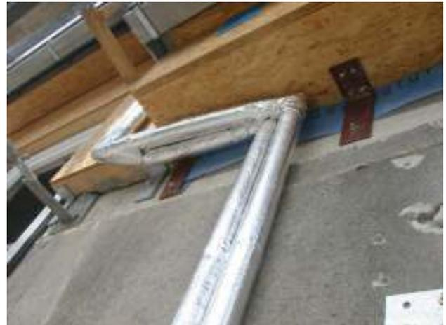
**Abbildung 121: Solarleitungen am Übergang vom DG (Holz-Leichtbau-Elemente) zum Bestandsgebäude. Die Leitungen verschwanden später vollständig hinter der Wärmedämmung.**
