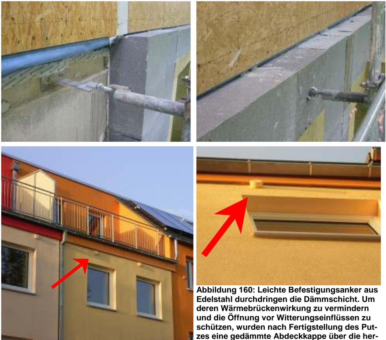
**Abbildung 160:** Leichte Befestigungsanker aus Edelstahl durchdringen die Dämmschicht. Um deren Wärmebrückenwirkung zu vermindern und die Öffnung vor Witterungseinflüssen zu schützen, wurden nach Fertigstellung des Putzes eine gedämmte Abdeckkappe über die hervorstehenden Ringösen gestülpt.
