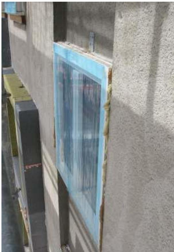
**Abbildung 156: rEinbau Treppenhaus. Fenster wegen Mauerwerksrücksprung seitlich eingerückt ins Mauerwerk. In Laibung deshalb nicht überdämmt. Oben und unten wie Abbildung 145**
