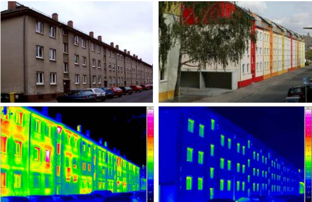
**Abbildung 167: Tevesstraße 36 bis 46 (6er Block) mit IR-Thermografie vor und nach der Sanierung**
