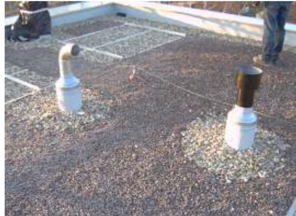
**Abbildung 33: Fortluftauslass und Außenluftansaugung einer Dachgeschosswohnung. Fotos: [faktor10]**
