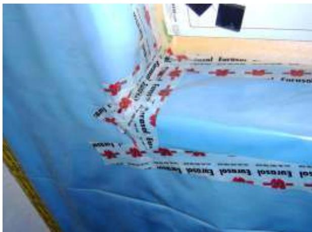
**Abbildung 39:** Fensteranschluss Holzleichtbau im DG: Folie mit Fenster verklebt.
