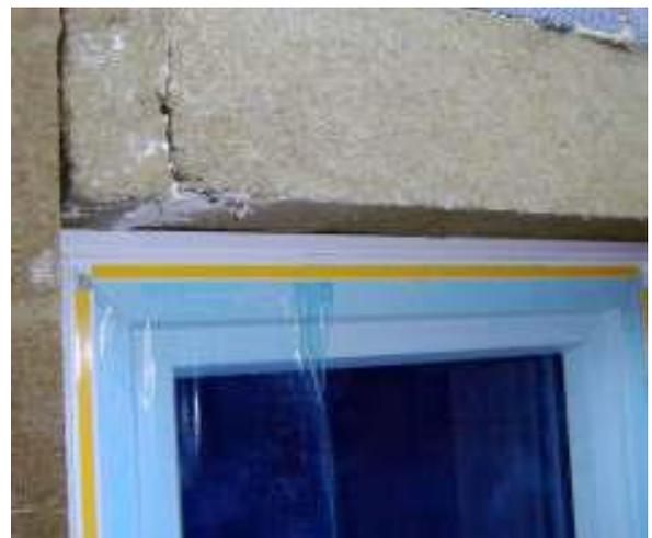
**Abbildung 144:** links: Montage der gedämmten Laibungsplatten mittels PU-Kleber. Rechts: Putzendschienen zur Aufnahme der Laibungsplatten. Fotos[faktor10]
