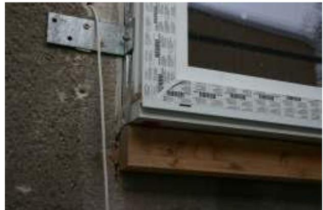
**Abbildung 134: Standard Fenster Einbausituation mit Kantholz als Auflager und Einbauhilfe sowie Stahlwinkeln zur seitlichen Befestigung.**
