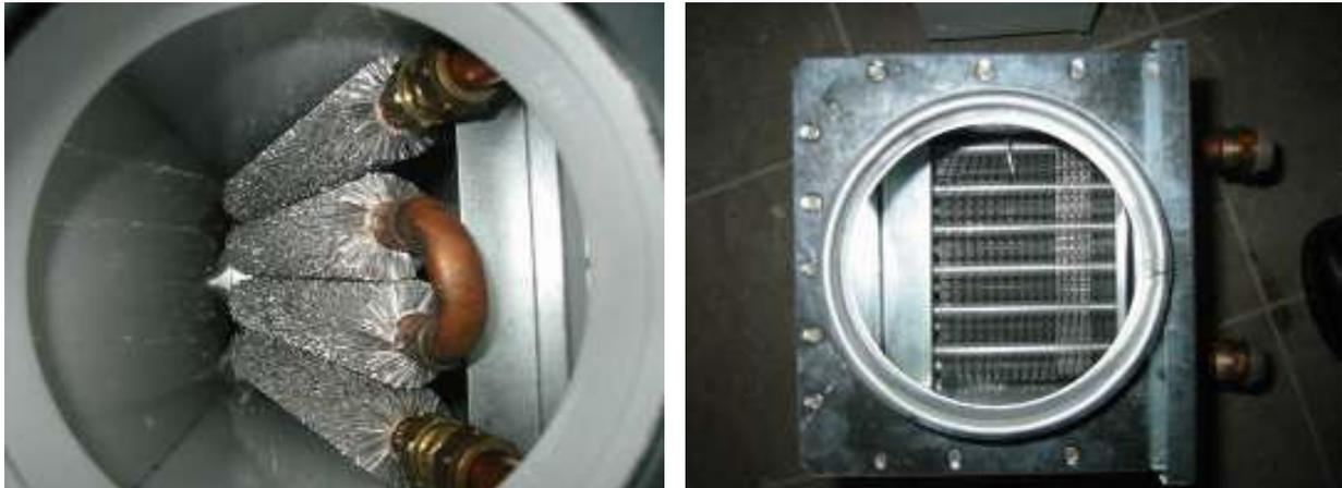
**Abbildung 227: Links Wasser-Luft-Heizregister mit geringer Wärmeleistung, da die Wärmetauscherfläche sehr gering ist. Rechts Heizregister mit hoher Wärmeleistungsübertragung.**
