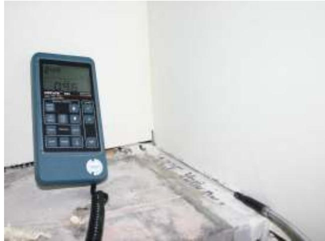
**Abbildung 48: Links: Unfertig verkleidetes Mauerstück im Treppenhaus rechts und links neben dem Fenster im 2. OG/DG, Rechts: Detail von dem Mauerstück mit Leckagen in der Abklebung zur Treppenhausinnen- und Außenwand.**
