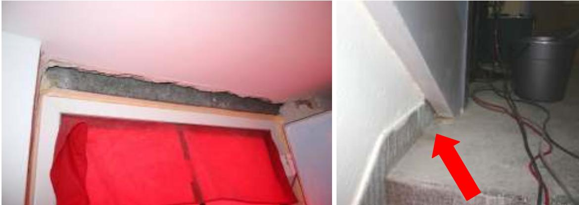
Abbildung 46: Links: Noch unfertiger unverputzter Bereich über der Haustür (Blower Door ist in der Haustür eingebaut). Rechts: Leckage Treppenpodest EG, Anschluss der Freiwange der Treppe zum Keller.
