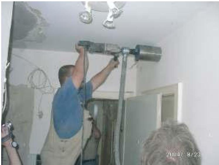
**Abbildung 219: Kernlochbohrung zur Kanaldurchführung der Zuluft vom Flur in das Wohnzimmer (Modernisierungsvorhaben der SWB, Göttingen; Foto: PHI)**
