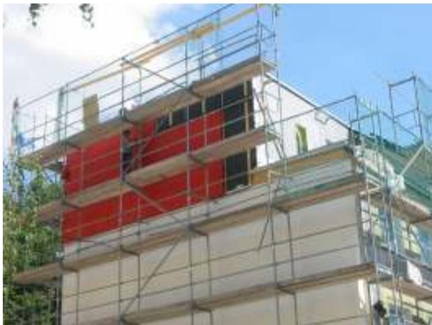
**Abbildung 64:** Die Dämmung an der Giebelwand und des Staffelgeschosses sind vor der Holzständerkonstruktion mit 14 cm Mineralwolle gedämmt. Davor eine hinterlüftete Fassadenplatte aus Holzwerkstoff.
