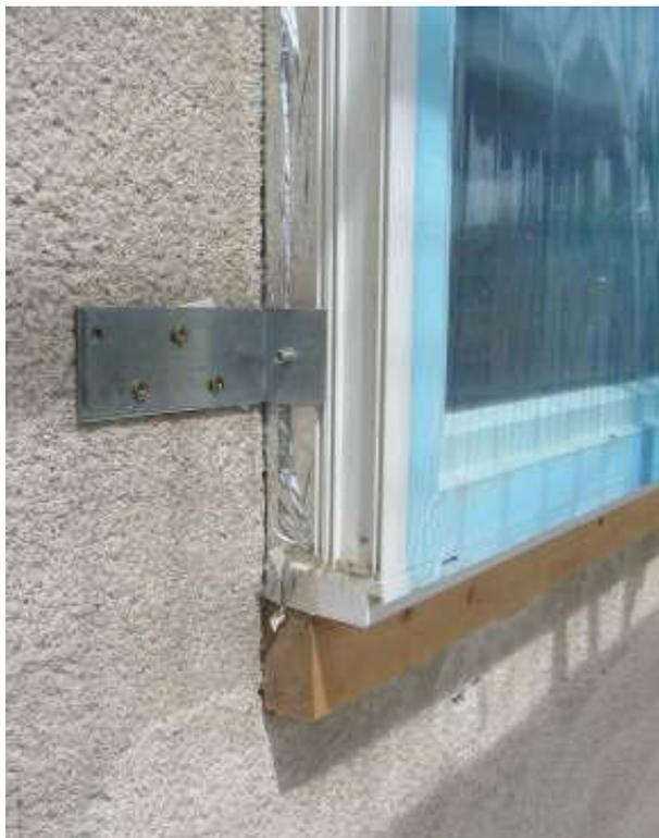
Abbildung 145: rEinbau03 WDVS 260 mm. Fenster in der Dämmebene angeordnet, unter dem Brüstungsprofil ein Kantholz 6 cm x 10 cm als Auflager, Rahmen in Laibung und Sturz nicht überdämmt.
