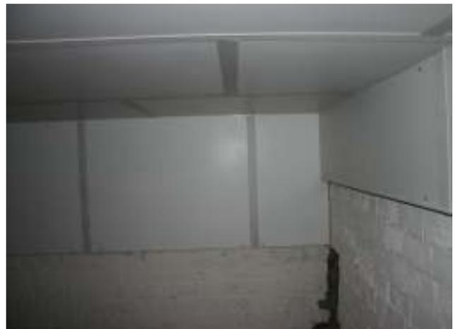
Abbildung 108: PU-Platten 40 mm als Begleitdämmung der aufgehenden Kellerwand.
