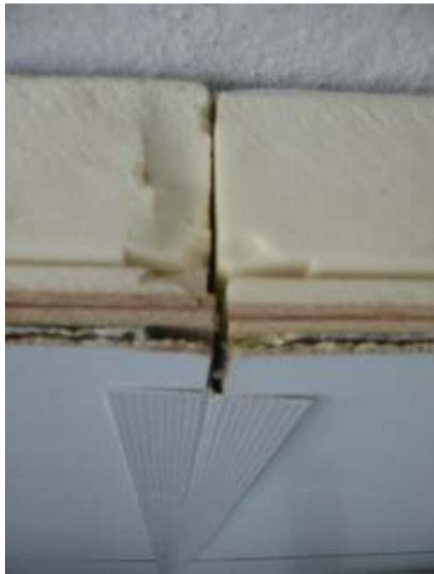
**Abbildung 77: Querschnitt der Dämmplatten unter der Kellerdecke. Die Platten sind seitlich genutet, dort greift ein H-Profil aus Kunststoff ein, welches die Verbindung zwischen den Plattenstößen bildet. Die Oberfläche besteht aus einer weiß beschichteten Holzwerkstoffplatte.**
