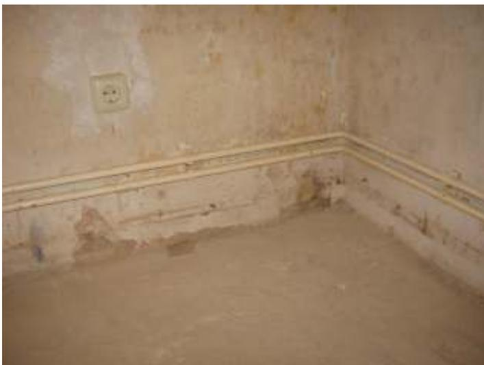
**Abbildung 18:** Schadhafte Verputz im Sockelbereich nach der Entfernung des Holzfußbodens
