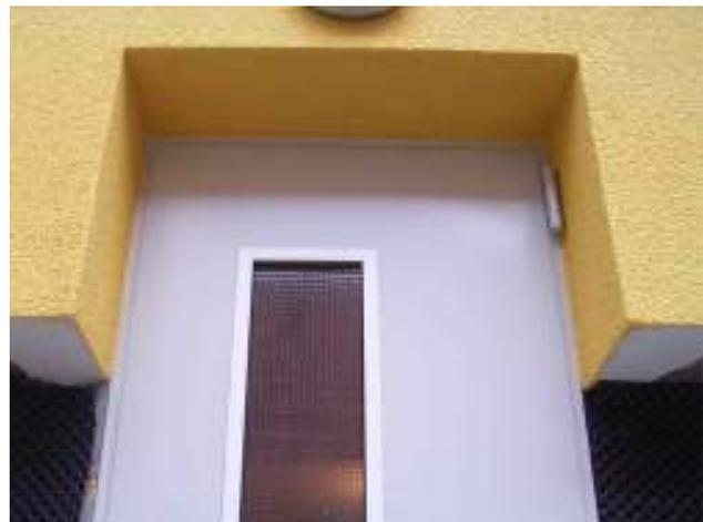
**Dämmung außenseitig dicht an den Türrahmen angeschlossen.**
