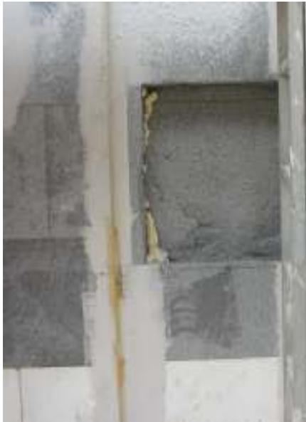
**Abbildung 119: Verjüngung der Dämmschicht wegen Aussparung zur Aufnahme von Briefkästen. Solange eine minimale Dämmschicht von etwa 100 mm stehen bleibt und die Regeldämmstärke größer als 200 mm ist sind solche kleinen Flächen mit geringerer Dämmstärke unproblematisch.**
