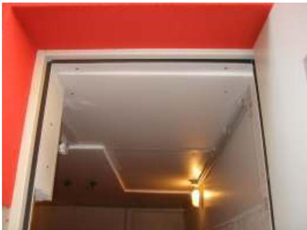
**Dämmung der Kellerdecke innenseitig auch unter dem Sturz bis zur Tür durchgezogen.**
