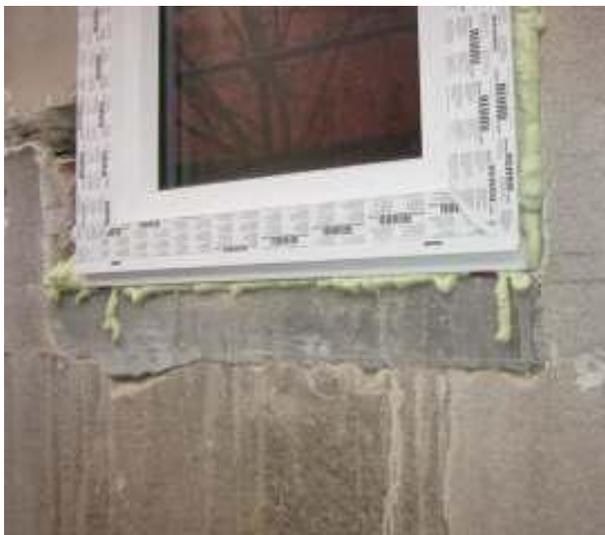
Abbildung 151: rEinbau21. Fenster eingerückt auf Mauerwerk. In Laibung nicht überdämmt. Extreme Wärmebrücke am Fensterbankanschluss.
