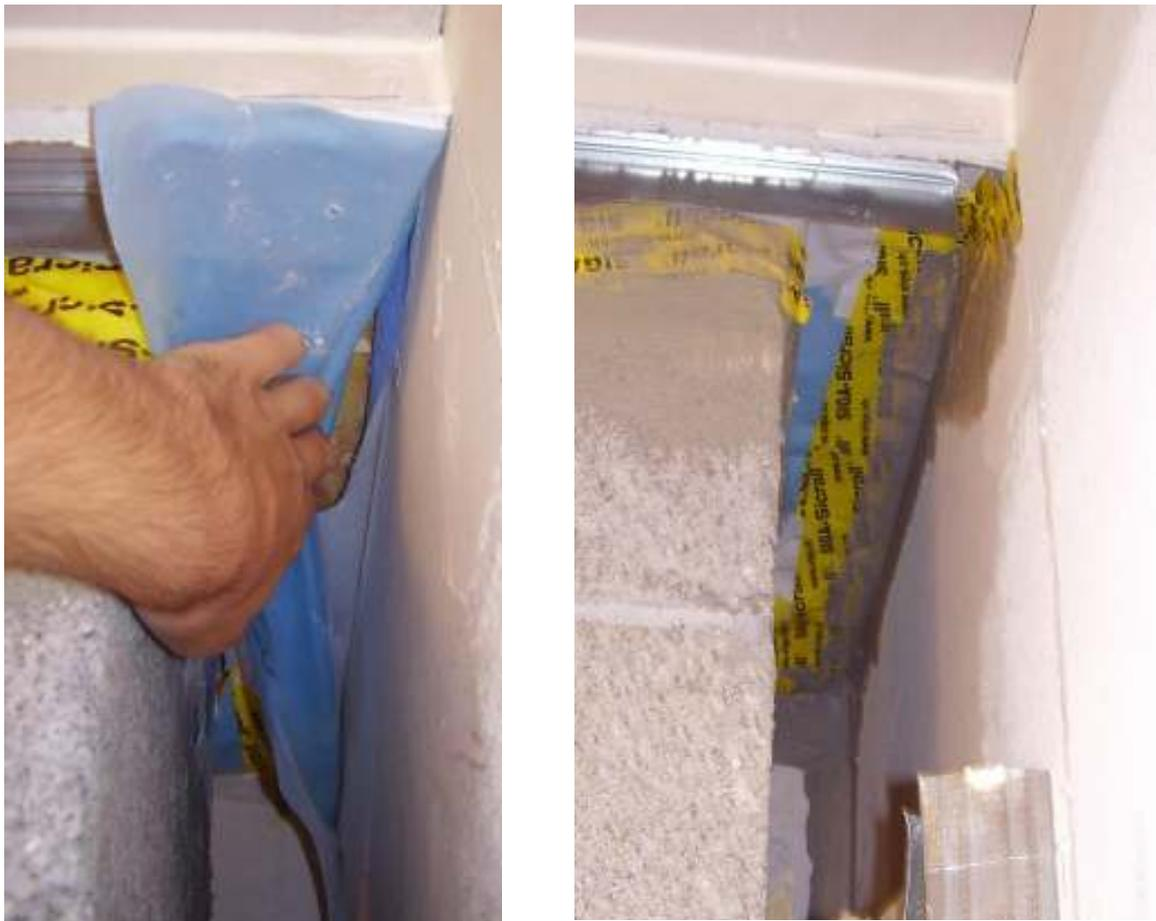
Abbildung 53: Links: Leckage hinter dem Schornstein zum Dach bzw. zur Haustrennwand (nach dem Entfernen der Gipsplattenverkleidung. Rechts: Gleicher Bereich nach dem Verkleben der Folien (Fotos: Faktor 10).
