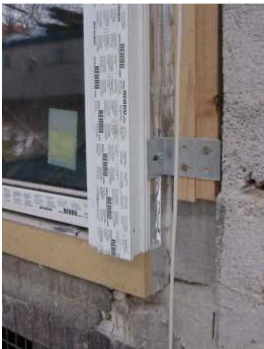
Abbildung 157: rBalkontür Einbau03(Schwelle) Einbau06 Fenster in Dämmebene. In Laibung etwa 3 cm überdämmt. An der Schwelle Blendrahmenprofil ersetzt durch Türschwelle, deshalb praktisch keine Dämmwirkung im Rahmen. An der Schwelle außerdem systembedingt (Wasserführung) keine Überdämmung des Rahmens nur PU-Recycling-Block als Auflager. Unten links: Eingebaute Balkontür mit PUR-Block unter dem Schwellprofil.
