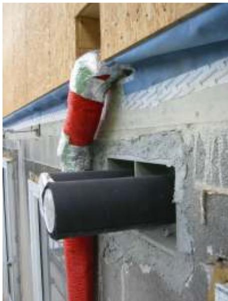
**Abbildung 117:** Fallrohr der Abwasserleitungen wurden außen in der Dämmebene verlegt, vgl. auch Abbildung 114.
