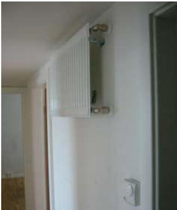
**Abbildung 226: kleiner zusätzlicher Heizkörper im Flur einer Wohnung im EG. Dort reicht die Zuluftnacherwärmung nicht aus, um die Heizlast zu decken.**
