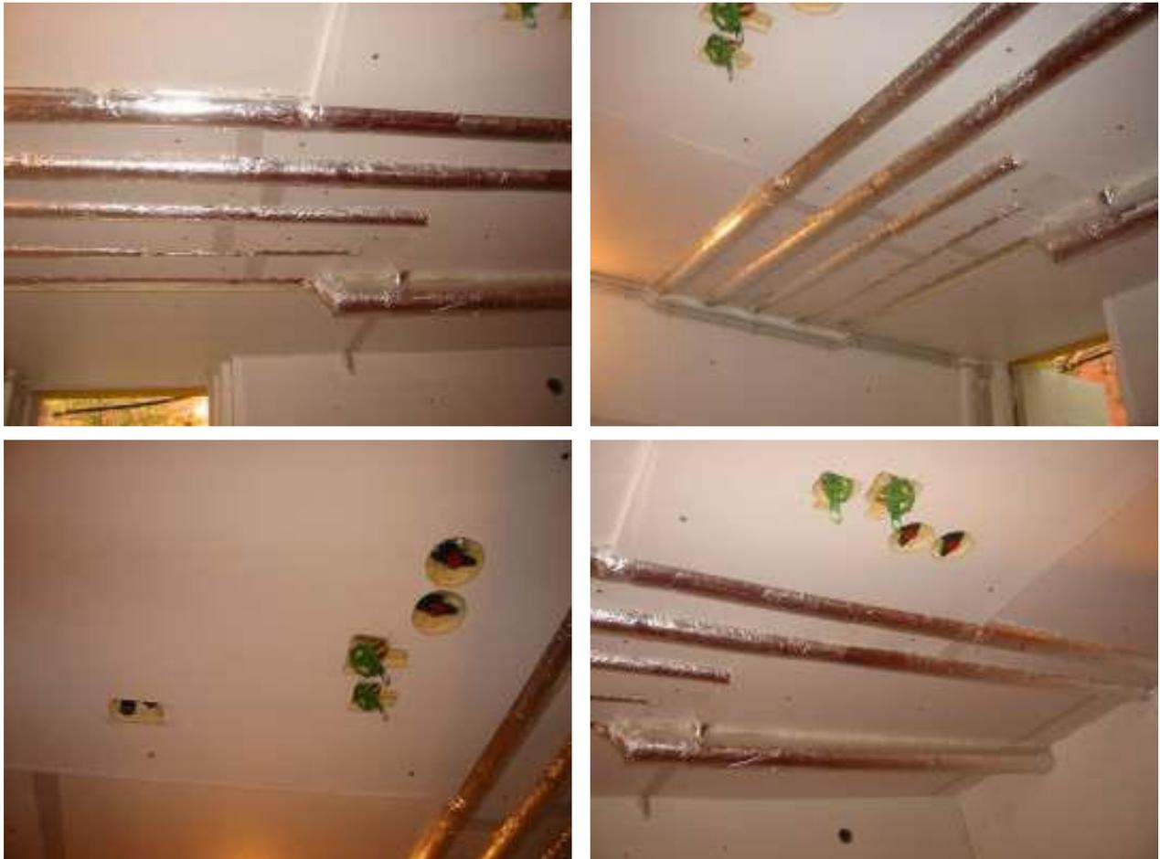
Abbildung 210: Gedämmte Rohrleitungen der zentralen Wärmeversorgung die in der Dämmebene verlegt sind.
