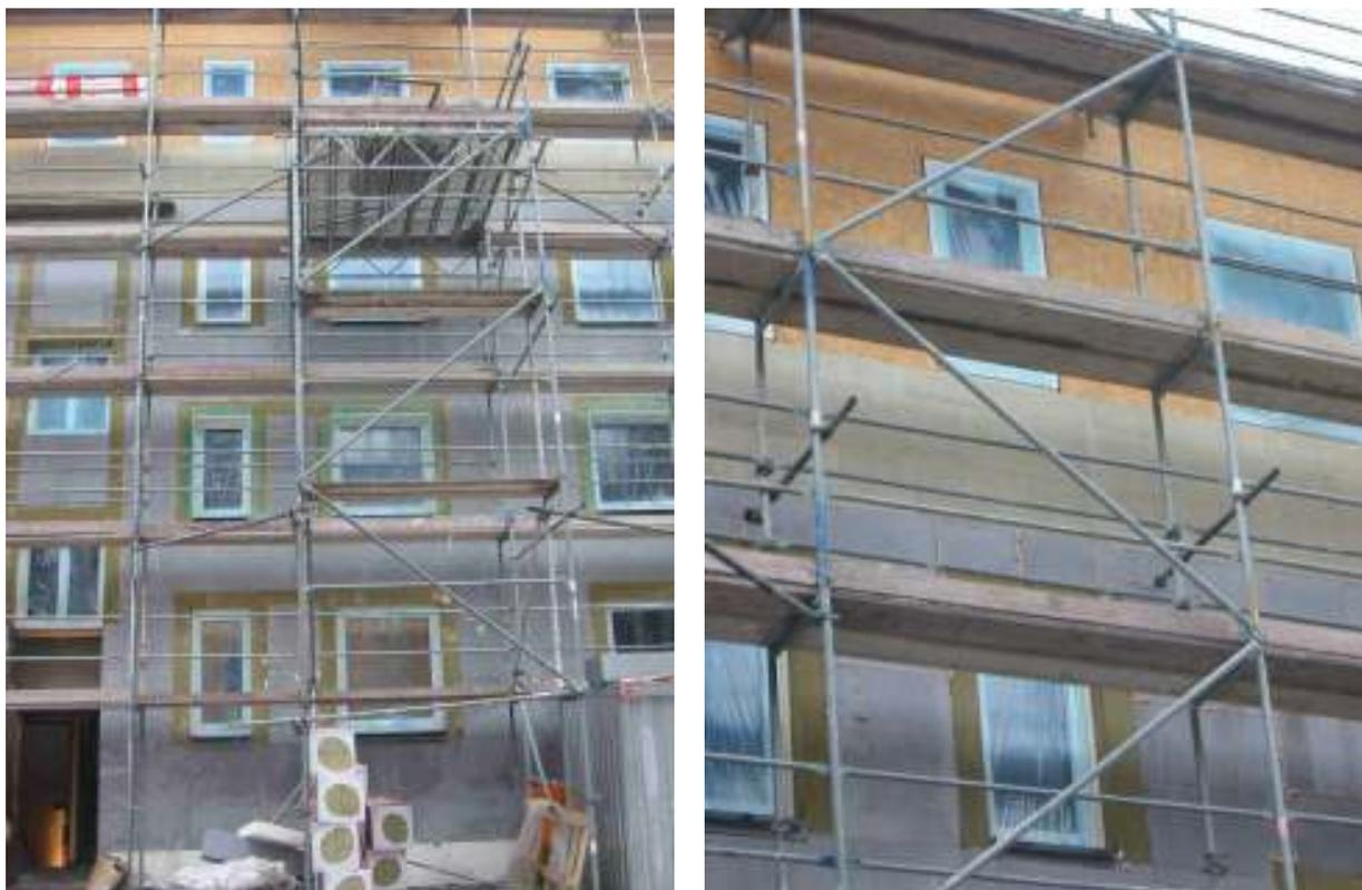
**Abbildung 67: Dämmstreifen aus Mineralwolle rund um die Fenster als Maßnahme zum Brandschutz. Dies ist vorgeschrieben, weil Polystyrol im Brandfall abtropfen kann und dann die Fluchtwege bzw. Angriffswege der Feuerwehr (2. Rettungsweg) gefährden könnte.**
