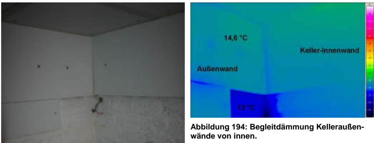
**Abbildung 194: Begleitdämmung Kelleraußenwände von innen.**
