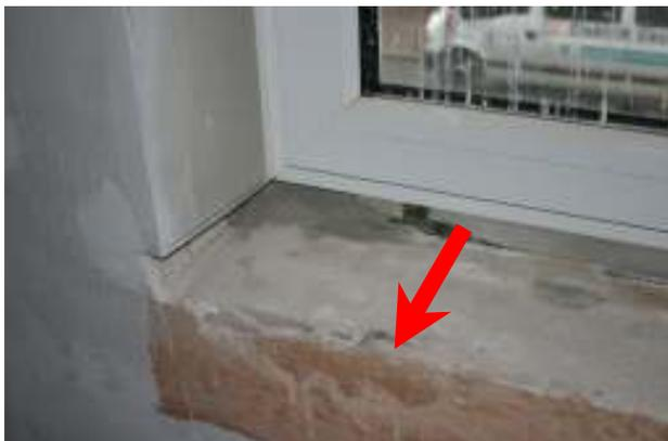
**Abbildung 27: Vor dem Einbau der Fensterbank muss unbedingt eine luftdichte Spachtelung aufgebracht werden oder das am Fenster angebrachte Klebeband muss eingeputzt werden.** Wird hier lediglich die Fensterbank montiert, ohne dass die Putzfläche geschlossen wird, können sich hier Strömungspfade ergeben, welche die Luftdichtheit der Konstruktion beeinträchtigen.
