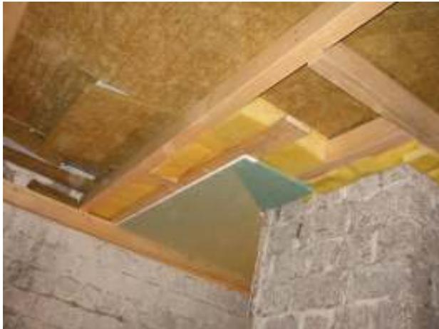
**Abbildung 76: Dämmung aus Mineralwolle mit Kantholzträger und Gipskartonplatte als raumseitige Oberfläche. Nur realisiert an der Kellerdecke der Musterwohnung Tevesstraße 54 links.**
