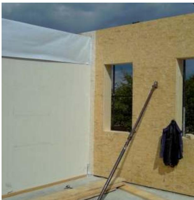
Abbildung 35: Holz-Leichtbau im DG. Folienstreifen zwischen einem Außenwandelement (rechts) und einer Innenwand. Der Folienstreifen wird später an die flächig aufgebrachte Folie angeklebt. Foto: [faktor10]
