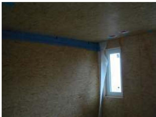
**Folienstreifen über den senkrechten Wandelementen zur späteren Befestigung mit einer flächig unter den Deckenelementen verlegten Folie (Dampfsperre).**
