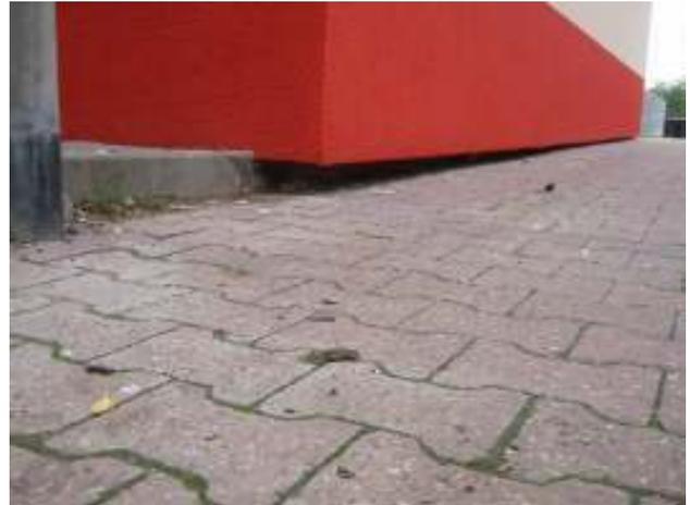
**Abbildung 89:** Dämmung im Sockelbereich der Außenwand. Nur an der Nordwand von Tevesstraße 54 wurde der Luftspalt zwischen Dämmung und Gehweg nachträglich mit wasserdichtem Material verschlossen, weil an dieser Stelle vermutlich Regenwasser in den Keller eingedrungen war und die Kellerwand durchfeuchtet hatte.
