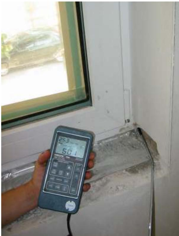
**Abbildung 22: Leckage der luftdichten Ebene Am Fenster aufgrund von fehlerhafter Montage. Die Unterbrechung des Spezialklebebands in der Ecke lässt sich nachträglich nur aufwendig wieder beseitigen.**
