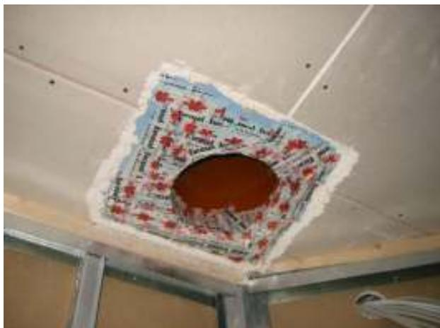
**Abbildung 38:** Luftdichter Anschluss einer Rohrdurchführung für die Außenluft- bzw. Fortluftleitung im DG.
