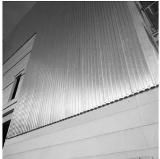
Metallbekleidung auf Porenbeton (Trapezprofilierung).
