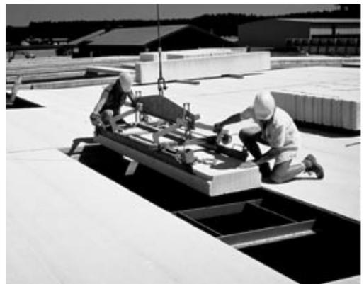
Verlegen von HEBEL Dachplatten mit der Verlegezange.
