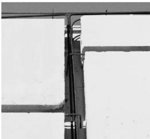
HEBEL Deckenplatten mit eingelegter Fugen- und Ringankerbewehrung.
