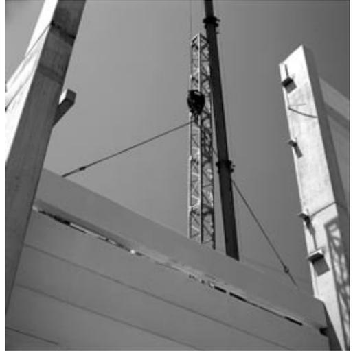
Bis zu 8,00 m lange HEBEL Wandplatten für rationellen Montagebau.
