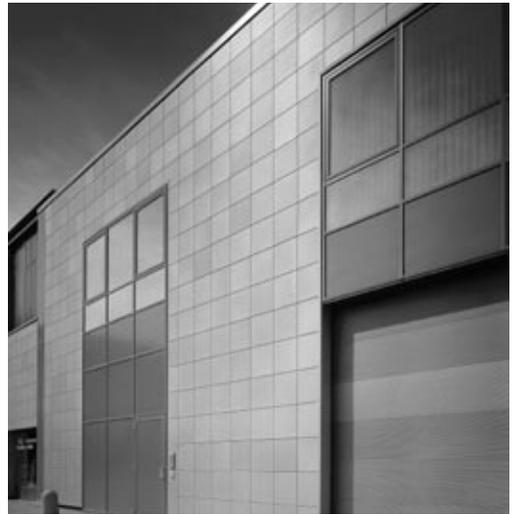
Lofatec Fassaden-Elemente aus Composit-Werkstoff auf Porenbeton.
