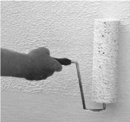
Strukturieren der Beschichtung mit der Rolle.
