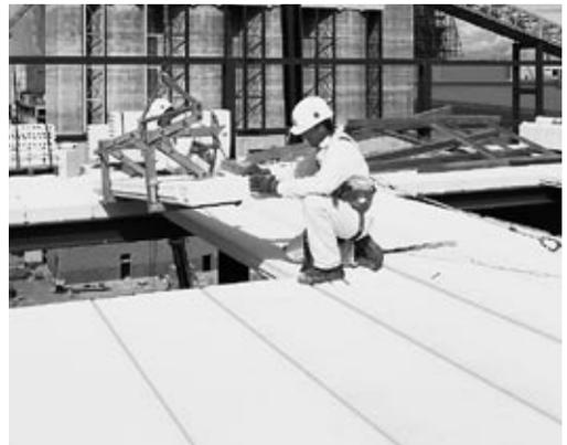
Verlegen von HEBEL Dachplatten mit Verlegebügel.
