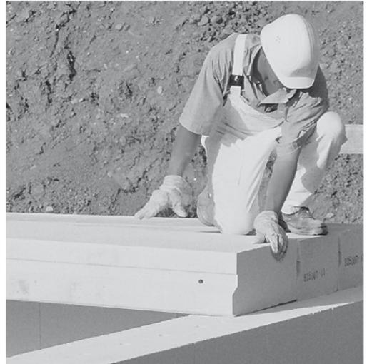
HEBEL Dach- und Deckenplatten liegen nahezu fugenlos auf Porenbeton-Wänden.
