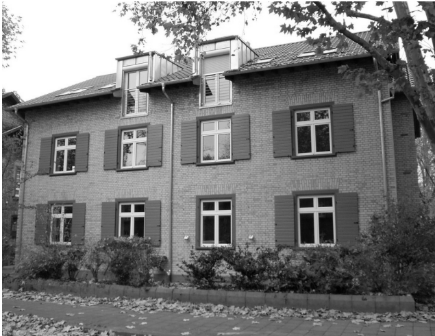
Abbildung 1: Südwest-Fassade des Gebäudes nach der Sanierung.
