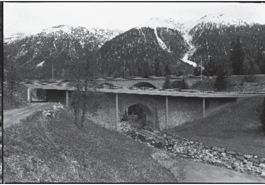
Verbreiterung Brücke Vamber (Straße S-chanf - Ciuos-chel), 2006, Conzett, Bronzini, Gartmann.
