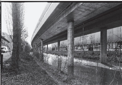
Sihlhochstraße Zürich, 1974, Ing.: Soutter und Schalcher, Hans Eichenberger; Arch.: E. Schindler. Die Sihlhochstraße gehört zu den städtebaulich heftig umkämpften Brückenbauwerken, von denen man dennoch nicht sagen kann, sie seien ohne architektonisch engagierten Landschaftsbezug erstellt worden. Neuartig an dieser Konstruktion war, dass die zwei parallelen Hohlkastenträger nur punktgestützt wurden, wodurch der Flussraum zwar abgedeckt, darunter aber hydraulisch und ästhetisch nur wenig beengt wurde.
