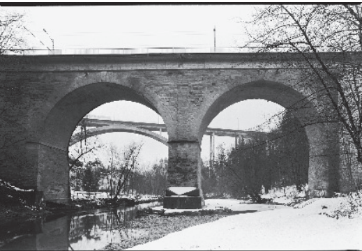
Kräzernbrücke, Straße Gossau – St. Gallen, 1811, Johann Ulrich Haltiner. Eine Brücke mit strenger Geometrie, denn in die Öffnungen könnte man Vollkreise zeichnen, die unten den Wasserspiegel der Sitter berühren.
