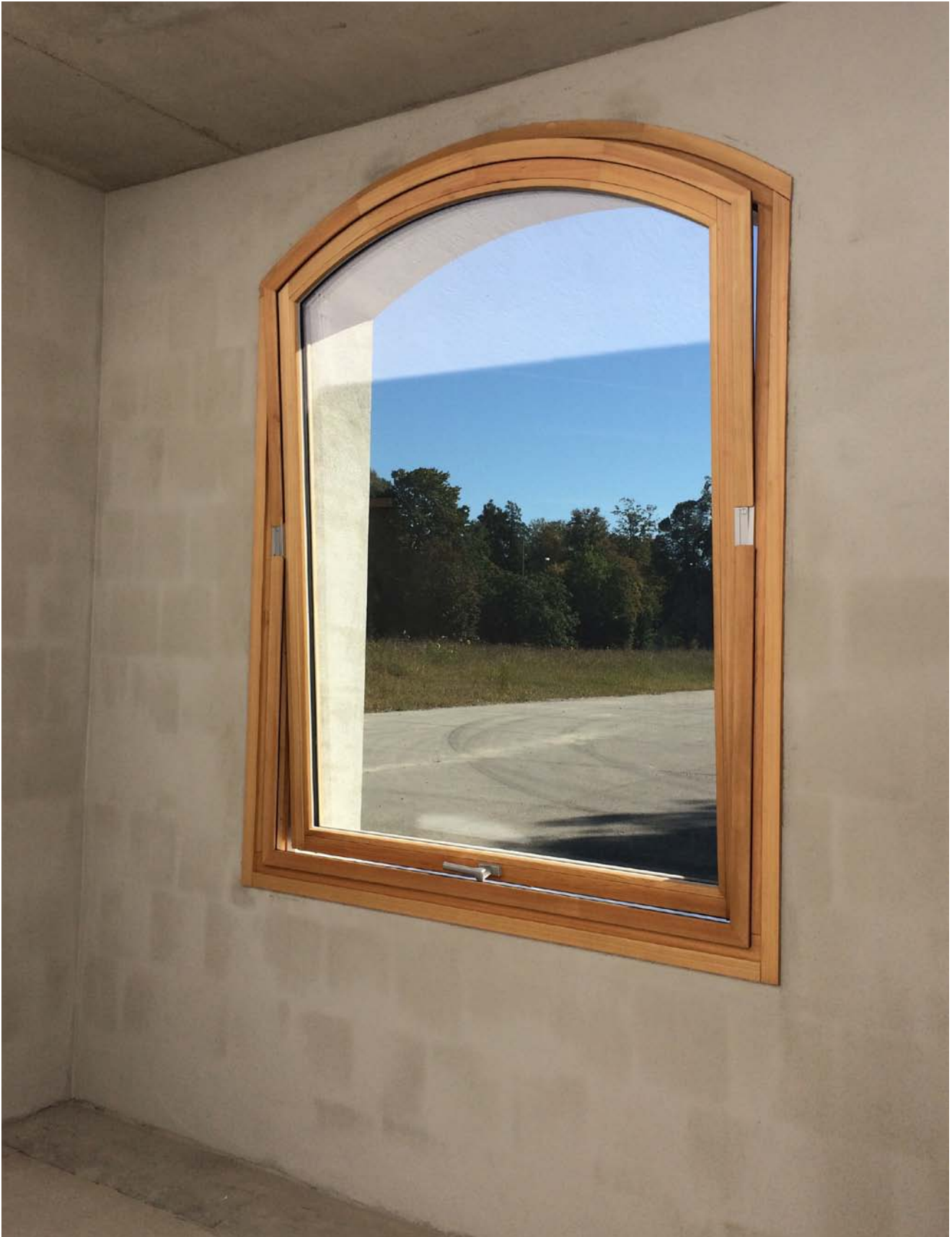
Mauerwerk: Lüftungsstellung Schwingflügel
