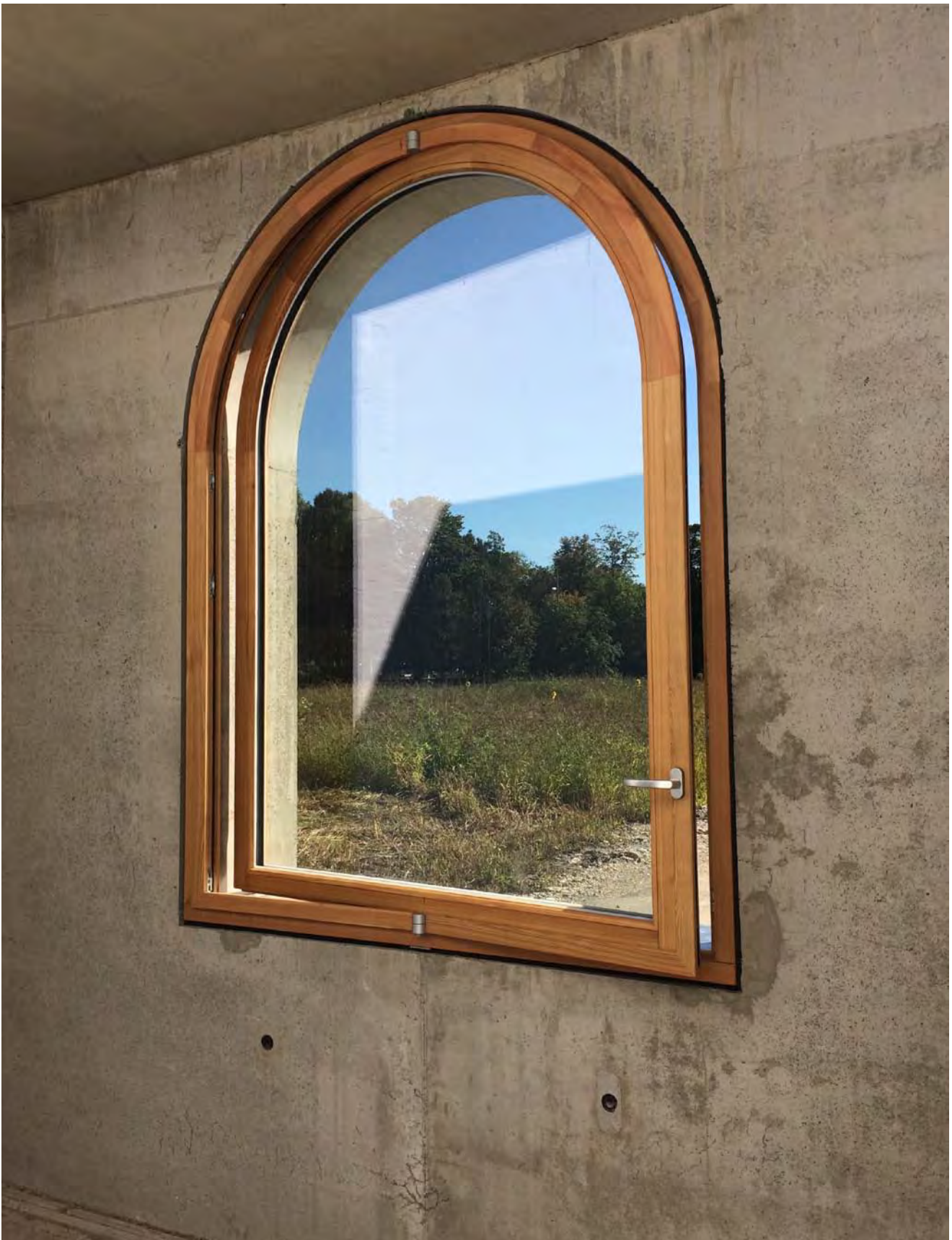
Infraleichtbeton: Lüftungsstellung Wendeflügel
