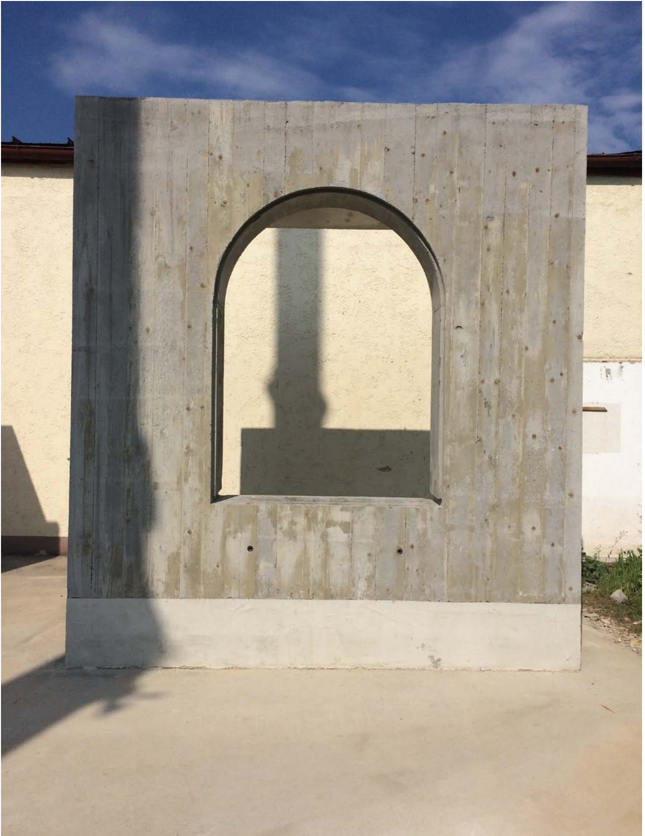
Außenseite der Betonwand nach dem Ausschalen
