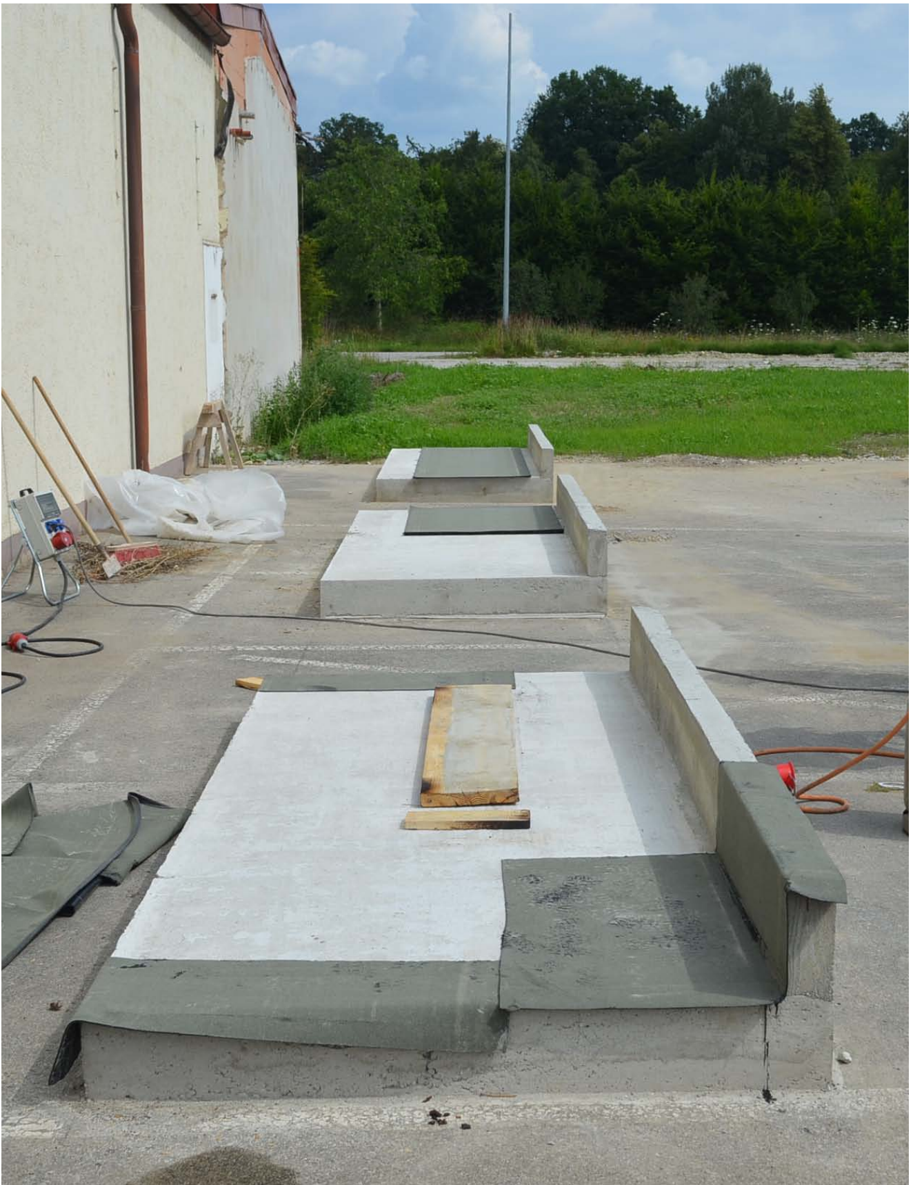
Fundamente für alle drei untersuchten Bauweisen
