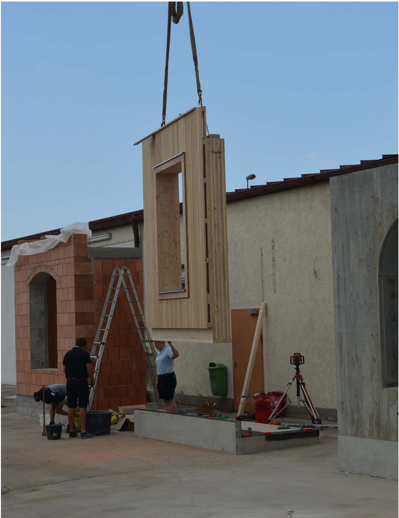
Montage der Außenwand aus Massivholz mit Außenverschalung
