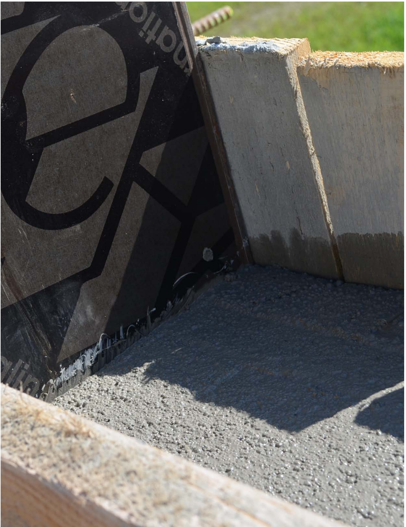
Oberkante der Wand zum Ende des Betoniervorgangs
