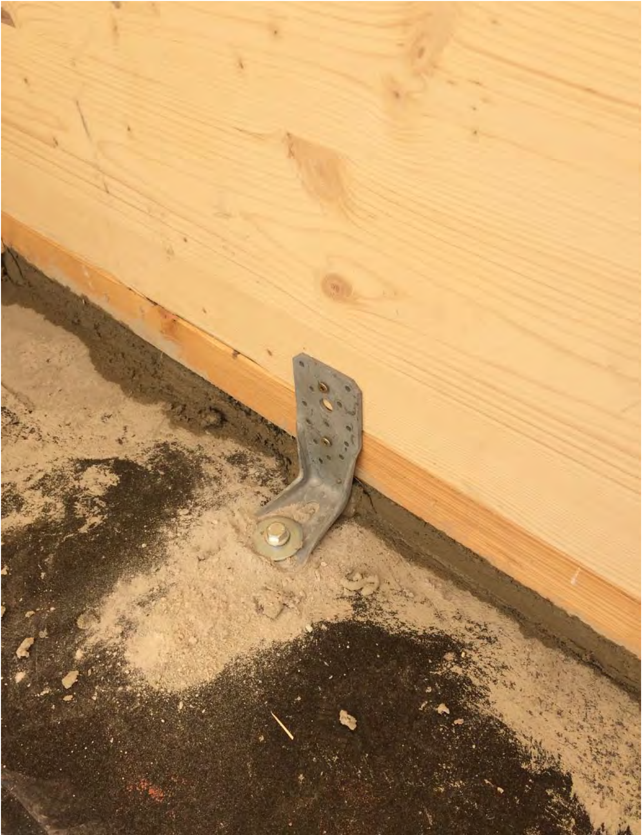
Ausmörteln der Lagerfuge
