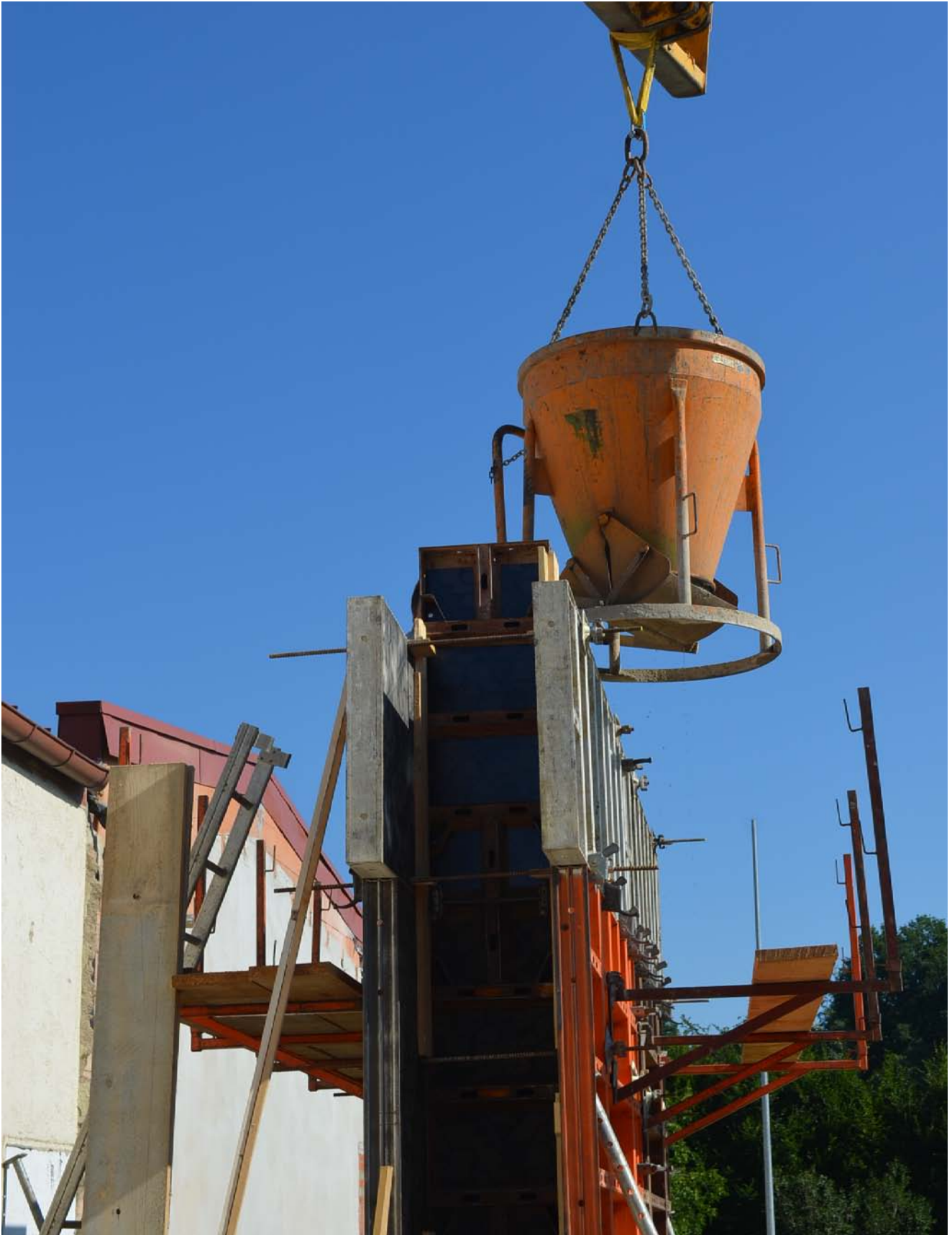
Betoniervorgang Leichtbetonwand mit Kübel, da Infraleichtbeton nicht pumpfähig ist
