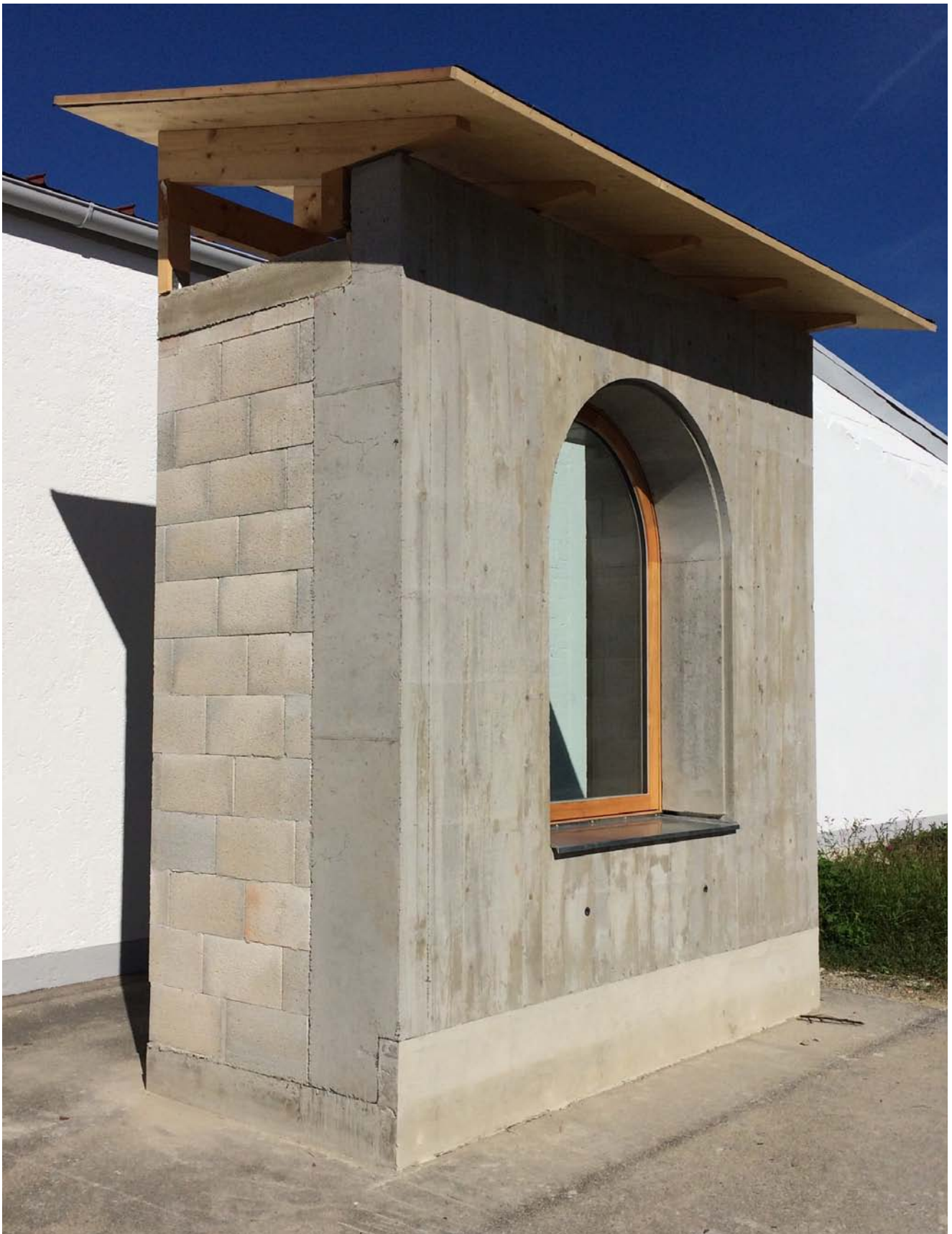
1:1 Modell Infralichtbeton
