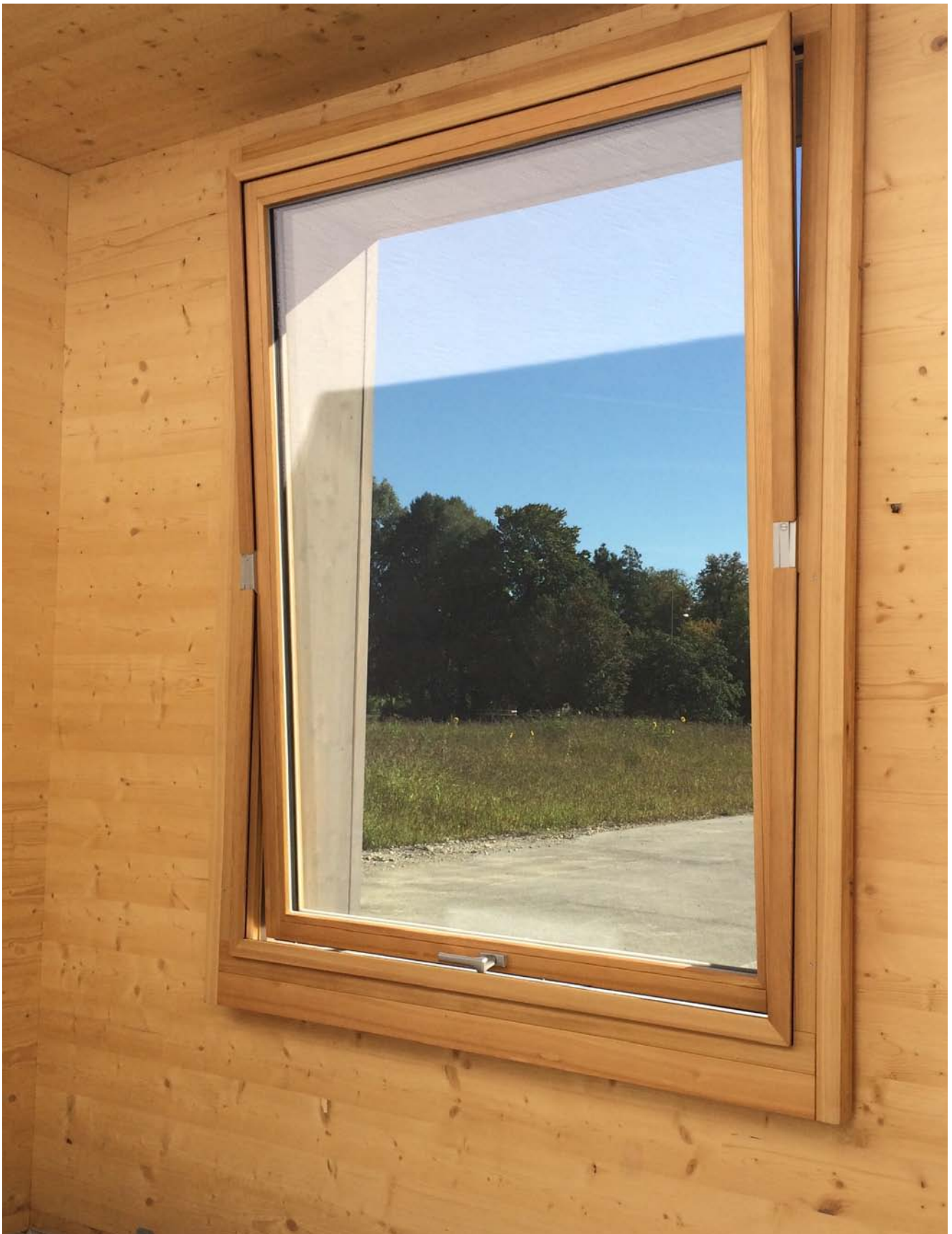
Massivholz: Lüftungsstellung Schwingflügel
