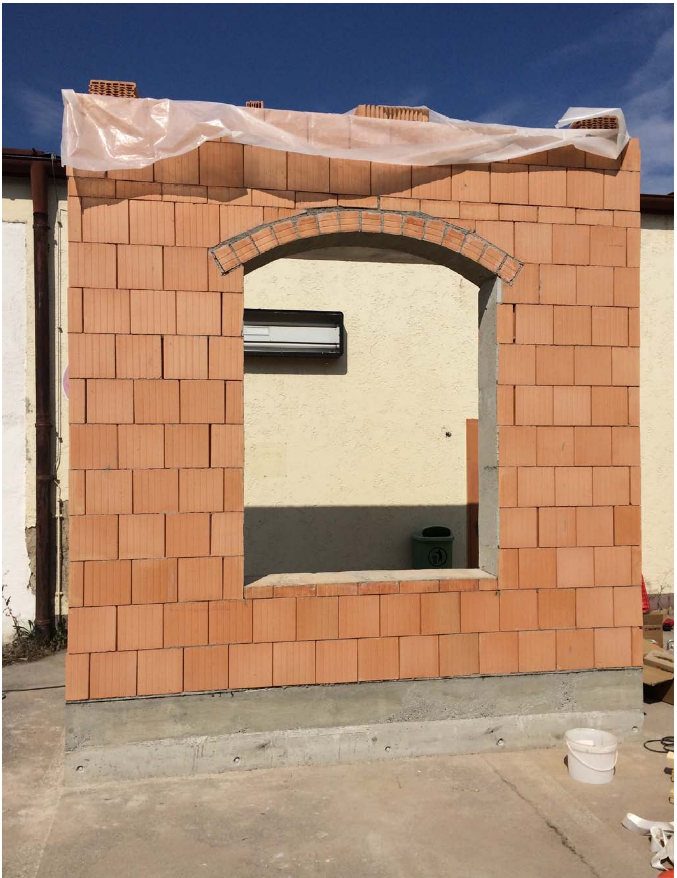
Fensteröffnung mit Segmentboden aus geviertelten Außenwandsteinen
