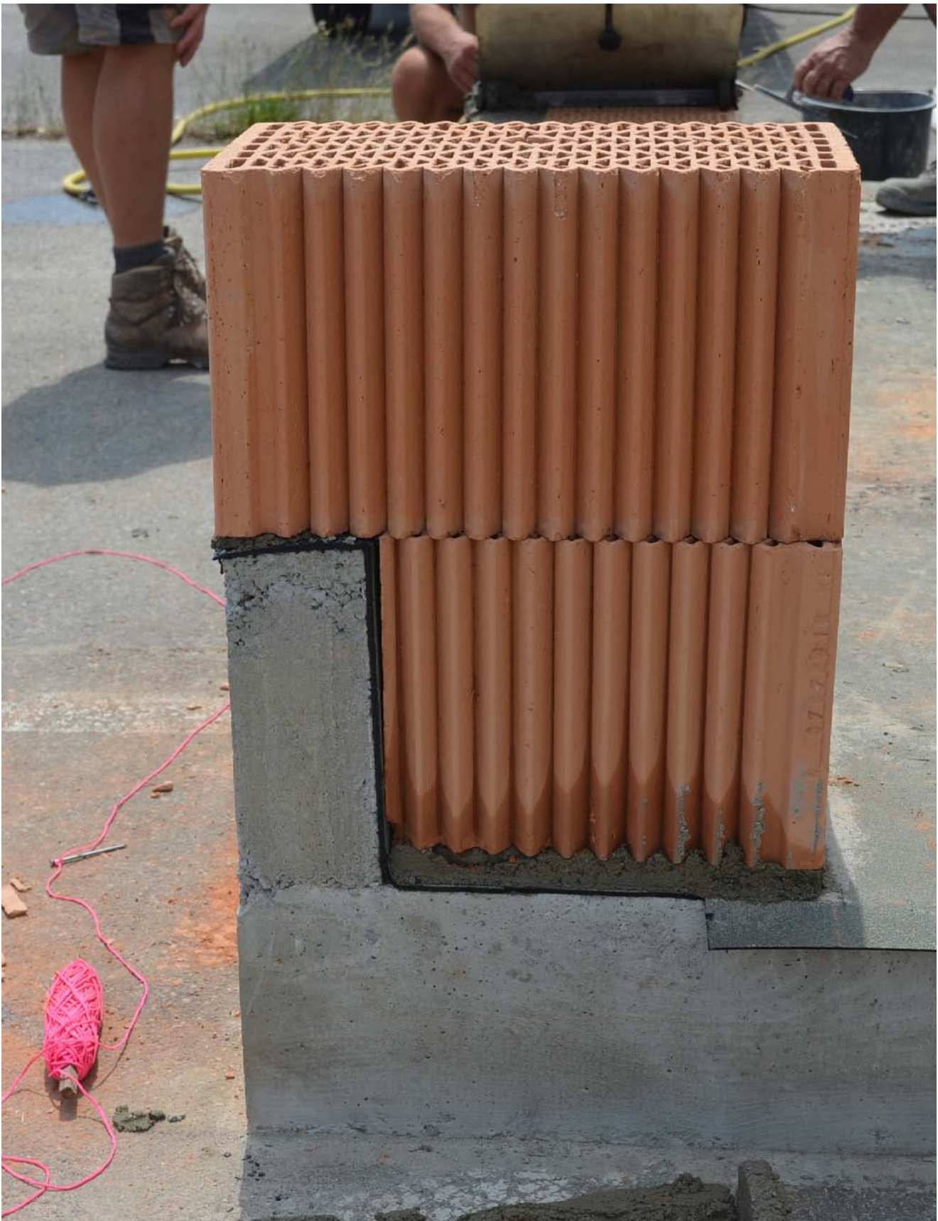
Fusspunkt Mauerwerk
