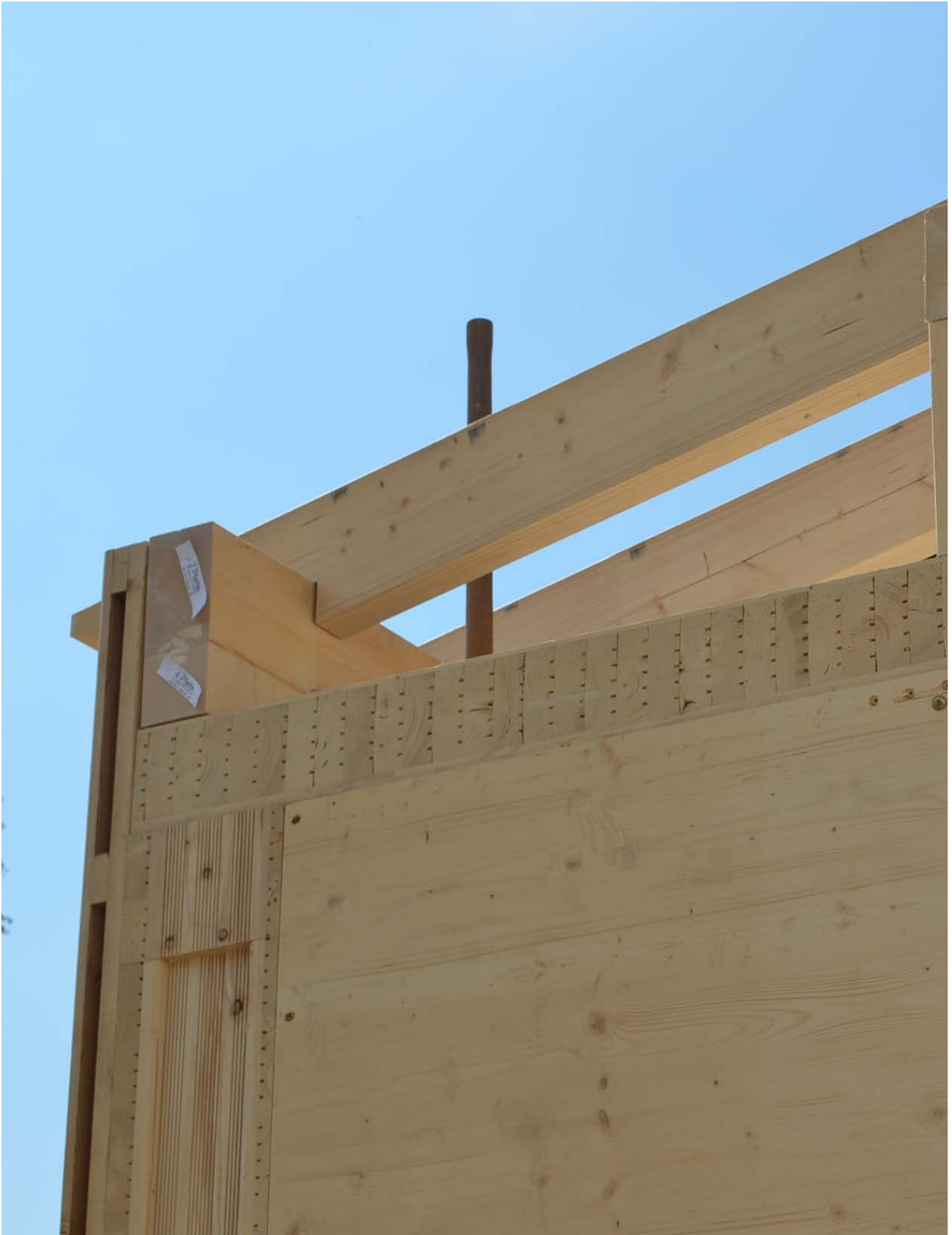
Außenwand, Trennwand, Decke und Dachstuhl
