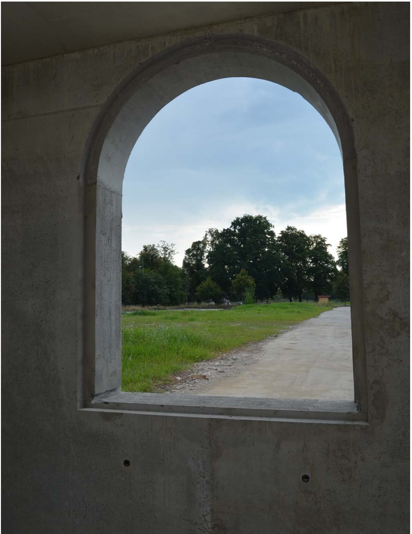
Innenseite der Betonwand nach dem Ausschalen
