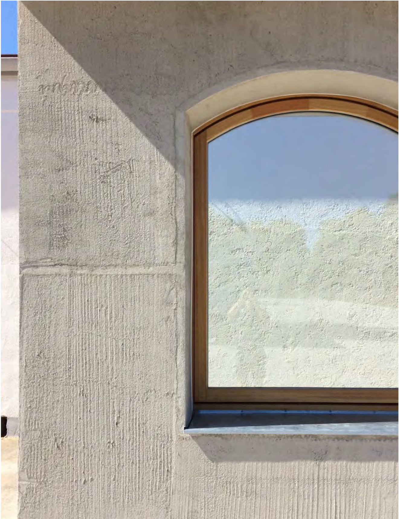
Außenwand Mauerwerk mit aufgebracht Putzschicht
