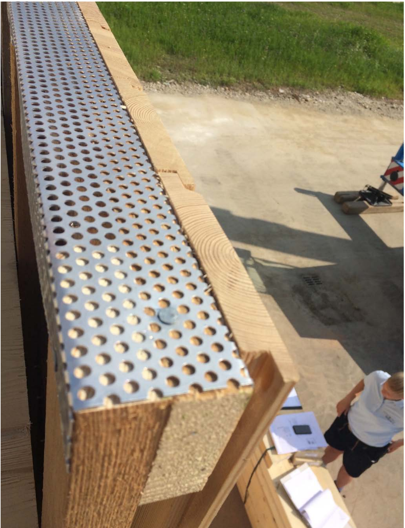
Lüftungsgitter und sägeraue Außenverschalung mit Falzen
