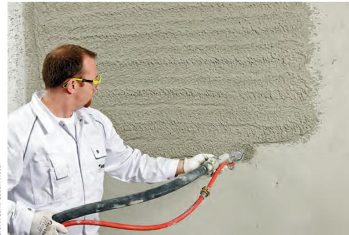
Bild 3: Hochleistungsdämmputz kann bis zu einer Dicke von 4 cm in einer Lage, in mehreren Lagen bis 10 cm Dicke aufgespritzt werden
