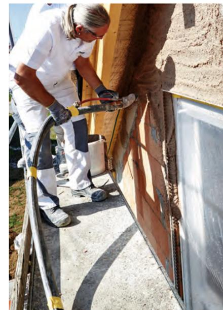
Bild 1: Speziell für hochwärmedämmendes Ziegelmauerwerk entwickelte Leichtputze ermöglichen schlanke, monolithische Wandkonstruktionen auf aktuellem Energiestandard
