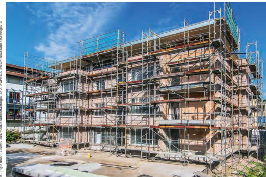
Bild 2: Diese Wohnsiedlung wurde mit hochwärmedämmtem Ziegelmauerwerk und einem speziellen Leichtunterputz vom Typ III realisiert. Durch die Kombination beider Systeme konnte das angestrebte Energieniveau erreicht werden
