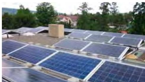
Die speziell behandelte Glasoberfläche der PV-Module von Innotech Solar sorgt für hohe Erträge von Photovoltaikanlagen mit O/W-Ausrichtung. Gerade bei dem flacheren Sonneneinstrahlungswinkel in den Morgen- und Abendstunden produzieren die Module mit dem Spezialglas bis zu 8% mehr Strom. Anders als bei nach Süden ausgerichteten Solaranlagen entstehen keine Ertragsspitzen in
