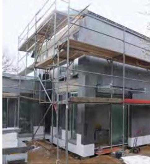
Die neuen und alten Außenwände wurden mit einem WDVS versehen und bekamen einen anthrazitfarbenen Anstrich mit einer Spezialfarbe, die auch dunkle Farben auf WDVS ermöglicht
