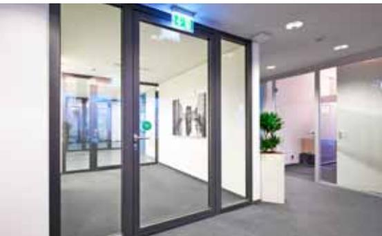
Lichtdurchlässig, aber rauchdicht: Die Feuerschutztüren als Brand- und Rauchschutzabschlüsse zwischen Treppenhaus und Bürotrakt sind in T30 respektive T90 ausgeführt. Optische Unterschiede sind jedoch nicht erkennbar.
