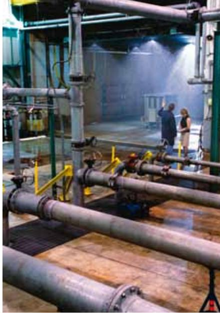
Die Hydraulikpumpanlage im FM Global Research Campus erlaubt großdimensionierte Brandtests mit Sprinkleranlagen.
