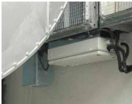
Steuerelektronik für Druckregelklappen
