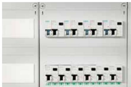
**Abb. 3: Vier Brandschutzschalter „5SM6“ von Siemens (im Schaltschrank oben) gewährleisteten Sicherheitsstandards, die deutlich über die bestehenden VDE-Richtlinien hinausgehen.**
