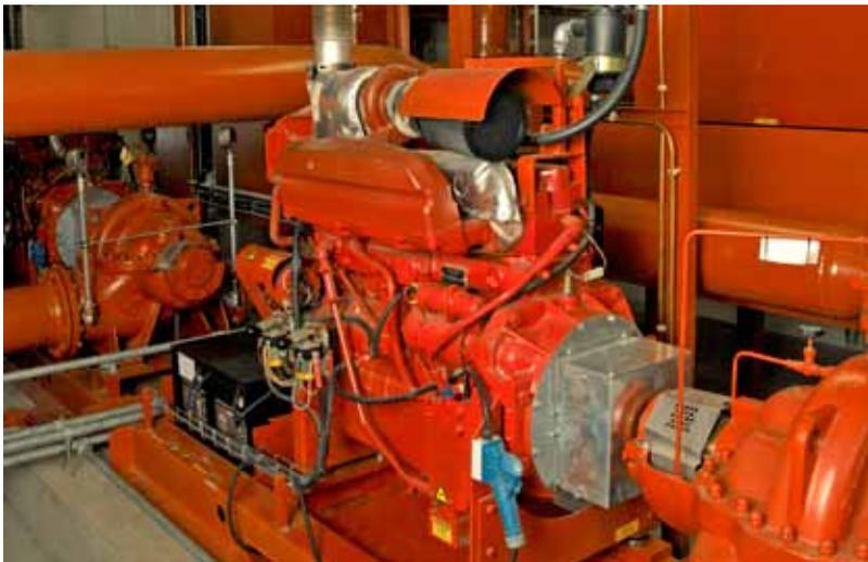
Zwei Dieselpumpen mit einer Nennleistung von 9450 l/min. versorgen die Ringleitung im P&G Werk Rothenkirchen mit einem Wasserdruck von mehr als 8 bar.
