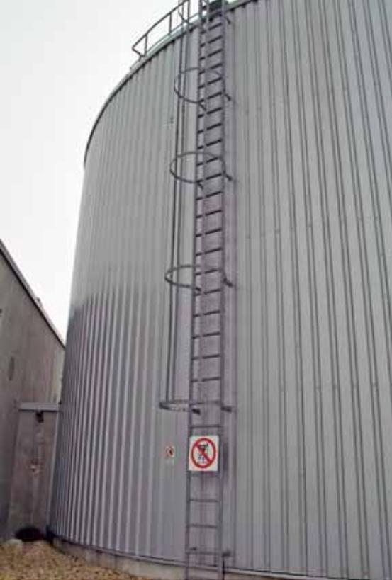
Rund 1200 m<sup>3</sup> fasst dieser Löschwassertank und sorgt so für ausreichende Verfügbarkeit des Löschmittels.
