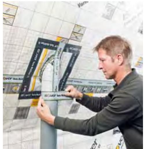
Durchdringen elektrische Leitungen oder Rohre die Abdichtungsebene diffusionsdichter oder -gebremster Systeme, muss die Öffnung in der diffusionshemmenden Folie sorgfältig abgedichtet werden
