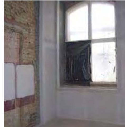
**Bilder von der Ausführung:** links die freigelegte Außenwand zur Dämmung durch die Deckenebene hindurch, mittig eine mit Ausgleichsputz versehene Wand fertig zum Anbringen der Innendämmung, rechts die eingebrachte Innendämmung mit der Flankendämmung der einbindenden Wand
