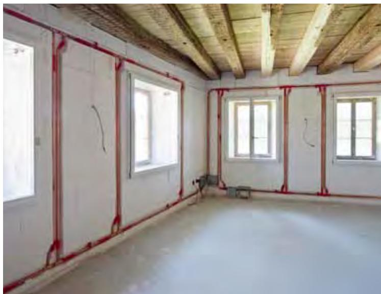
Um die Fenster herum wurden dünnere Perliteplatten aufgebracht. In den so entstandenen Schlitzen verlaufen die Kupferrohre für die Wandheizung
