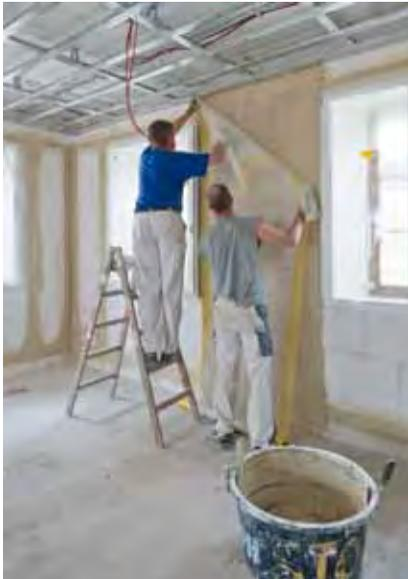
**Der Auftrag der diffusionsoffenen Beschichtung bildet den oberen Abschluss**
