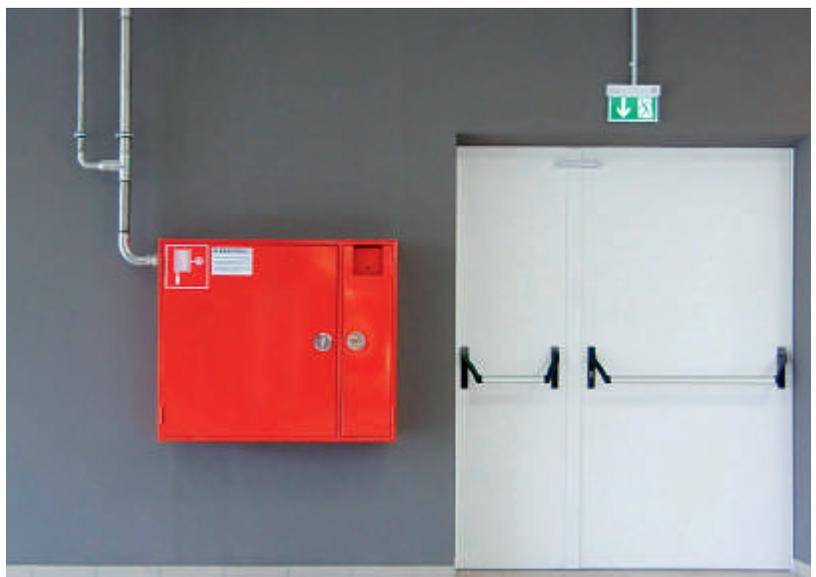
Löschwasseranlagen mit Wandhydranten ermöglichen erste Maßnahmen zur Brandbekämpfung. Die geltenden Normen und Regelwerke fordern hierfür allerdings auch die Erhaltung der Trinkwassergüte entsprechend der Trinkwasserverordnung.
