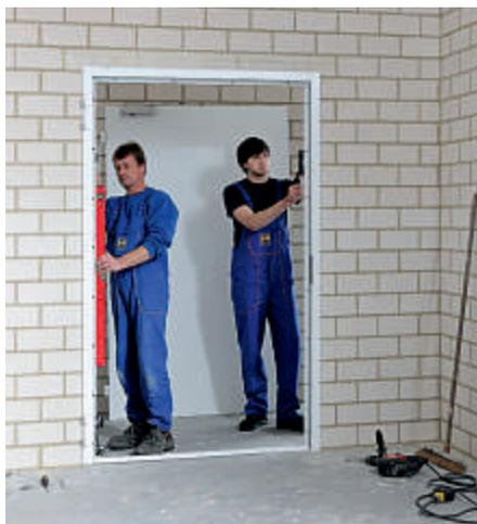
**Schritt 2 und 3: Justieren und Ausrichten der DryFix-Zarge. Die Dübellöcher werden durch die Zarge gesetzt. So muss die Zarge nicht noch einmal aus der Öffnung herausgenommen werden**
