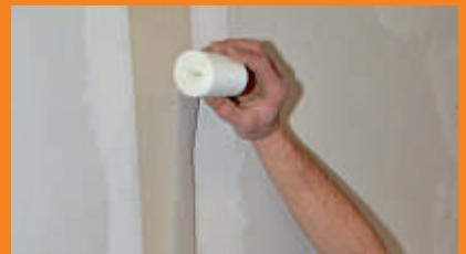
... die zum besseren Verspachteln leicht versenkt eingeschraubt werden sollten. Dazu wird zunächst feiner Miprotec-Fugenfüller mit der Glättkelle aufgetragen, ... in den anschließend Bewehrungsstreifen (Gitter oder Vlies) eingelegt werden können.
