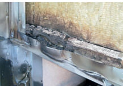
Horizontale Brandsperre über dem Fenstersturz in einer Zinkfassade auf Metallunterkonstruktion.
