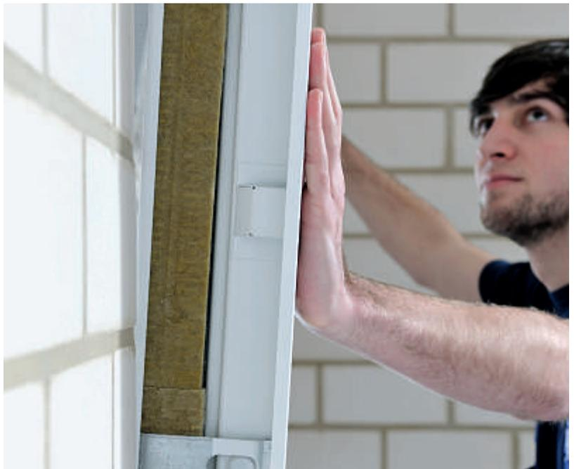
**Schritt 1: Einstellen der Zarge in der Öffnung. Ab Werk mit Steinwolle hinterfüllte Zargen (DryFix) für Stahlblech-Türen eignen sich für Sichtmauerwerk, da sie nicht vermörtelt werden müssen. Das vermeidet Verschmutzungen und damit einhergehende Reklamationen**
