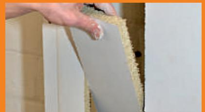
Was hier gut zu sehen ist: Statt feinen Staubs entsteht bei Säge- und Schneidarbeiten an Miprotec-Platten (hier für eine Hohlwanddose bzw. einen rechteckigen Ausschnitt) nur ein wenig krümeliger Abfall, der sich leicht aufsaugen oder durch fegen entfernen lässt. Die Baustelle bleibt im Übrigen sauber.
