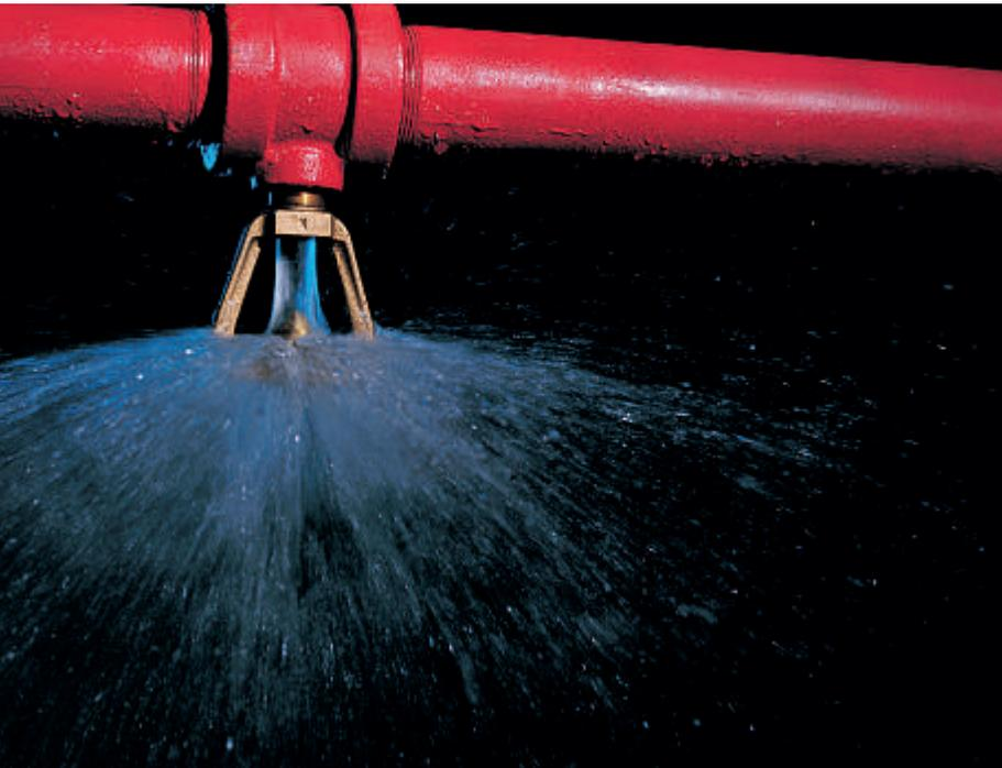
Insbesondere für Lagerhallen gilt: Der effektivste Brandschutz erfolgt durch Sprinkler. Diese kontrollieren den Brandherd frühzeitig und verhindern, dass sich die Flammen in der gesamten Halle ausbreiten.
