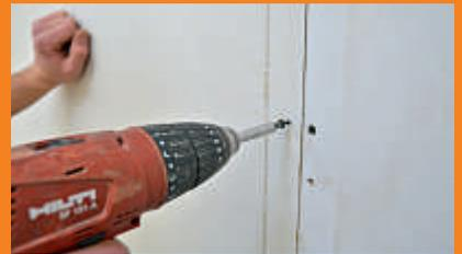
Zum Zuschnitt werden die Platten mit einem Cuttermesser eingeritzt und anschließend geknickt. An einer Metallständerkonstruktion lassen sich Miprotec-Platten mit handelsüblichen Schnellbauschrauben befestigen, ...
