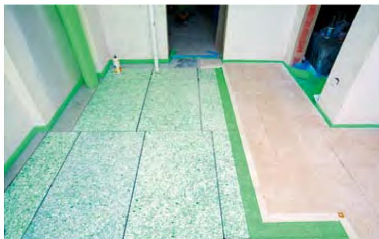
**Aus Platzgründen wurde statt der Kellerdecke bei dieser Sanierungsmaßnahme der Erdgeschossboden der Doppelhaushälfte gedämmt**
