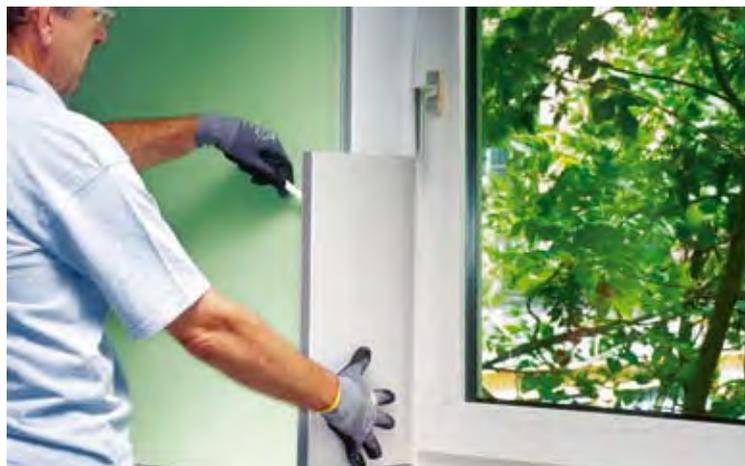
Laibungsdämmung als Wärmebrückendämmung in der Fensterlaibung bei einer Sanierung mit Innendämmung
