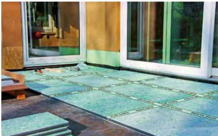
Wegen der geringen Aufbauhöhe konnte diese Außenterrasse bei einer Gebäudeaufstockung nur mit Vakuumisulationspaneelen gedämmt werden
