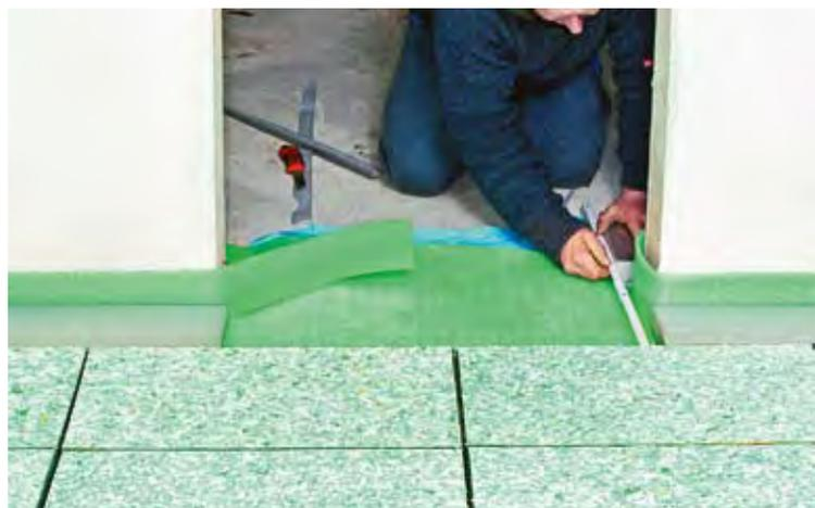
**Fußbodendämmung mit Vakuumisulationspaneelen als Dämmung des Fußbodens unter Trockenestrich in einem Wohnhaus aus den 1960er Jahren**
