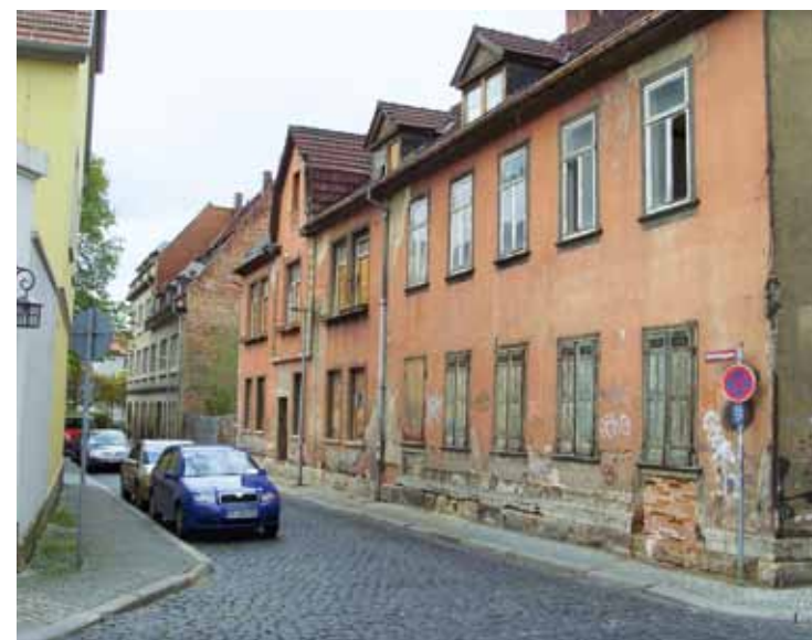
Die Bestandsbauten der Schottengasse vor der Sanierung 2009
