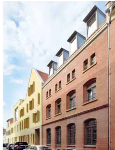
Bei dem Bestandsgebäude „Alte Schmiede“ wurde das ehemalige Flachdach durch ein neues Dachgeschoss mit Satteldach ersetzt
