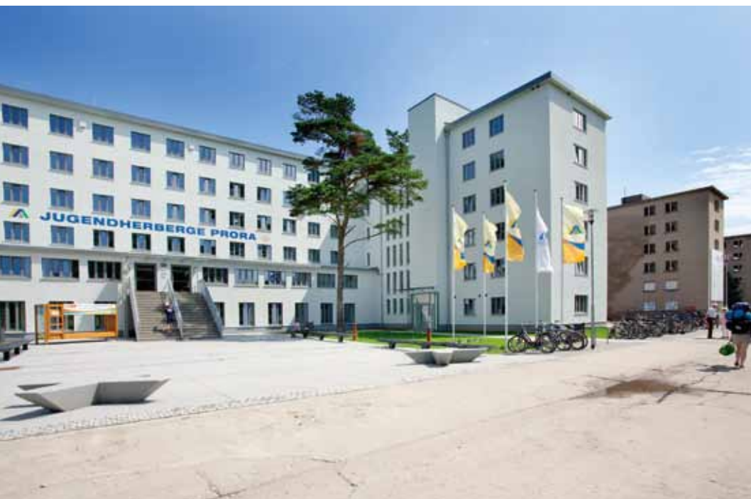
WDVS im Denkmalschutz: die heutige Jugendherberge Prora auf Rügen, Ende der 1930er Jahre errichtet
