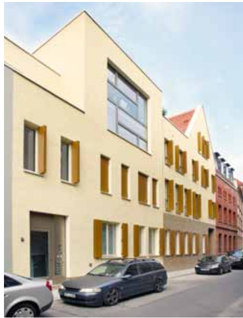
Der Neubau verbindet zwei Bestandsgebäude und vermittelt in den Höhen, der Dachform und nimmt Gestaltungselemente wieder auf
