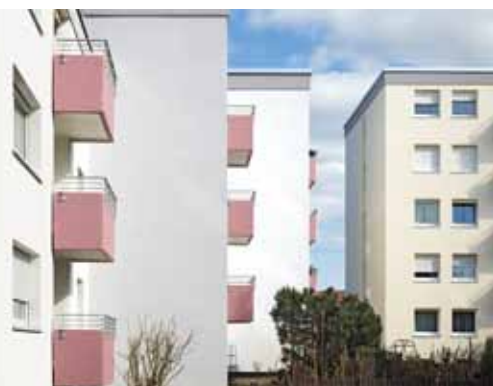
Wohnanlage Darmstadt: Sanierung einschaligen Ziegelmauerwerks aus den 1970er Jahren
