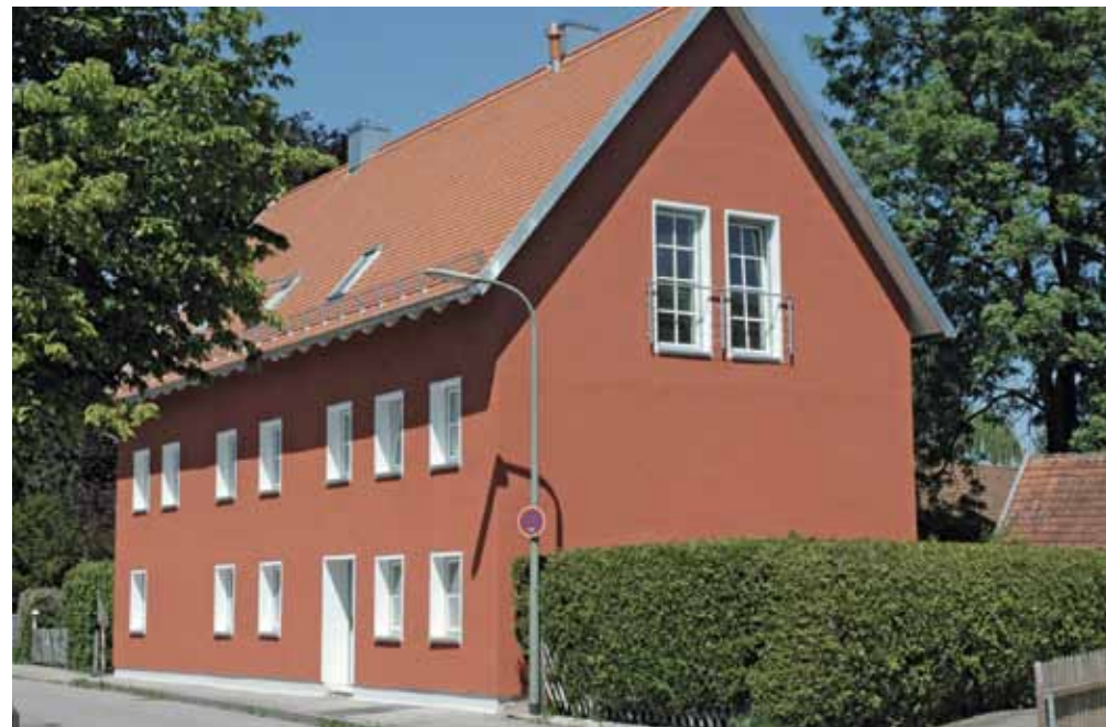
Ziegelhaus um 1900 energetisch auf dem neuesten Stand; Arch. Finn Hansen, Landsberg
