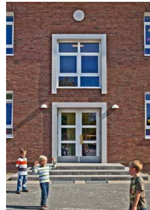
Dekorprofile ersetzen schadhafte Schmuckeinfassungen an Öffnungen
