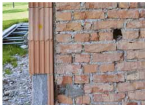
Ziegel mit Füllung aus Perlit
