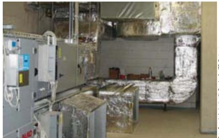
Die Außenluft für die Belüftung des Gebäudes wird über einen Erdwärmetauscher (B) angesaugt und für den Heiz- und Kühlfall vorkonditioniert
