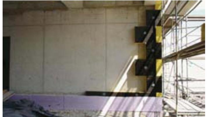
Anschluss der Außendämmung an die Perimeterdämmung in Dübel-Montage
