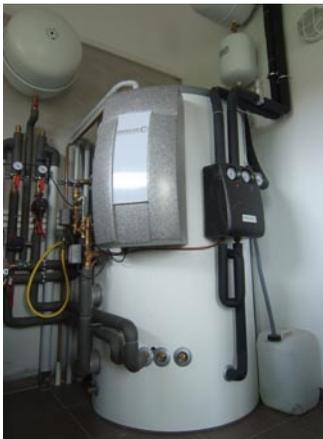
Der bivalente Betrieb einer Wärmepumpe (hier in Verbindung mit Solarthermie) kann die Gesamteffizienz einer Anlage wesentlich erhöhen
