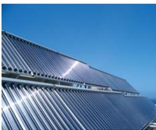
Nur mit Sonnenenergie warmes Wasser für ein Hotel mit 132 Zimmern bereitzustellen, bedarf selbst im sonnigen Mittelmeerraum einer großen Ausbeute an Solarwärme. Letztlich ist diese weitgehende Unabhängigkeit von konventionellen Energieträgern aber nur eine Frage des Systems und der richtigen Bemessung: Für den als Green Building konzipierten Neubau des Hotels „The George“ auf Malta wurde eine solare Großanlage realisiert, die den täglichen Bedarf von rund 10000 l Warmwasser zu 93% deckt.
