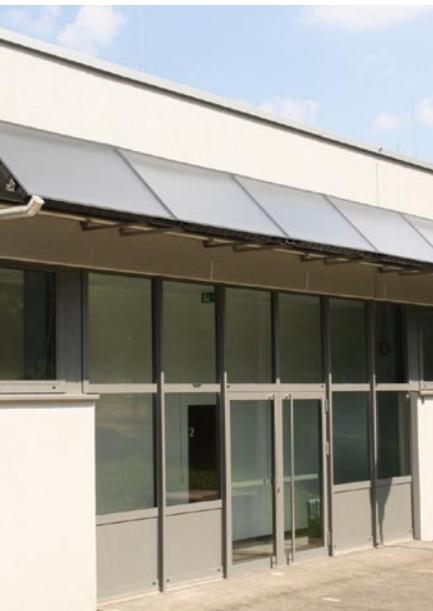
Acht Flachkollektoren unterstützen die Warmwasserbereitung und Heizwarmwasserbereitung
