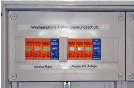
Professionelle Lösung eines Überspannungsschutzsystems, getrennt nach den Ableitern für das Haus und die PV-Anlage
