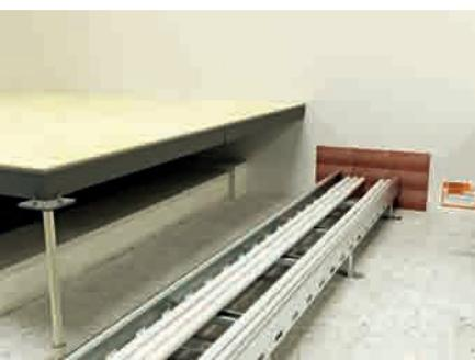
**Bild 2:** Abschottung in einer massiven Wand unterhalb eines Systembodens
