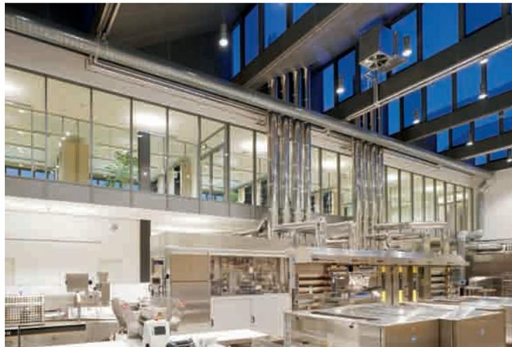
**Bild 7:** Kompetenzzentrum Martin Braun KG, Hannover: F30-Brandschutztrennwand zwischen dem Rettungs- und Erschließungsflur des Business-Bereichs (1. OG) und dem im Kern des Gebäudes angesiedelten „Mehl- und Backzentrum“
