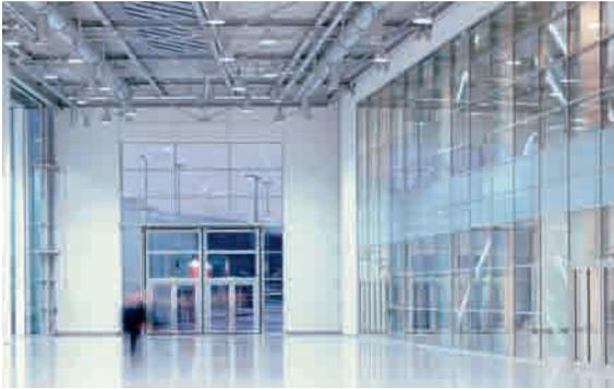
**Bild 3: Brandschutztechnische Abtrennung zum Schutz vor Feuer und Rauch: Eine 15 m hohe F30-Fassade mit T30-Türsystemen (rechts) separiert das Congress Centrum Nord der Kölnmesse von dem angrenzenden Messeboulevard**
