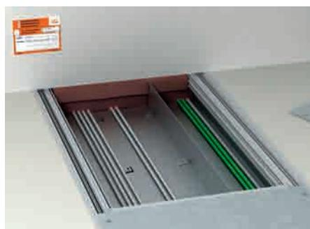
**Bild 3:** Estrichbündiger Unterflurkanal mit Abschottung aus Schaumstoffblöcken
