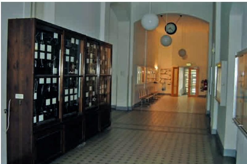
**Bild 6: Notwendiger Flur in einem Hochschulgebäude mit zunächst unzulässigen Brandlasten im notwendigen Flur. Im Rahmen einer Gefahrenanalyse sind das tatsächliche Risiko und die möglichen Kompensationsmaßnahmen festzustellen**
