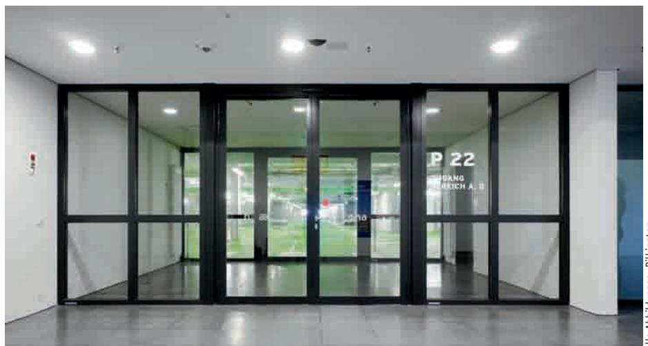
**Bild 6:** Erhöhte Brandlasten: F90-Schleusen mit großflächigen Brandschutzverglasungen sichern die Zu- und Ausgänge des unterhalb von Eingang Ost gelegenen Parkhauses der Landesmesse Stuttgart
