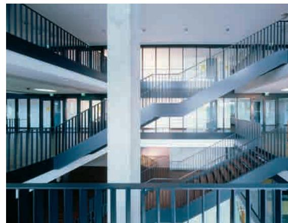
**Bild 2:** Erschließungszone und Flucht-/Rettungsweg im Haupttribünenbereich der Commerzbank-Arena: Zum Schutz des Fluchtweges sind die transparenten Abtrennungen zu den angrenzenden Nutzungszonen je nach Brandlast als F30- bzw. G30-Systeme ausgeführt
