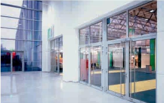
**Bild 4: Typische Übergangssituation von den Messehallen zum Boulevard: Zweiflügelige T30-Türsysteme mit großflächigen Oberlichtern schützen vor einer Übertragung von Feuer und Rauch auf den als Fluchtweg genutzten Messeboulevard**
