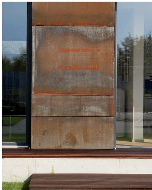
Für die Verklebung der Stahlplatten wurde in Abstimmung mit dem Passivhausinstitut eine Sonderlösung entwickelt
