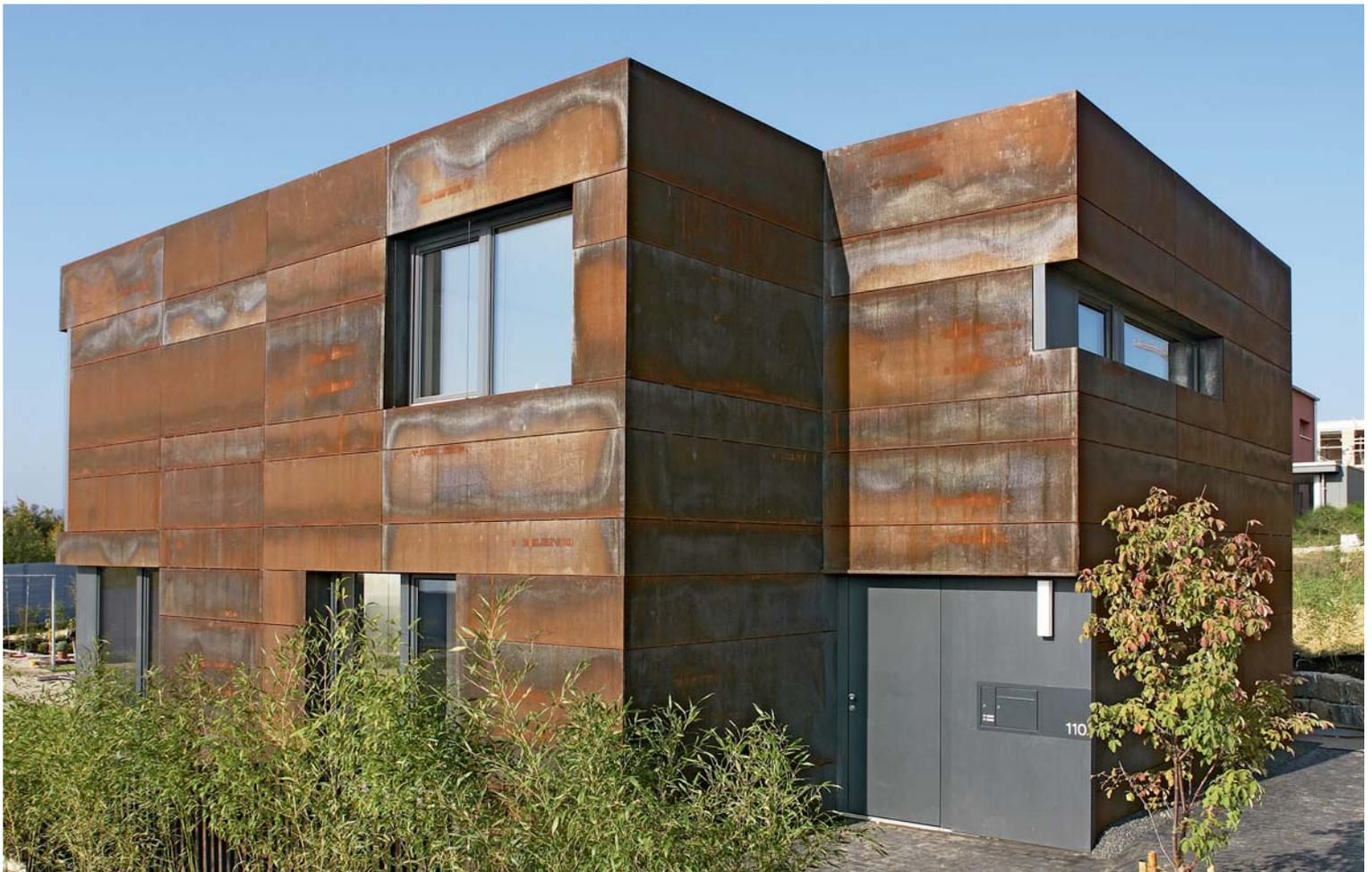
Die Hülle aus oxydierendem Stahl schimmert je nach Wetterlage mal schimmernd, mal stumpf, mal glänzend oder abweisend rau
