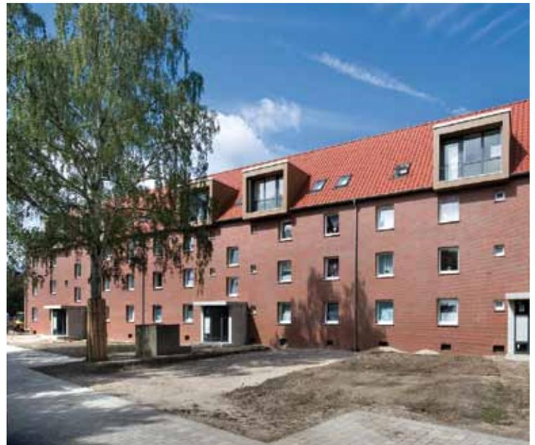
Die U-förmigen Betonrahmen und die im oberen Geschoss eingebauten Boxen strukturieren die Fassaden der modernisierten Wohnbauten
