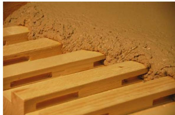
**Abb. 80** Massivholz-Hybriddecke mit Detail Flächenverbund
