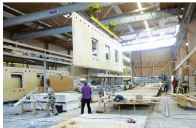
Fertigung der Holzfassadenelemente
