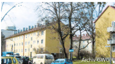
Gebäudebestand vor der Modernisierung
