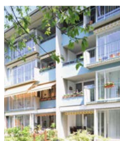
Energetische Ertüchtigung der Balkonfassade
