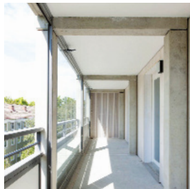
Loggien: wesentlicher Baustein zum Schallschutz
