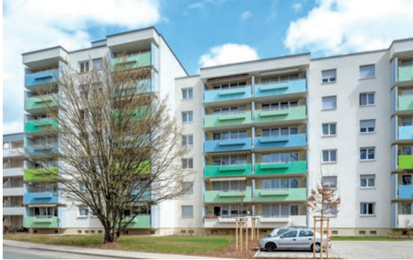
Fürth, FinkenPark Fürth Wohnsiedlung, 1968/1970er Jahre Bauherr: Evangelisches Siedlungswerk Bayern, Nürnberg Planung: ESW Bauplanung GmbH, Nürnberg
