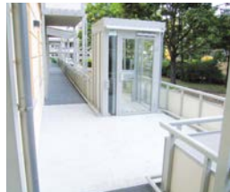
Barrierefreie Erschließung durch neu errichteten Laubengang mit Aufzug, inkl. Erreichbarkeit der Kellerräume
