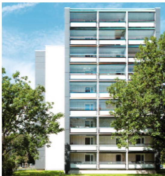
Die großflächig vor das Gebäude gestellten Loggienkonstruktionen sind Temperaturpufferzonen.
