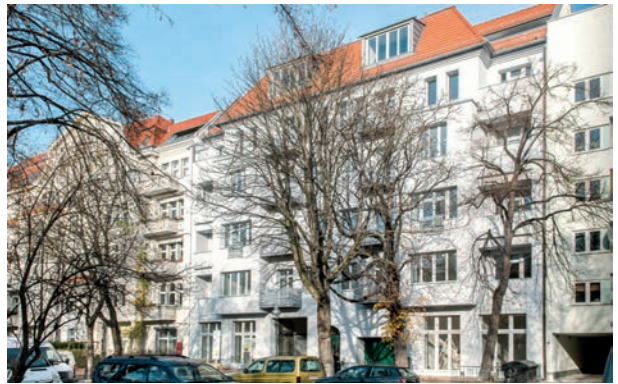
Berlin, Paul-Lincke-Ufer Mietwohnungen, Gründerzeit Bauherr: Gebrüder Moll GmbH & Co. KG, München Planung: Thomas Hillig Architekten, Berlin
