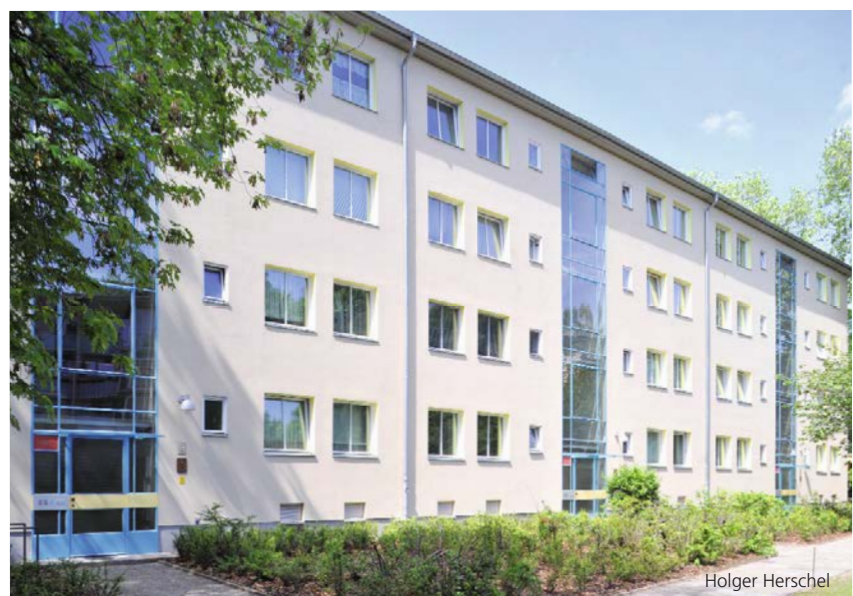
Eingangsfassade mit bauzeitlicher Farbgebung der Fensterleibungen
