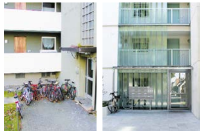
Die Eingangsbereiche wurden neu gestaltet (links vor der Modernisierung)
