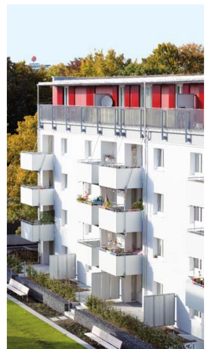
Aufstockung der Bestandsgebäude in Holzbauweise
