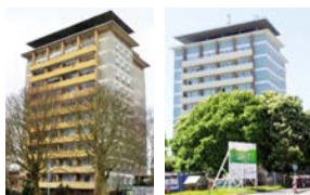
Die Strömungsplatte (zweites Dach) hat heute keine Funktion mehr - wurde aus Denkmalschutzgründen jedoch saniert.
