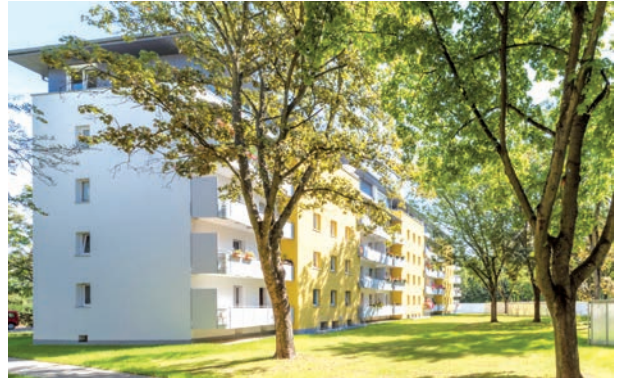
Regensburg, Guerickestraße, Jannerstraße Wohnsiedlung, 1950er Jahre Bauherr: Evangelisches Siedlungswerk Bayern, Nürnberg Planung: ESW Bauplanung GmbH, Nürnberg
