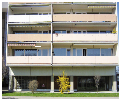
Mit der Dämmung der Balkonbrüstungen, dem Einbau von Multifunktionsfenstern und neuen Markisen erhielt der Gebäudekomplex ein zeitgemäßes Äußeres.
