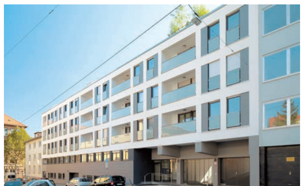
Stuttgart, Heusteigstraße Umnutzung eines Verwaltungsgebäudes zu Wohnungen Bauherr: Stuttgarter Lebensversicherung a.G. Planung: Project GmbH, Esslingen
