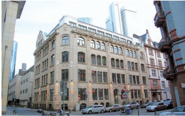
Frankfurt am Main, Elbstraße Umgestaltung Bürohaus, Wohnen und Gewerbe, Gründerzeit Bauherr: Jürgen Zoubek, Maintal Planung: Architektenkontor Faller & Krück, Frankfurt am Main
