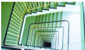
Denkmalgerechte Sanierung des Treppenhauses
