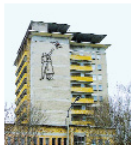
Gebäudebestand vor der Modernisierung
