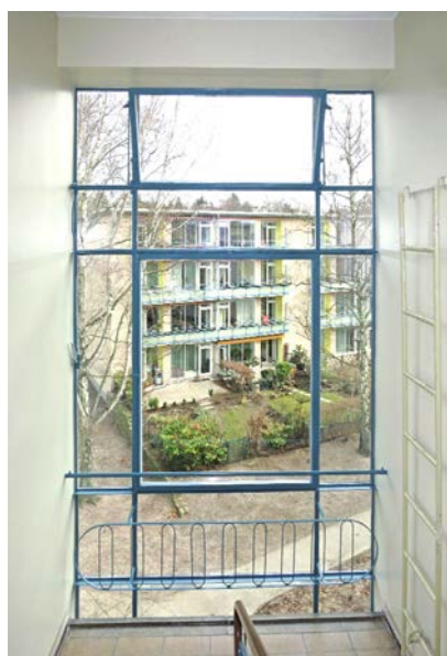
Erhalt der filigranen Treppenhausverglasungen
