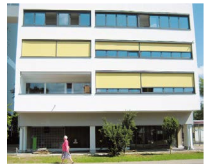
Mit der Dämmung der Balkonbrüstungen, dem Einbau von Multifunktionsfenstern und neuen Markisen erhielt der Gebäudekomplex ein zeitgemäßes Äußeres.
