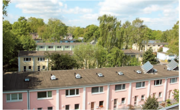
Hamburg, Feldschmiede, Meilerstraße Reihenhausanlage, 1950er Jahre Bauherr: Mietergenossenschaft Gartenstadt Farmsen eG Planung: Uwe Jentz, Hamburg
