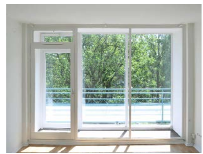
Blumenfenster und wiederhergestellte Brüstungsverglasung
