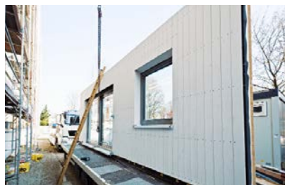
Transport der Holzfassadenelemente
