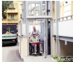
Barrierefreie Erschließung durch neu errichteten Laubengang mit Aufzug, inkl. Erreichbarkeit der Kellerräume
