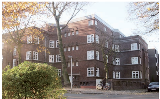
Gelsenkirchen, Liebfrauenstraße Denkmalschutzensemble Mehrfamilienhäuser, 1920er Jahre Bauherr: Denkmal Liebfrauenstraße GmbH & Co. KG, Dortmund Planung: TUSCH ARCHITEKTEN UND INGENIEURE DÜSSELDORF
