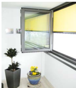
Die Loggien wurden durch Faltenfenster verglast und können in der kalten Jahreszeit als Wintergärten, im Sommer als offene Balkone genutzt werden.
