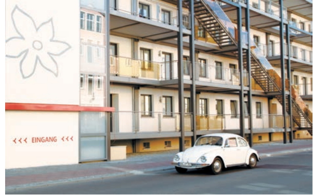
Brandenburg an der Havel, Bahnhofsvorstadt Wohnquartier, 1950er Jahre Bauherr: WOBRA Wohnungsbaugesell. der Stadt Brandenburg Planung: S&P Sahlmann Planungsgesellschaft f. Bauwesen, Leipzig
