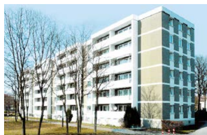
Bestand vor der Sanierung
