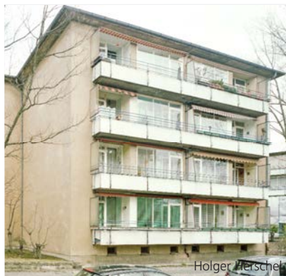
Balkonfassade vor der Modernisierung
