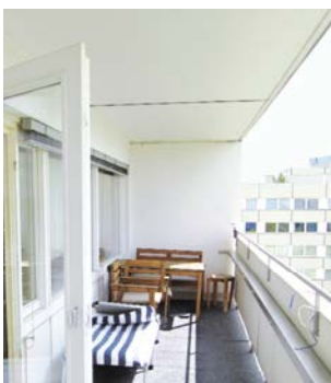
Die Loggien wurden durch Faltenfenster verglast und können in der kalten Jahreszeit als Wintergärten, im Sommer als offene Balkone genutzt werden.
