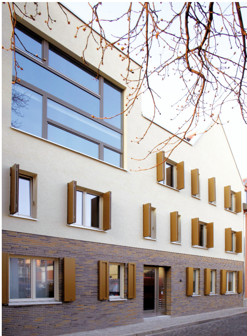
Neuer Stadtbaustein als Verbindung der Bestandsbauten
