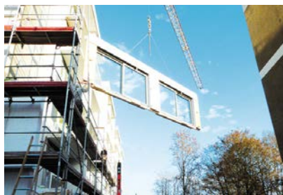
Montage des vorgefertigten Bausystems
