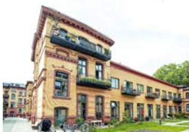
Sanierung nach historischem Vorbild
