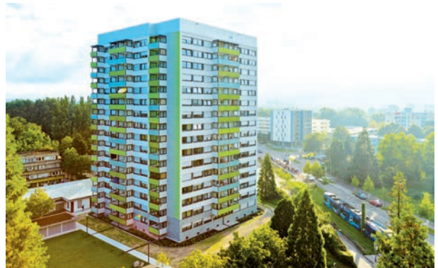
Freiburg, Bugginger Straße Passivhausanierung Hochhaus, 1950er Jahre Bauherr: Freiburger Stadtbau GmbH Planung: Architekturbüro Rombach, Kirchzarten
