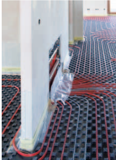
Kleine Öffnungen für den Einbau von Heizkreis- oder Installationsverteilern werden ohne Abminderung der zulässigen Wandmaße nachträglich ausgesägt oder wandbegleitend angelegt. Dabei müssen die lichten Öffnungsmaße kleiner sein als 1/4 der Wandhöhe oder der Wandlänge bzw. die gesamte Öffnungsfläche muss kleiner sein als 1/10 der Wandfläche. Rückseitig werden die Öffnungen mit dem Füll- und Zargengips FG 70 geschlossen und ggf. verspachtelt.
