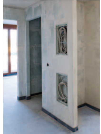
Kleine Öffnungen für den Einbau von Heizkreis- oder Installationsverteilern werden ohne Abminderung der zulässigen Wandmaße nachträglich ausgesägt oder wandbegleitend angelegt. Dabei müssen die lichten Öffnungsmaße kleiner sein als 1/4 der Wandhöhe oder der Wandlänge bzw. die gesamte Öffnungsfläche muss kleiner sein als 1/10 der Wandfläche. Rückseitig werden die Öffnungen mit dem Füll- und Zargengips FG 70 geschlossen und ggf. verspachtelt.
