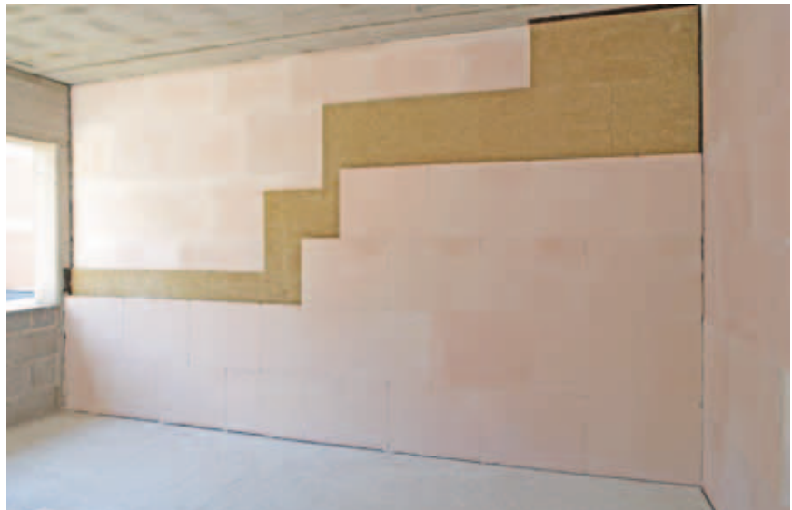
Zweischalige Trennwand als Schallschutzkonstruktion WD.60.60 während der Ausführung in einem Hotelneubau. Mit R_{wP} 62 dB liegt die raumbildende Konstruktion deutlich oberhalb selbst der erhöhten Schallschutzanforderungen nach DIN 4109 Beiblatt 2 (52 dB) sowie Schallschutzstufe 2 nach VDI 4100. Dabei ist die MultiGips Systemwand nur 150 mm dick und selbst bei 3,30 m Geschosshöhe noch eine leichte Trennwand nach DIN EN 1991-1-1 „Einwirkungen auf Tragwerke“.
