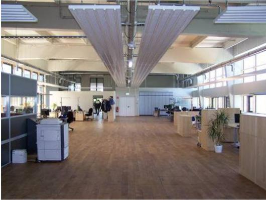
Bild: Deckenstrahlplatten im Obergeschoss
