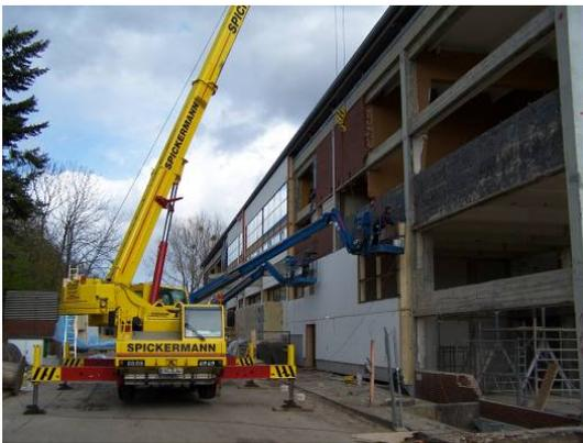
Bild: Montage der Fertigteilfassade
