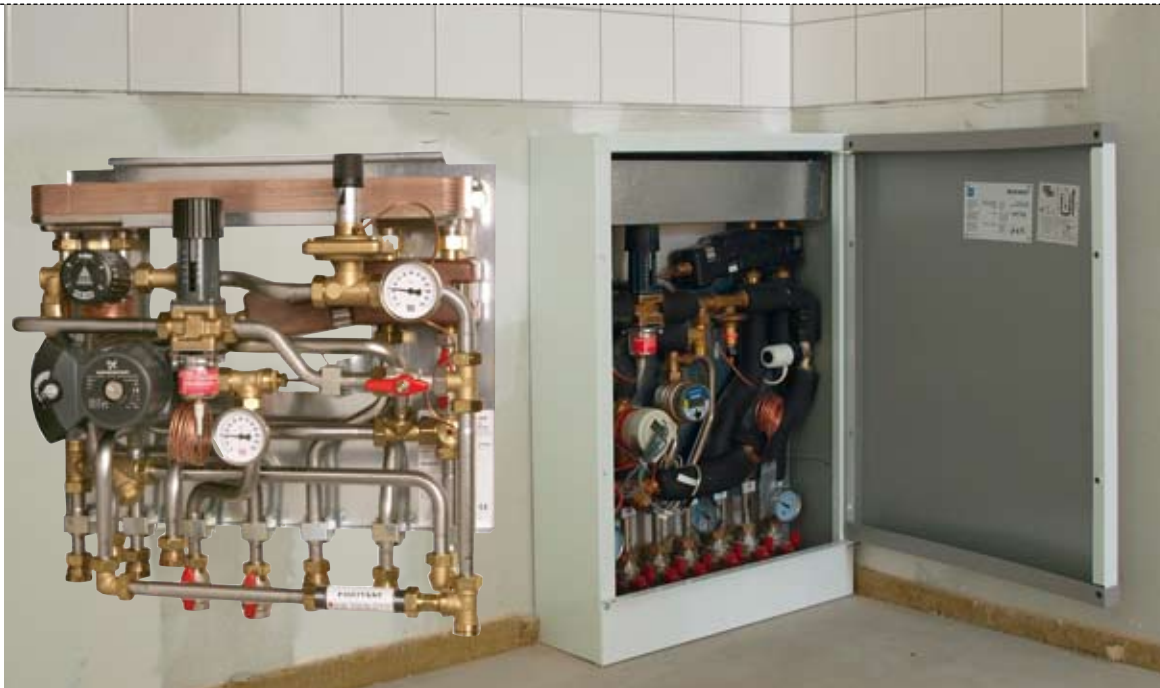
Die Wohnungsstationen sind komplette hydraulische Schnittstellen mit einem kompakten, hoch leistungsfähigen Plattenwärmeübertrager, der bei Zapfung sofort Warmwasser zur Verfügung stellt
