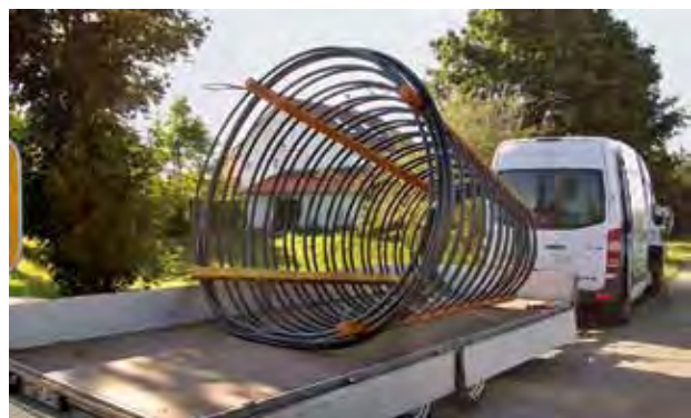
Mit zwei solcher Erdwärmekörbe wurde die Erdwärme auf dem Grundstück eingefangen
