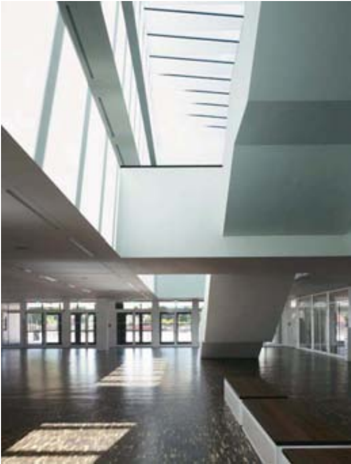
Tageslicht ersetzt weitestgehend künstliche Beleuchtung: durch einen Lichtschacht dringt Sonnenlicht bis ins Erdgeschoss und in die Pausenhalle
