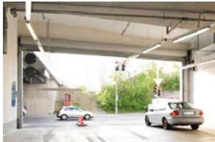
Hinter der Verkleidung liegen die T90-Tore „Teckentrup E“. Im Brandfall klappt die Nischenklappe auf und die Tore gleiten aus der Wand
