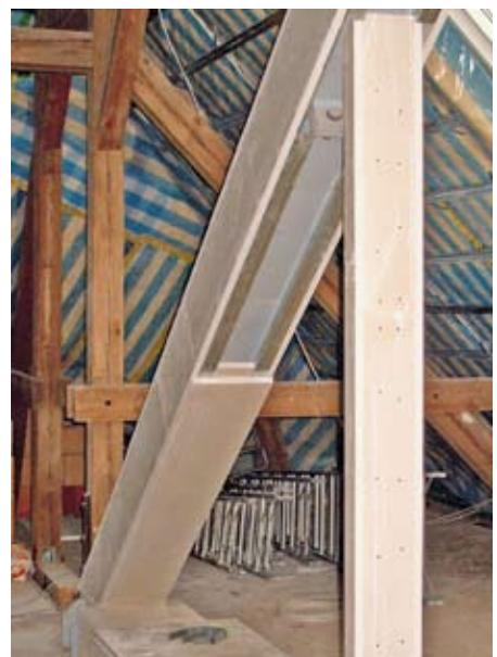
Die Stahlträger erhielten einen Mantel aus einlagig montierten, 25mm dicken „Glasroc F (Ridurit)“-Feuerschutzplatten und wurden so auf F 90-A ertüchtigt.
