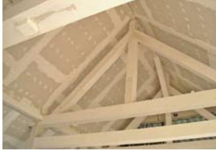
Für die Holzbalken sowie die Dachschrägen war eine F30-Beplankung aus Feuerschutzplatten ausreichend.
