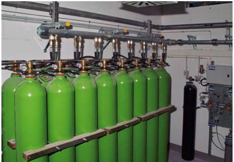
16 Gasflaschen mit dem Löschmittel Argonite stehen mit einem Druck von 300 bar bereit
