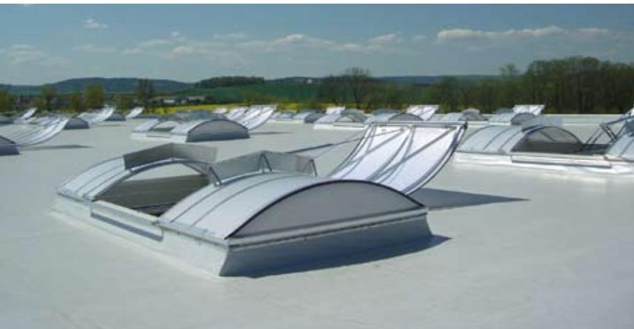
Flachdach mit Lichtbändern: Spezielle RWA-Beschläge ermöglichen die Öffnung der Lichtband-Klappen im Brandfall. Alternativ können sie auch zur täglichen Be- und Entlüftung eingesetzt werden
