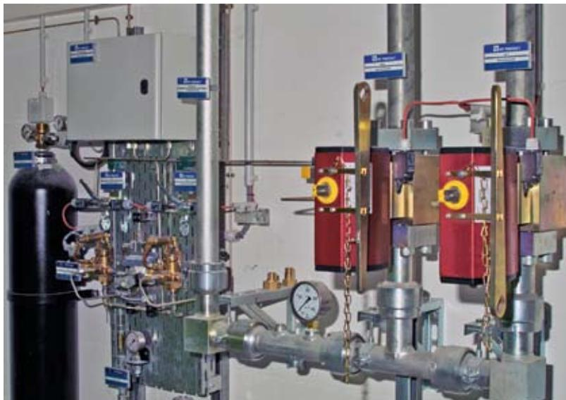
Die Serverräume des Klinikums in Offenbach werden durch eine "H-TIX aero"-Löschanlage geschützt
