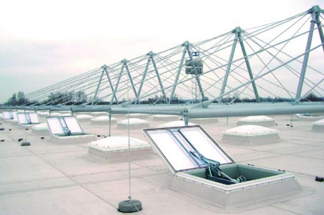
**Lichtkuppeln mit integrierten 24 Volt-RWA-Beschlägen: Diese Technik eignet sich besonders für anspruchsvolle Objekte, bei denen beispielsweise besonders große Klappen geöffnet oder hohe Schneelasten bewältigt werden müssen.**
