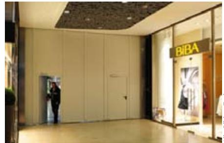
Ausgerüstet mit zwei schwellenlosen Schlupftüren, schließen die Tore die Brandabschnitte sicher ab, aber die Fluchtwege bleiben weiterhin begehbar
