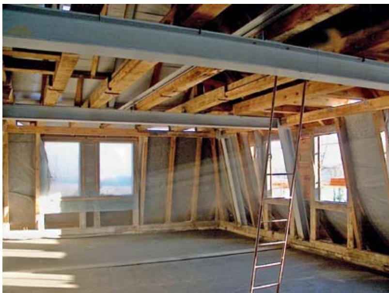
Grundschule Neuruppin: Zur Stabilisierung der Dachkonstruktion wurden zusätzliche Stahlträger in verschiedenen Abmessungen eingezogen. Die geplanten Brandschutzmaßnahmen mussten entsprechend sowohl auf die Stahlträgerkonstruktion als auch auf das vorhandene Holzgebälk abgestimmt sein.
