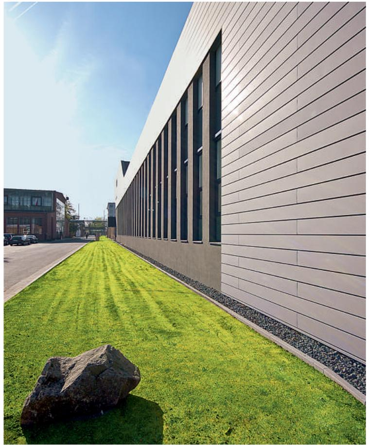
Die Neubaufassade besteht aus Zinktafeln aus dem Hause Umicore
