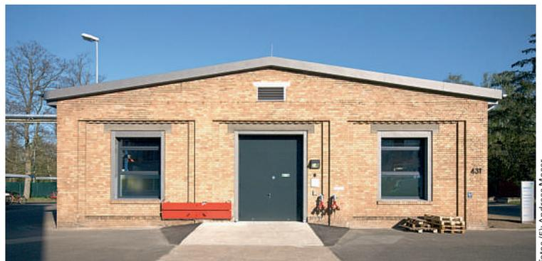
Die neuen Fenster im Altbau erhielten eine umlaufende Zinkeinfassung
