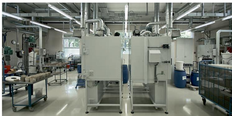
**Im Klimatisierungs- und Lüftungskonzept ergaben sich Einsparmöglichkeiten durch die räumliche Trennung von Bereichen mit unterschiedlichen Luftwechselraten und den Einsatz von Wärmerückgewinnungssystemen in den Lüftungsanlagen**
