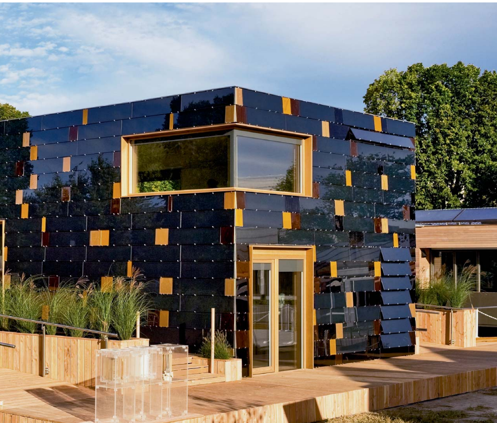
Die leistungsstarke Gebäudehülle erzeugt hochgerechnet 300 kWh/m²a im Jahr und damit ein Plus von ca. 250 kWh/m²a
