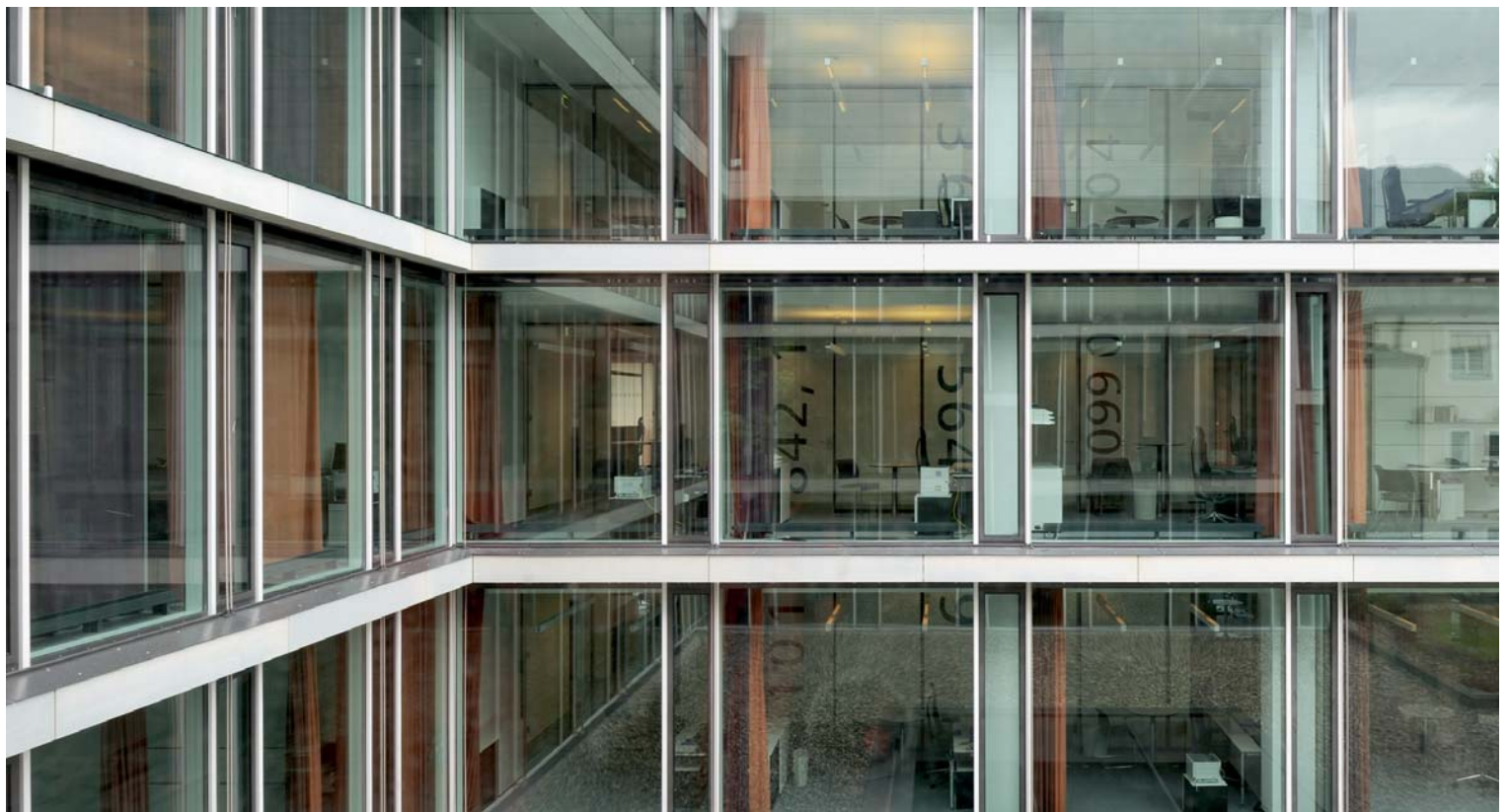
Im Winter sichern die Glasflächen einen hohen Wärmeeintrag, die farbigen Vorhänge dienen als nichtreflektierender Blendschutz
