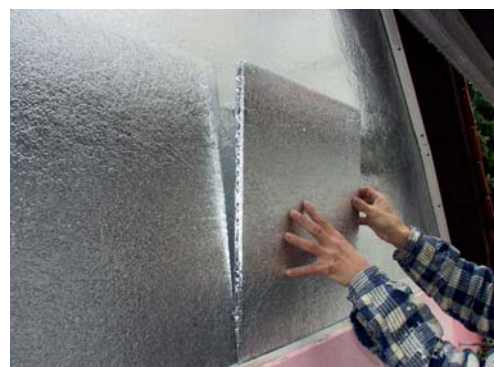
Einbau von VIP mit Hilfe eines Schienensystems
