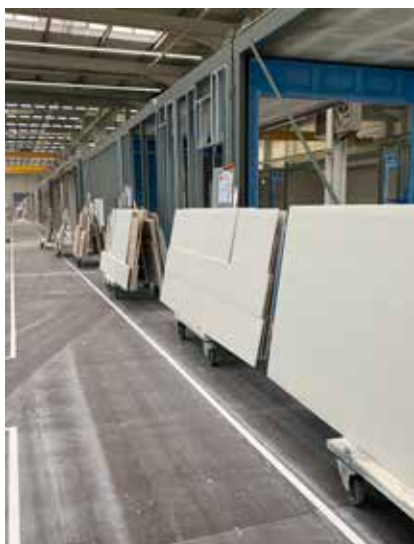
Foto: ALHO Bereitstellen der benötigten Ausbaumaterialien
