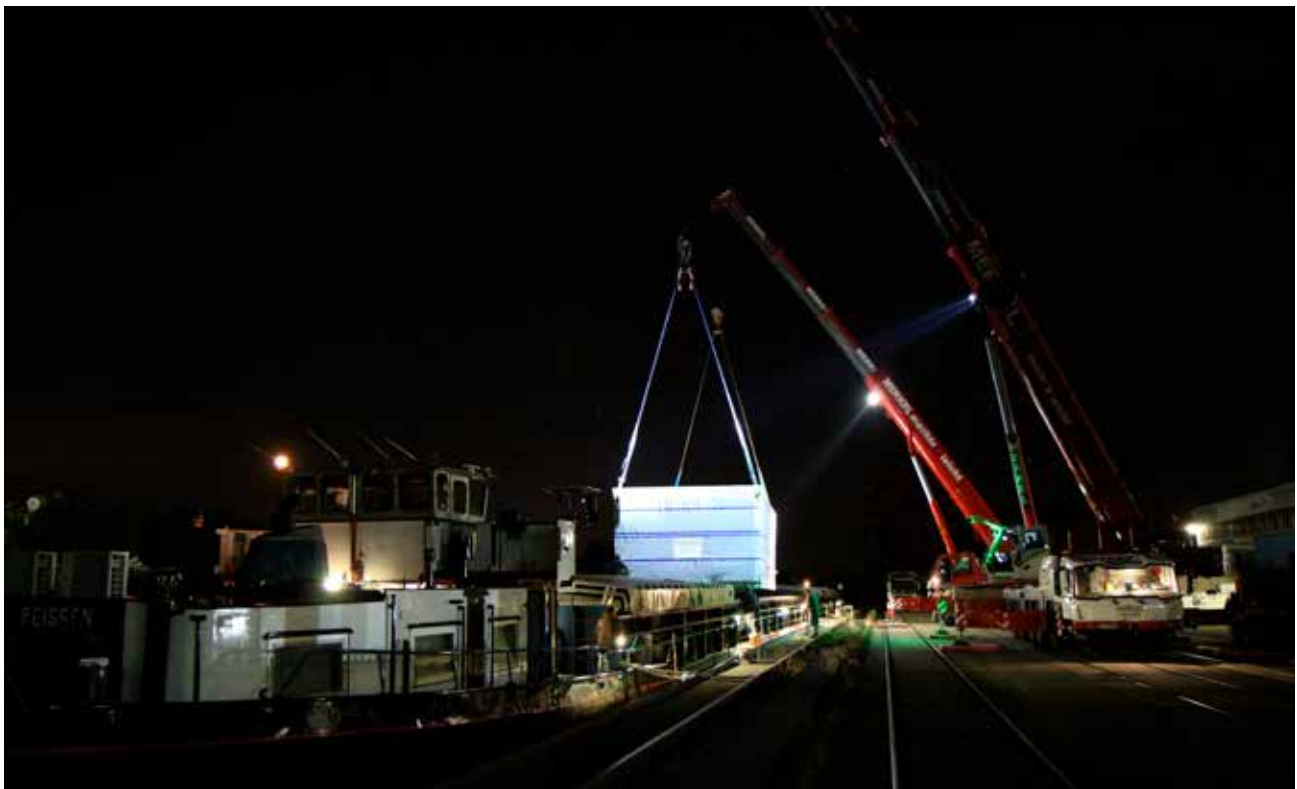
Foto: Cadolto Modulbau
