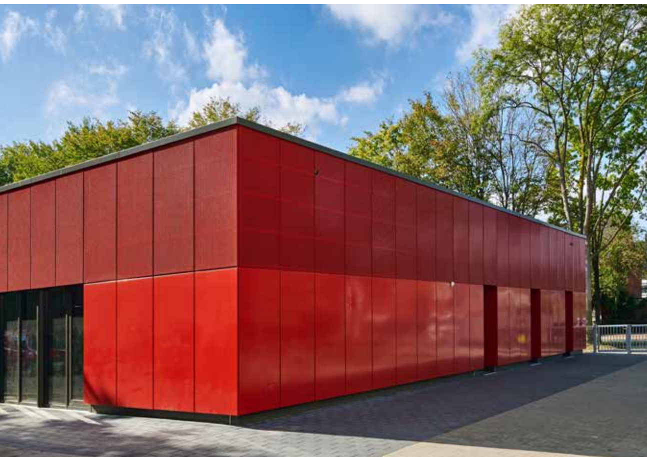
Neubau in Passivbauweise der Mensa für die Ganstags-Grundschule an der Alfrad-Faust-Straße mit vorgehängter Metallfassade
