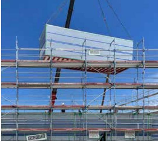
Foto: Cadolto Modulbau
