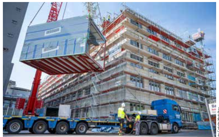
Foto: Cadolto Modulbau
