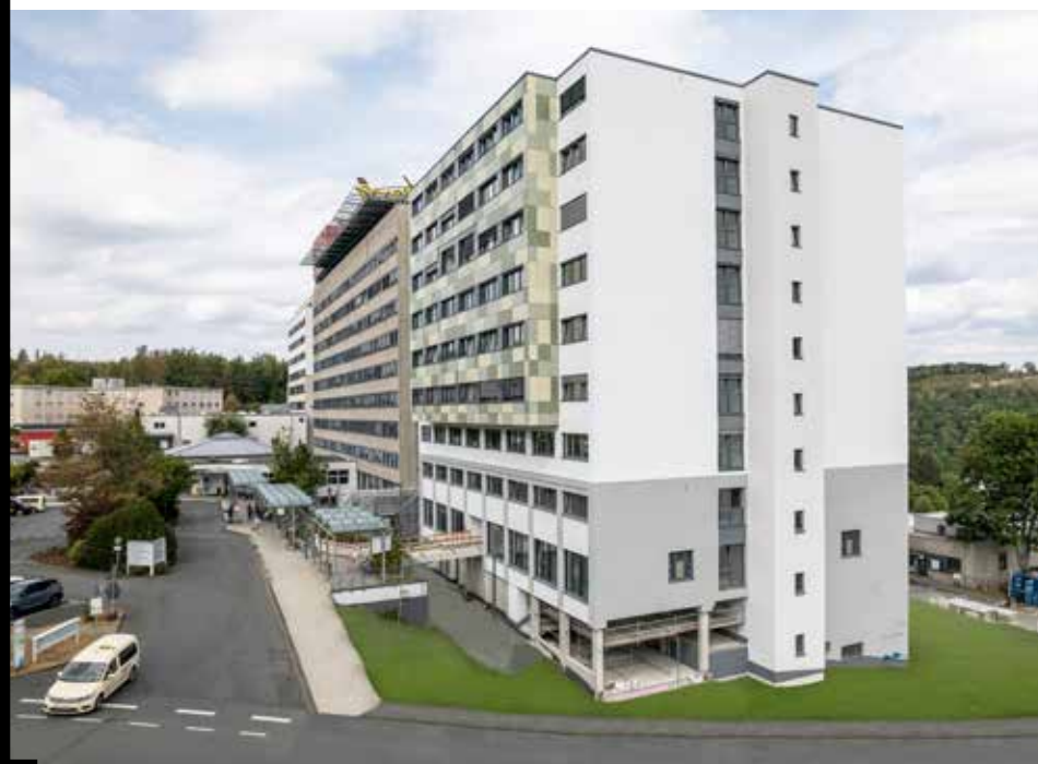
Das neue Bauteil G des Diakonie Klinikums Jung-Stilling in Siegen wurde im Südosten an das Bestandsgebäude angebaut. Fünf bauseitig errichtete Stahlbetongeschosse bilden die Basis für weitere sieben Modulbaugeschosse. Zusammen bieten die zwölf Etagen eine Bruttogeschossfläche von 12 000 m 2 ; davon entfallen 7 000 m 2 auf den Modulbau
