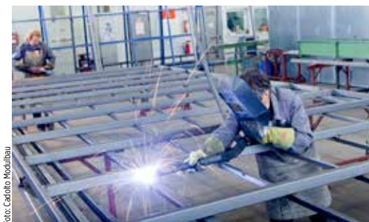
Schweißen der tra- genden Stahlelemente bei Cadolto
