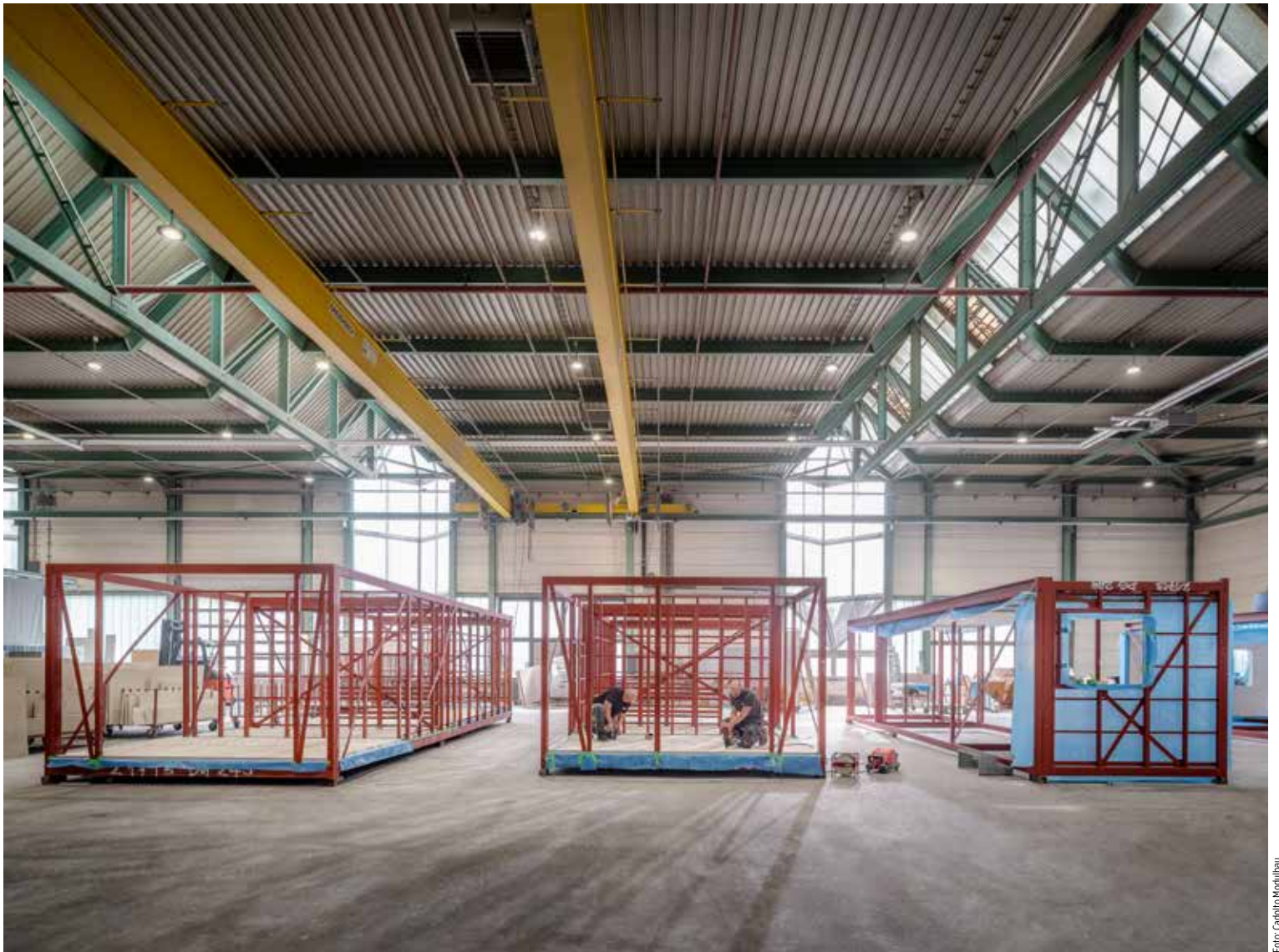
Foto: Cadolto Modulbau
