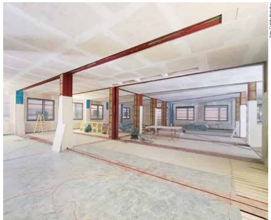
Foto: Cadolto Modulbau
