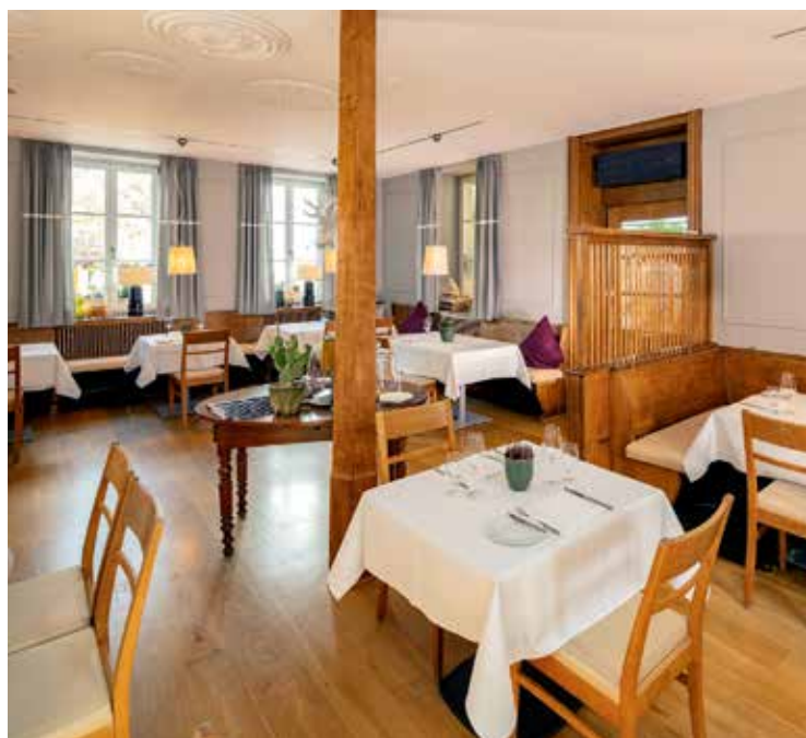
Besonders gemütliche Temperaturen dank nahezu zugluftfreier Luftverteilung im Raum – die VRF-Technologie sorgt für optimales Raumklima.
