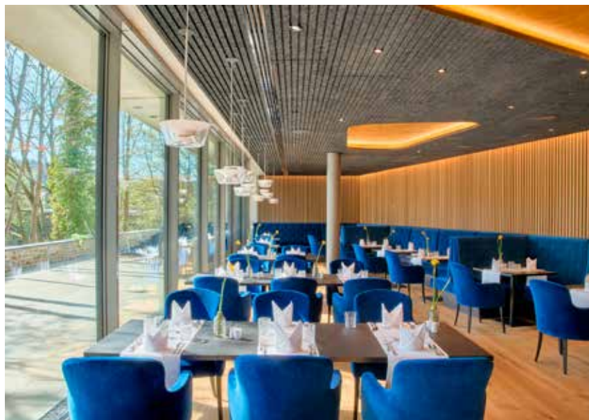
Im Restaurant des Emser Thermenhotel erhellen besonders stark entblendete und somit unauffällig in die Decke integrierte Downlights die Tische. Dank engstrahlender Optiken werden die Speisen akzentuiert beleuchtet
