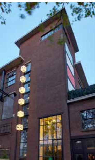
Der Aufzugturm wirbt mit seiner Beleuchtung für das neue Hotel auf dem ehemaligen Philips Gelände
