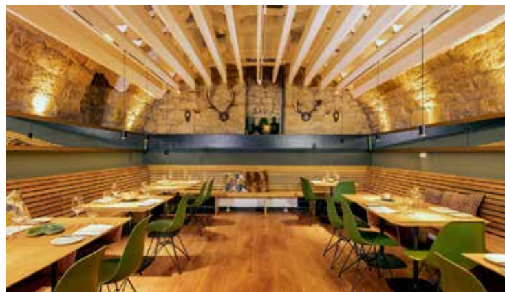
Die Lossnay-Lüftungsanlage versorgt den Gewölbekeller des Hotels energiesparend, effizient und hygienisch mit Frischluft.
