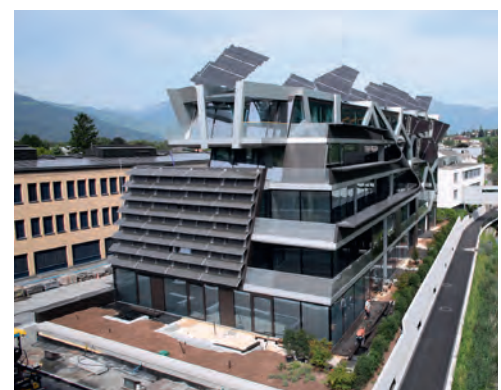
Die beweglichen Flügel der PV-Anlage des active energy buildings in Vaduz werden von einem Solar-Tracker zu höchster Effizienz gesteuert
