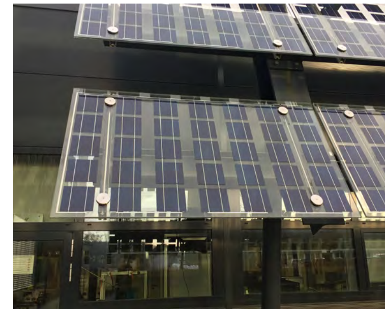
Die teilweise semitransparenten Module dienen auch als Sonnenschutz
