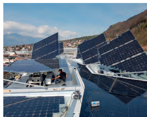
Die beweglichen Flügel der PV-Anlage des active energy buildings in Vaduz werden von einem Solar-Tracker zu höchster Effizienz gesteuert
