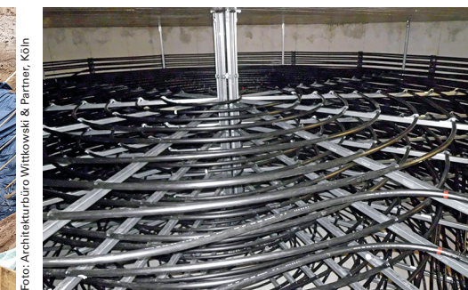
Mit Eis heizen und kühlen nutzt die Energie, die beim Aggregatswechsel von Wasser entsteht
