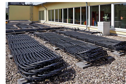
Die Absorbertechnik auf dem Flachdach dient zur Regeneration des Eisspeichers
