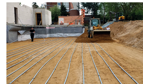
Die einzelnen Lagen wurden sorgfältig mit einer ausreichenden Kiesschicht bedeckt
