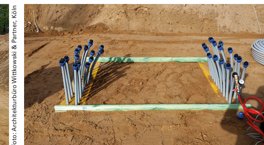
Jede einzelne Lage wurde separat abgedrückt und protokolliert
