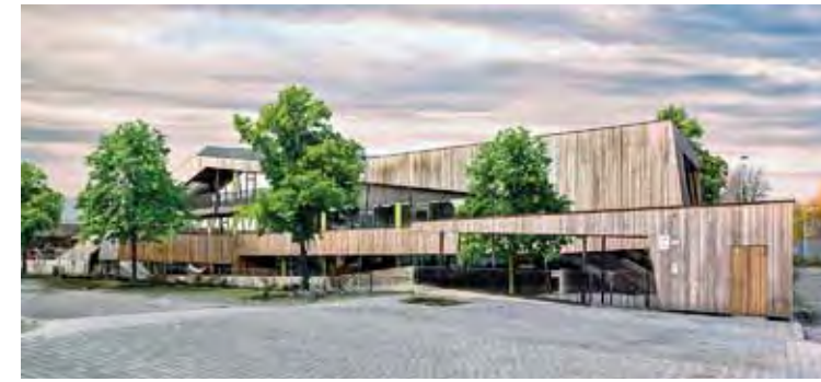
Auf der Südseite befindet sich der Eingang und der „tiefergelegte“ Spielhof vor der Balkonfassade
