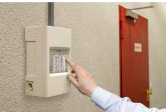
Die neuen, VdS-zertifizierten Ansaugrauchmelder-Modelle FDA221 und FDA241 von Siemens verfügen über eine patentierte Messkammer.
