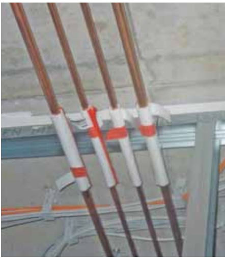
Abbildung 2: Verlegung von Rohrleitungen bzw. Kabeln im Bereich des gleitenden Deckenanschlusses
