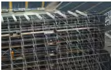
Die Videoleinwand ist auf ein 40 t schweres Stahlgerüst montiert.
