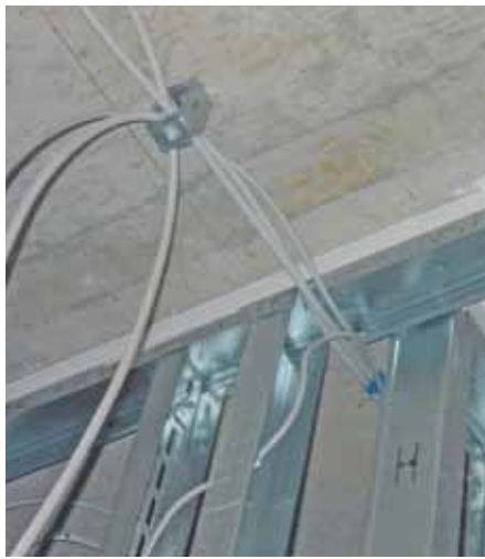
Abbildung 2: Verlegung von Rohrleitungen bzw. Kabeln im Bereich des gleitenden Deckenanschlusses
