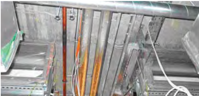
Abbildung 1: Abstände von fremden Abschottungssystemen nach den Vorgaben der MLAR
