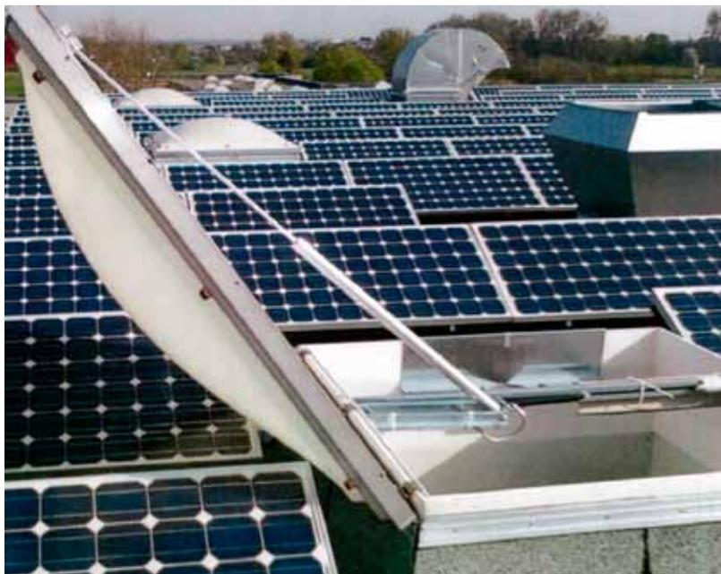
**Falsch geplante oder nachträglich installierte Solarelemente können die RWA-Funktion behindern. Daher sollte in Rücksprache mit dem Fachplaner die richtige Positionierung und Dimensionierung frühzeitig besprochen werden.**
