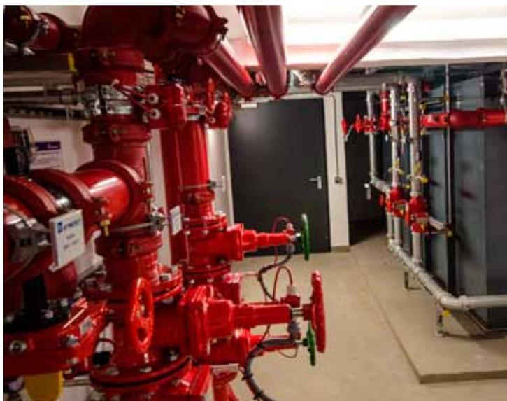
In der Sprinklerzentrale sind die Nassalarmventilstationen zusammen mit dem Wassertank und den Pumpen übersichtlich untergebracht.
