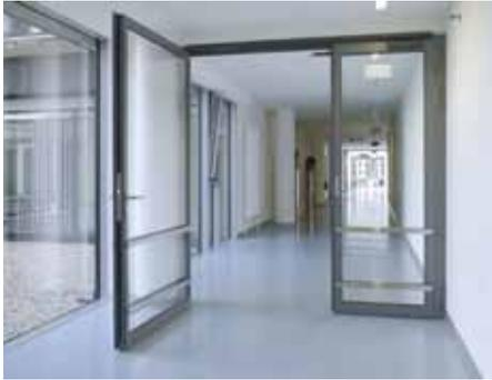
Neben Feuer- und Rauchschutztüren der Güte T/F 30 sind auch Stahl-Rohrrahmenelemente als T90-Türen und F90-Festverglasung erhältlich. Mit Ausnahme des Türdrückers werden Tür, Rahmen, Bänder und Schließmittel in einheitlicher Farbgestaltung in RAL nach Wahl angeboten. Sie sind nach DIN EN 1154 mit einem Gleitschienen-Obentürschließer auf der Bandseite ausgestattet und mit einer Antipanik-
