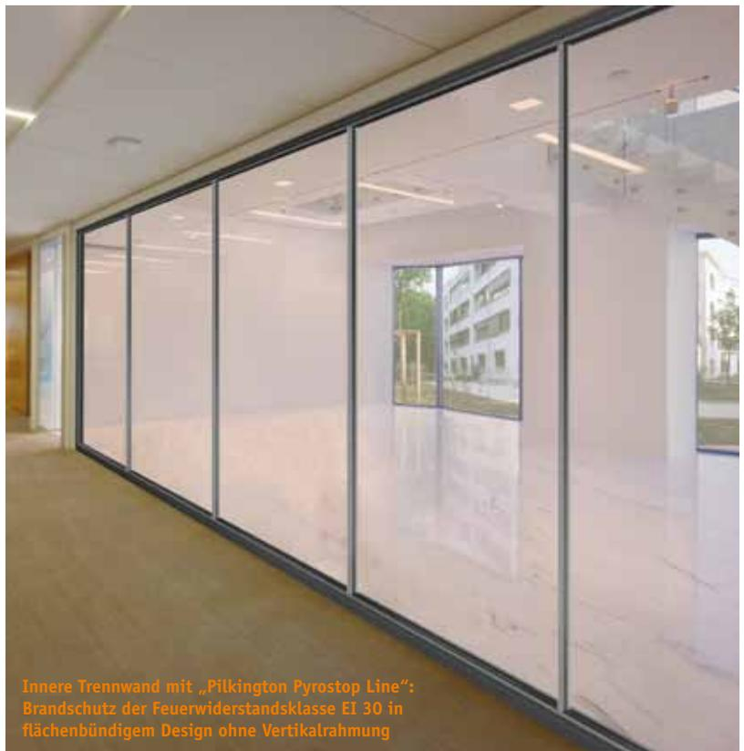
Innere Trennwand mit „Pilkington Pyrostop Line“: Brandschutz der Feuerwiderstandsklasse EI 30 in flächenbündigem Design ohne Vertikalrahmung
