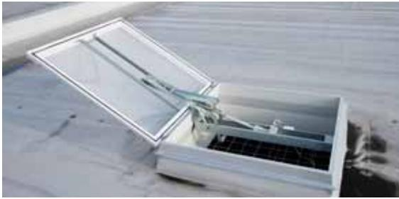
Der Schwenkbereich der nach DIN EN 12101-2 geprüften NRWG-Öffnungselemente besitzt einen Öffnungswinkel zwischen 140 und 180° und benötigt einen dementsprechend definierten Bewegungsraum.
