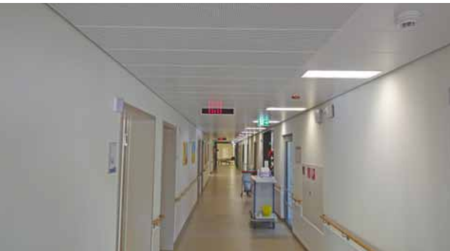
Die Sanierung des ersten Bauabschnittes ist bereits erfolgreich abgeschlossen.
