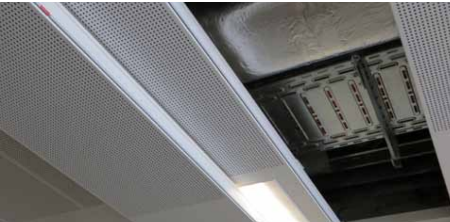
Die patentierte Senk-Schiebe-Funktion sorgt für optimalen Zugang zum Deckenhohlraum.
