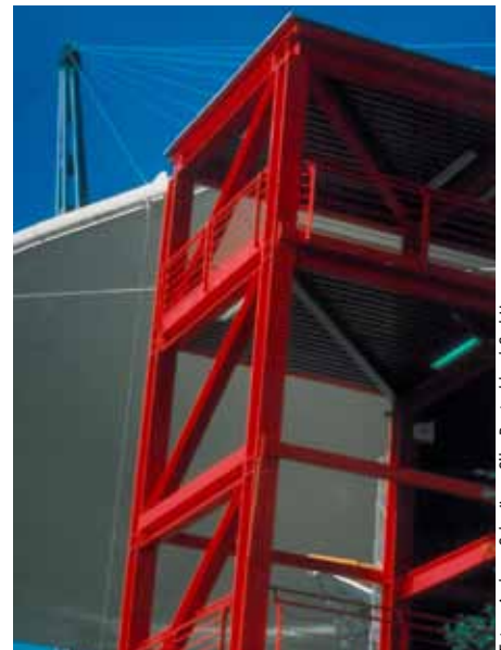
Deutscher Pavillon zur Weltausstellung in Sevilla: Dachstütze mit Brandschutzbeschichtung
