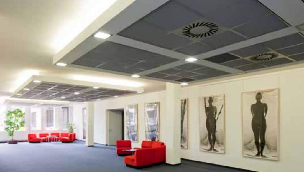
Neue Brandschutztüren und -decken in der Sendeanstalt des Deutschlandfunk.
