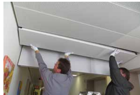
Die Lindner F30 Brandschutzunterdecken lassen sich werkzeuglos abklappen.
