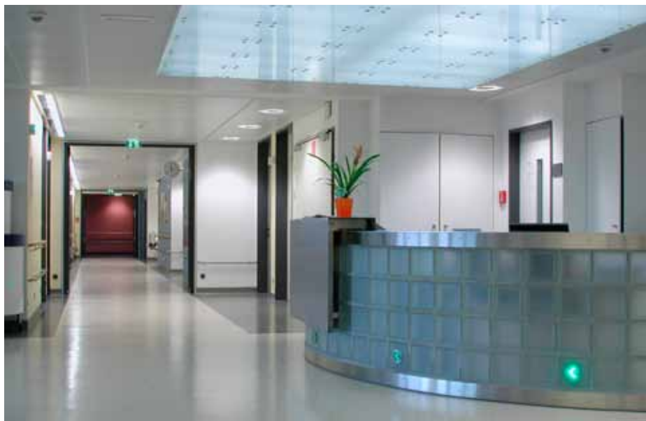
Bodennahe Leuchten mit Lauflichtfunktion (Klinikum Ettelbrück).
