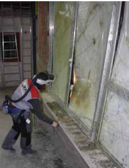
Messung mit Spaltlehre und Wattlebauschtest in der Brandschutzprüfung.
