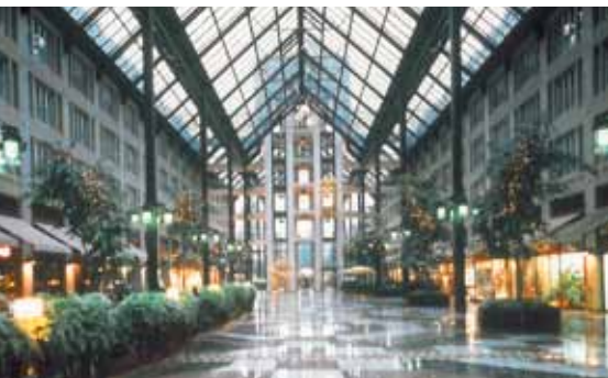
Maritim Hotel Köln: Mit Dämmschichtbildner brandgeschützte Stahlkonstruktion der Innenhofüberdachung
