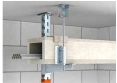
Abb. 3: E-Kanal mit PVC-isolierten Kabeln; Gewindestange als Abrutschsicherung.
