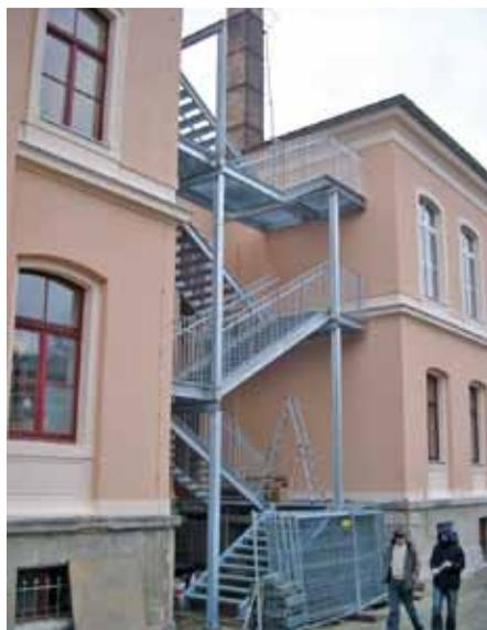
**Bild 2:** Neue Außentreppe aus Stahl, integriert zwischen zwei Gebäudeteile.
