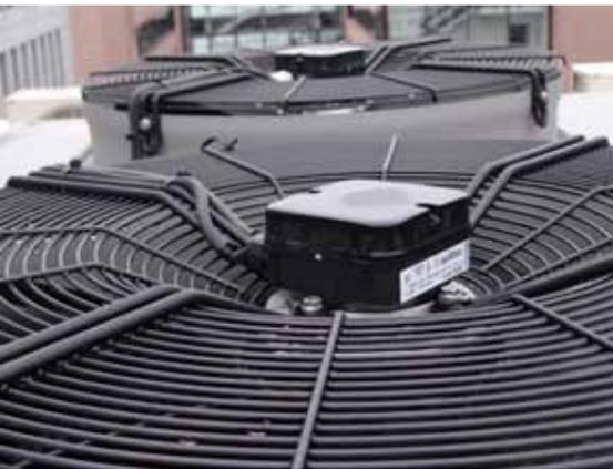
**Bilder 2a und b:** Die Kaltwassersätze kommen im Zuge der intelligenten freien Kühlung nur bei Außentemperaturen über 16 °C zum Einsatz.
