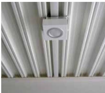
Bild 5: Geschossdeckenuntersicht: Tragbleche „Cofraplus 60P“
