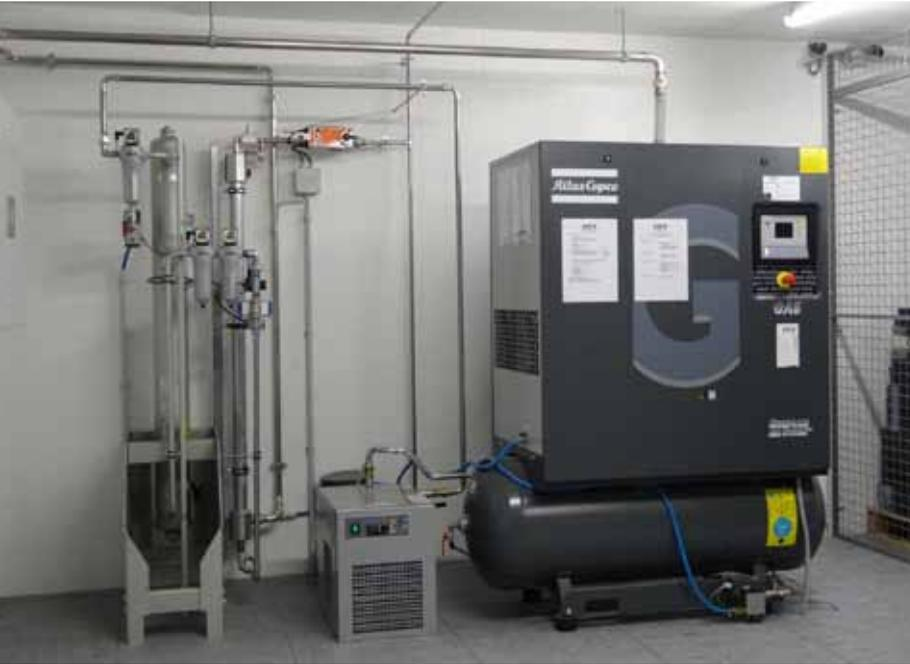
**Bild 4:** Aus dieser Maschine wird der Stickstoff in die IT-Räume gepumpt, um dort eine sauerstoffreduzierte Atmosphäre zu erzeugen.
