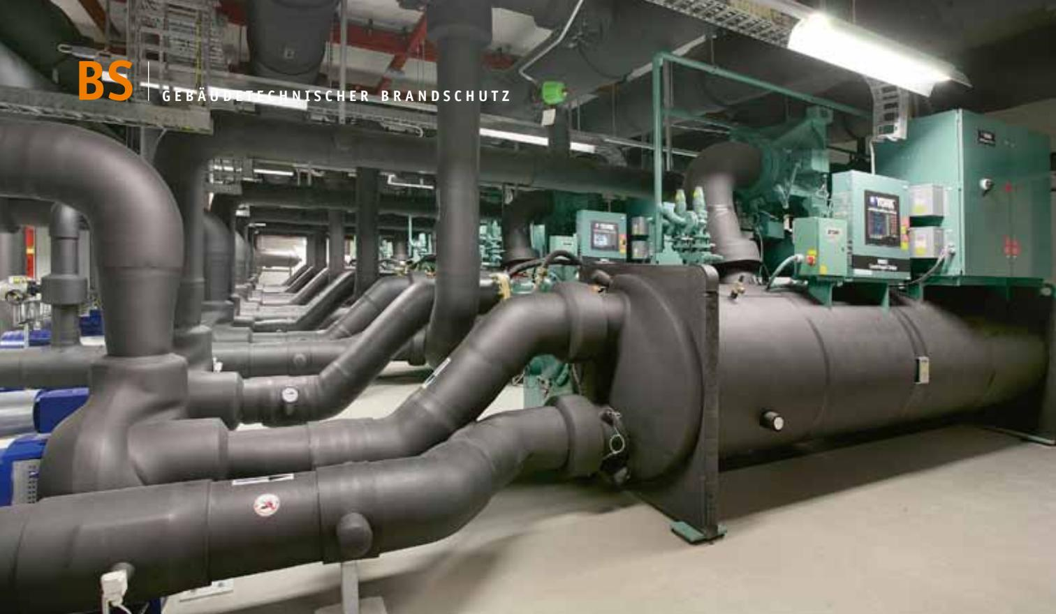
Abbildung 1: Flexible Elastomer-Dämmstoffe haben sich zur Dämmung von Rohrleitungen, Luftkanälen, Behältern, Armaturen und weiteren Anlageteilen bewährt.
