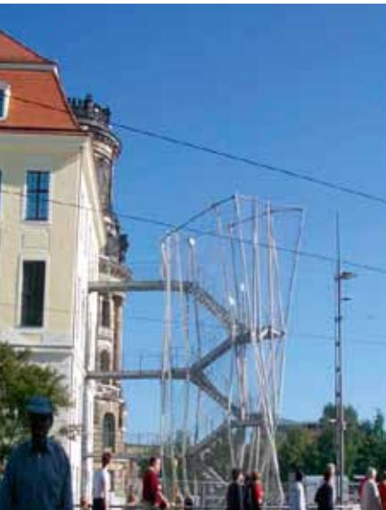
**Bild 1:** Neue Außentreppe aus Stahl, bewusst vom Gebäude abgesetzt.
