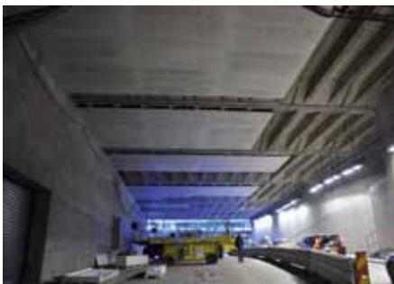
Gut zu sehen ist hier die Edelstahlunterkonstruktion. Teils wurden die Platten auch direkt auf dem Beton der Tunneldecke befestigt.
