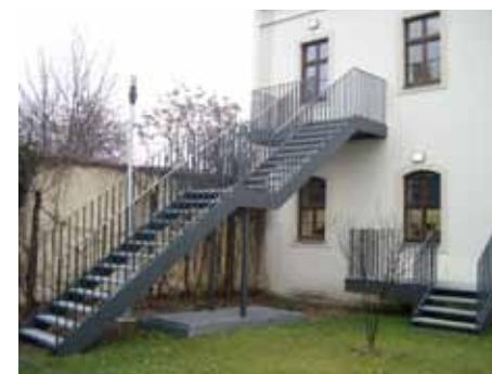
**Bild 5: Außentreppe, die durch Fenster unter dem Podest beeinträchtigt wird. Zudem fehlt ein Treppenzugang aus dem Obergeschoss.**
